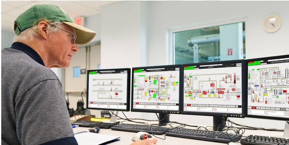
Görsel 4.1: Operatör ve Kontrol Odası
