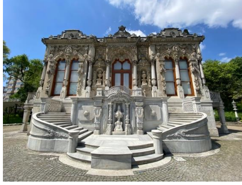
Şekil 104. Ihlamur Kasırları, Merasim Köşkü (Mabeyn Köşkü) Cephesi.
