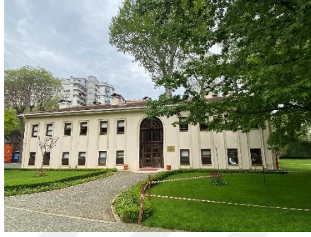
Şekil 140. Ihlamur Kasırları, Lojman Binası.
