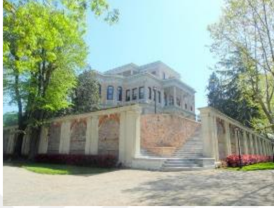
Şekil 65. Beykoz Kasrı Dış Duvarları (www.millisaraylar.gov.tr).
