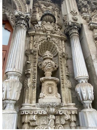
Şekil 90. Ihlamur Kasırları, Merasim Köşkü (Mabeyn Köşkü), Cephesi.
