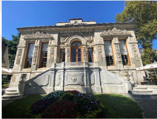
Şekil 131. İhlamur Kasırları, Maiyet Köşkü, Güney Cephe.
