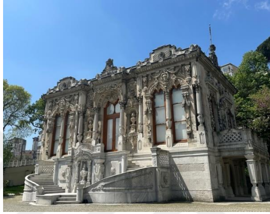
Şekil 89. Ihlamur Kasırları, Merasim Köşkü (Mabeyn Köşkü), Cephesi.
