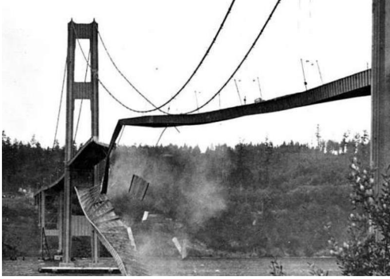
Şekil 3.2. Tacoma köprüsündeki rezonans durumu sonucu (URL-5)
