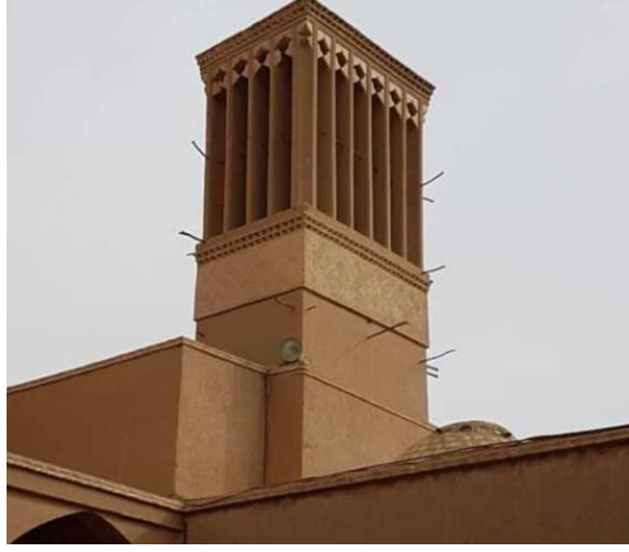
Şekil 2.24: Yazd bölgesi'nde bulunan dört yölü rüzgar kulesi [65, 115].
