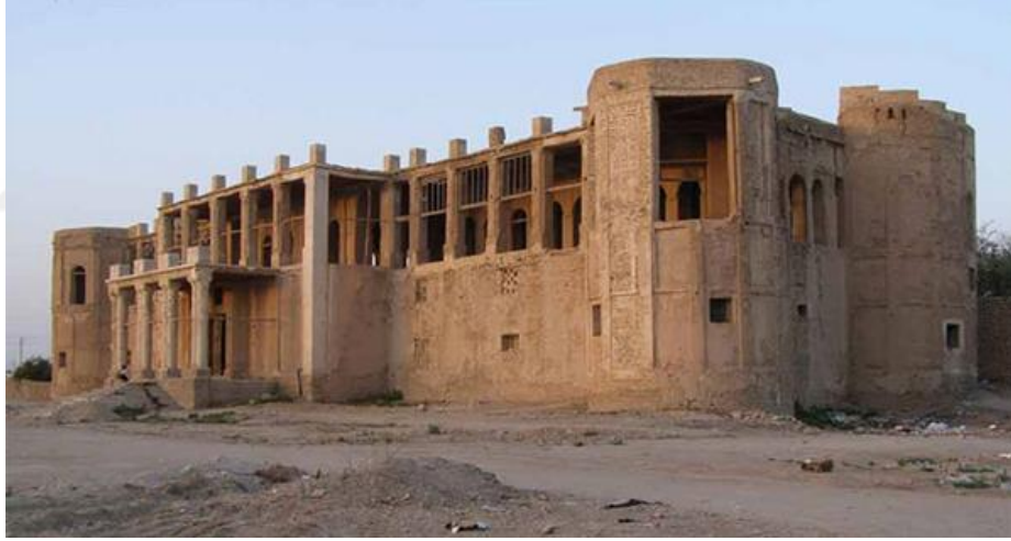
Şekil 2.7: Sıcak-nemli iklim bölgesinde yer alan yarı içe dönük ve geniş eyvana sahip olan gelenksel bina [77].
