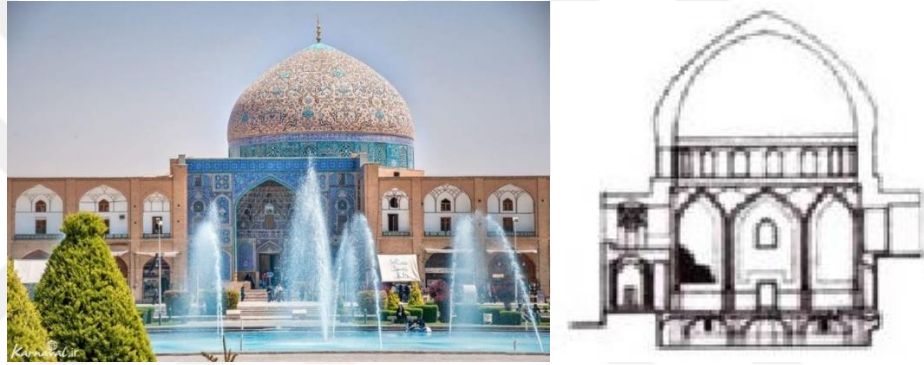
Şekil 2.54: Çift ve birbirine bağlı kabuklu kubbeye sahip olan Şeyh Lütfullah Camiisi [167, 168].
