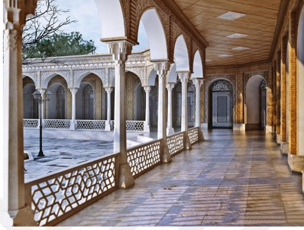
Şekil 2.45: İran'ın geleneksel binasında bulunan revak [145].
