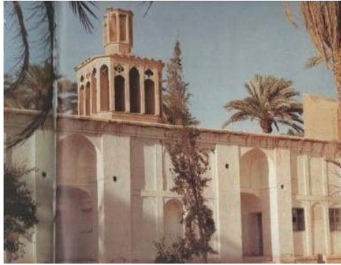
Şekil 2.22: Yezd Bölgesi'nde Tabas şehrinde yer alan Amir Köşkü'nün iki katlı ve sekiz yönlü rüzgar kulesi [64, 114].
