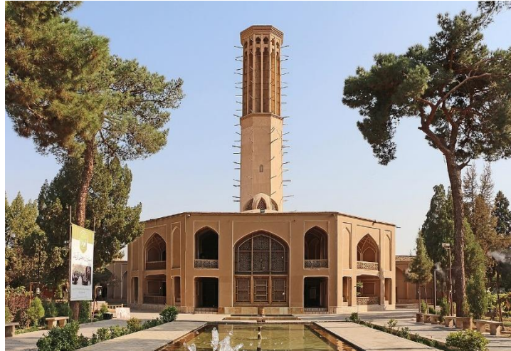
Şekil 2.25: Yazd Bölgesi'nde yer alan Dolat Abad rüzgar kulesi [110].
