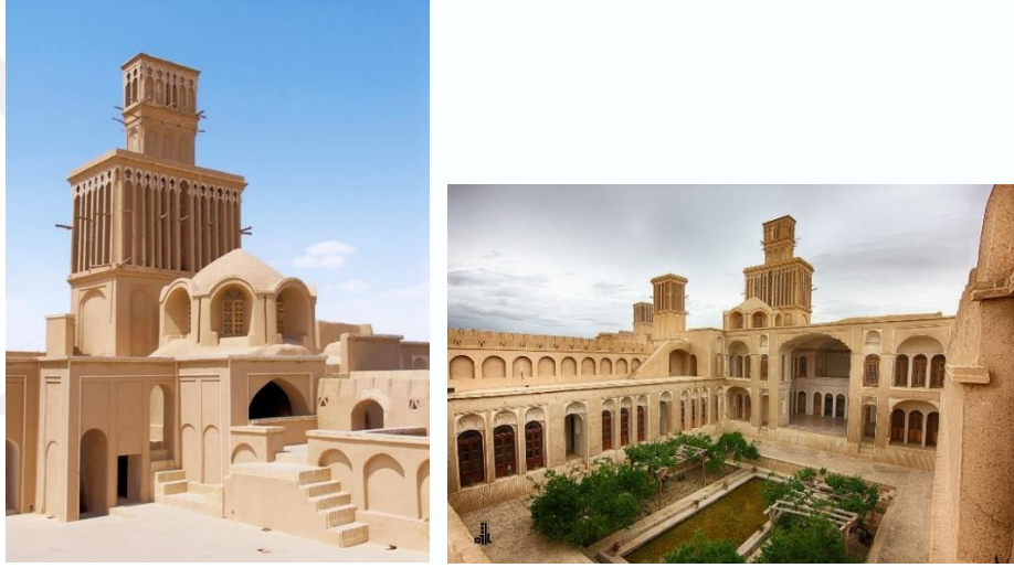
Şekil 2.21: Yezd Bölgesi'nde Abarkooh şehrinde yer alan Aghazade Köşkü'nün iki katlı ve 4 yönlü rüzgar kulesi [64, 113].
