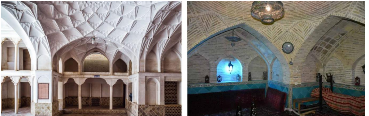
Şekil 2.39: İran'ın sıcak-kuru iklim bölgesinde yer alan serdab [138].
