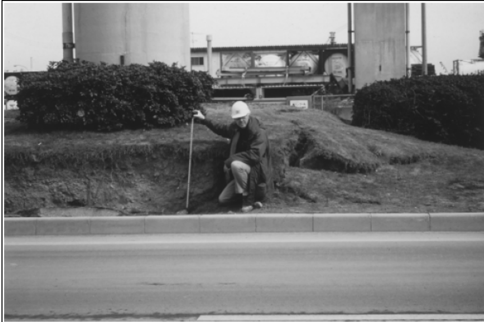
Resim 3.3. Port Island'da kazık destekli iskelenin etrafındaki zeminin sıvılaşma kaynaklı oturması, 1995 Kobe Depremi (Soga, 1998)
