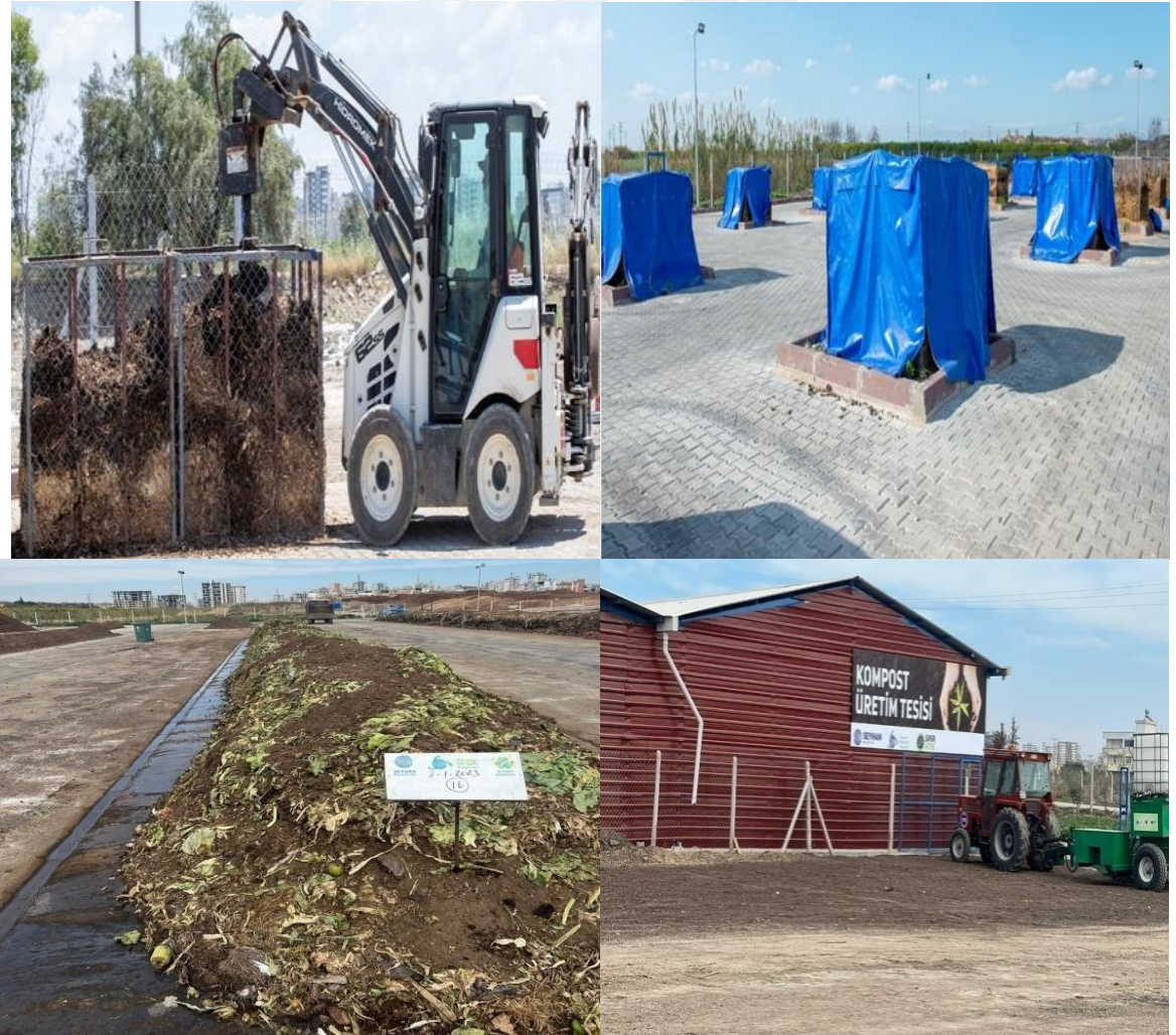
Resim 4.7. Seyhan Belediyesi Kompost Üretim Tesisi
