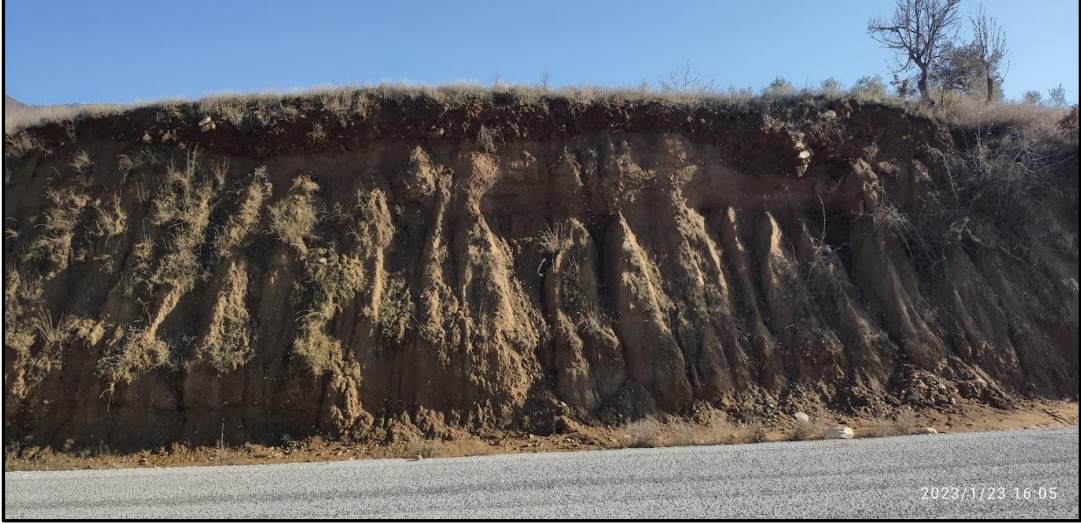
Fotoğraf 27: Küçük Menderes Havzası Ödemiş İlçesi Mevkiinde yol yarmalarında görülen çizgisel erozyon
