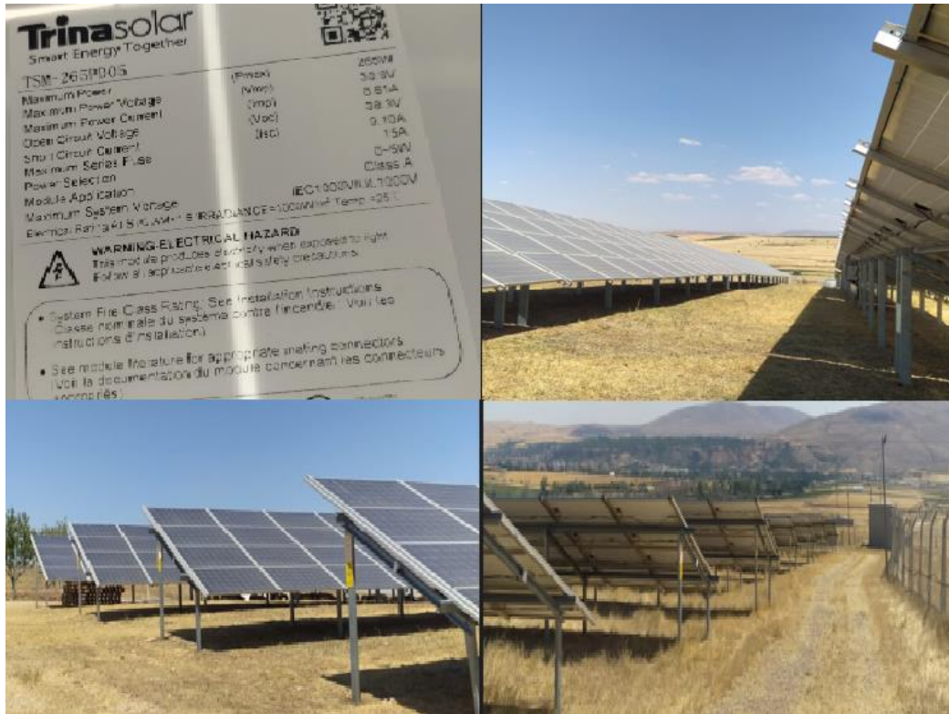
Şekil 6. GES tesisinde panellerin model özellikleri ve yerleşimi.
