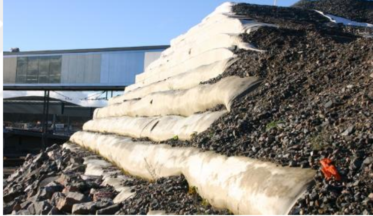
Görsel 2.6. Geotekstil Duvar İmalatı ( http-5 )
