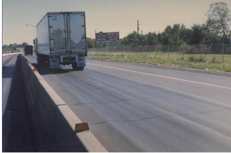
Şekil 1.25 : Tipik bir tekerlek izi bozulması örneği
