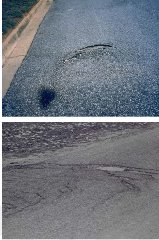
Şekil 1.29 : Farklı şiddetlerde kayma çatlağı örnekleri
