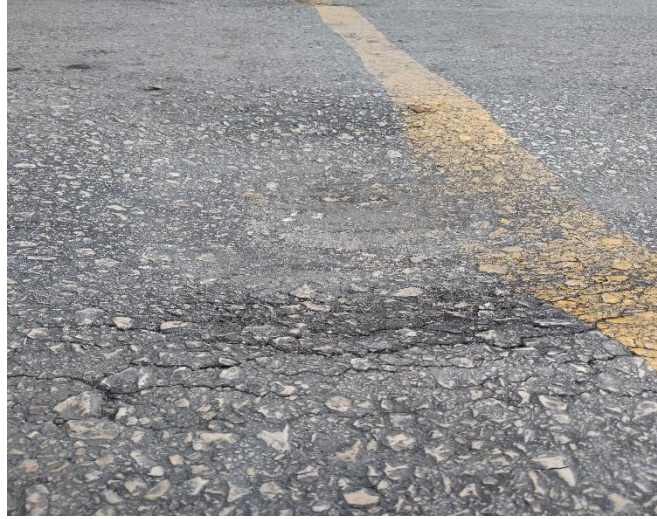
Şekil 1.6 : Yükleme hızı ve deformasyon tipleri arasındaki ilişki (Bursa Şehirlerarası Otobüs Terminali)
