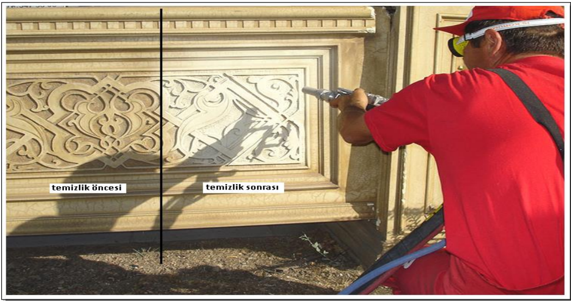
Resim 6.2. Kumlama tekniği ile yüzey temizlenmesi [56]
