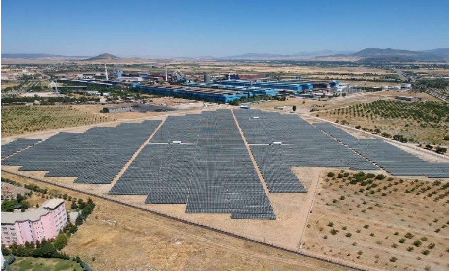
Şekil 2.2. Arazi güneş enerji santrali uygulaması
