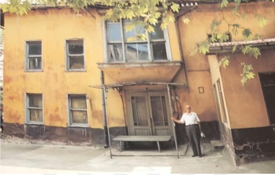
Resim 33: Restorasyon Öncesi Ön Cepheden Mayor Sinagogu 468
