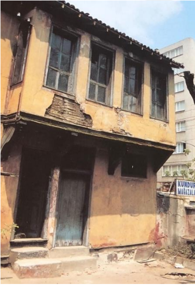
Resim 32: Restorasyon Öncesi Mayor Sinagogu 467
