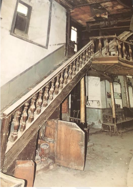
Resim 37: Mayor Sinagogu Üst Kata Çıkan Merdivenler 472
