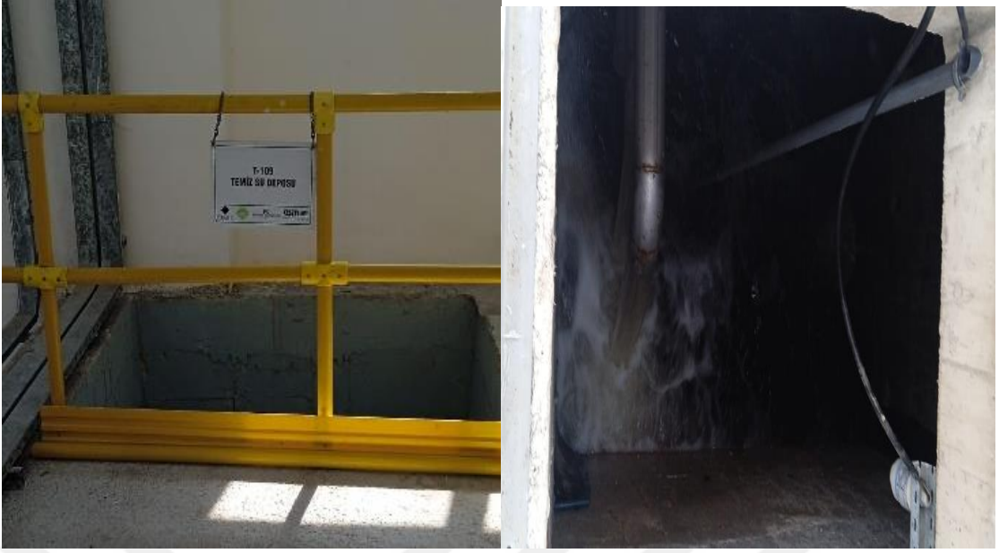
Şekil 3.14. AAT çıkışı arıtılmış atıksuların depolandığı temiz su deposu
