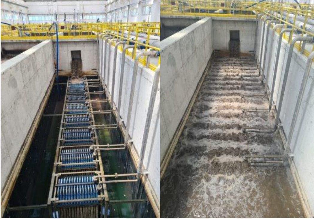
Şekil 3.12. Membranbiyoreaktör havuzları
