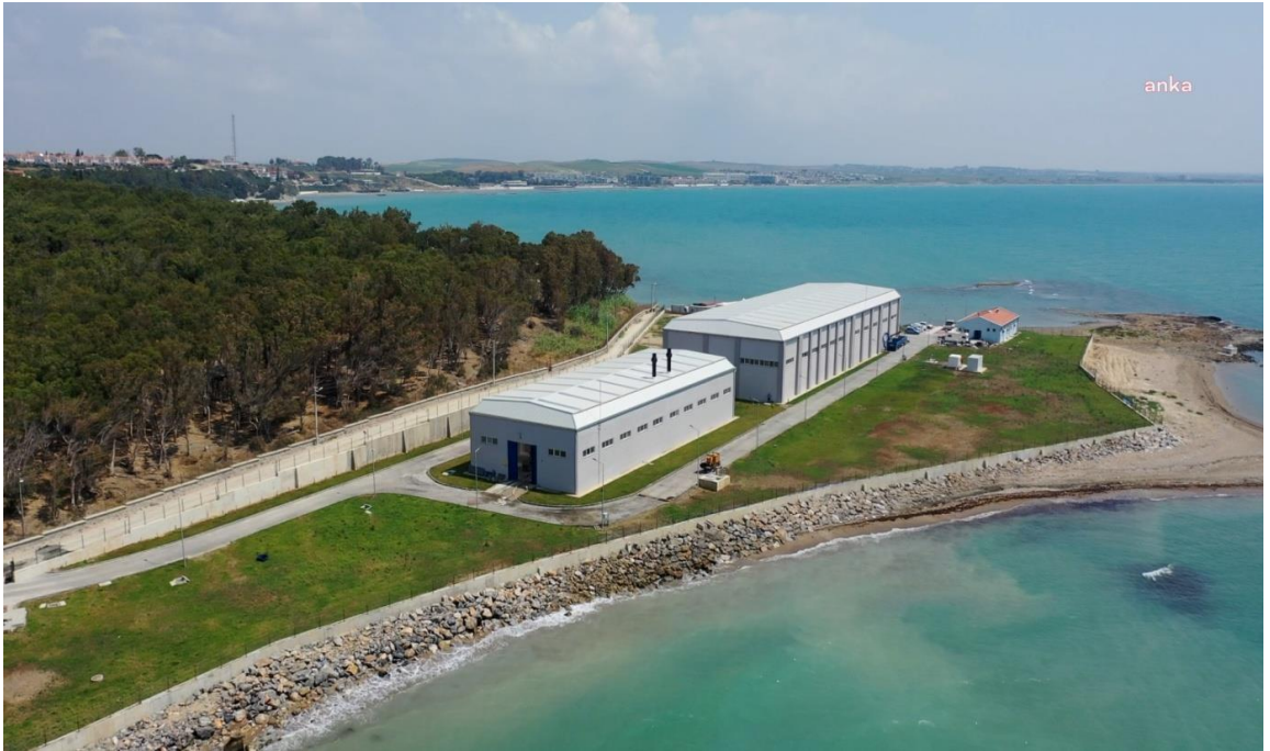
Şekil 3.3. Karataş ileri biyolojik atıksu arıtma tesisi genel görünümü
