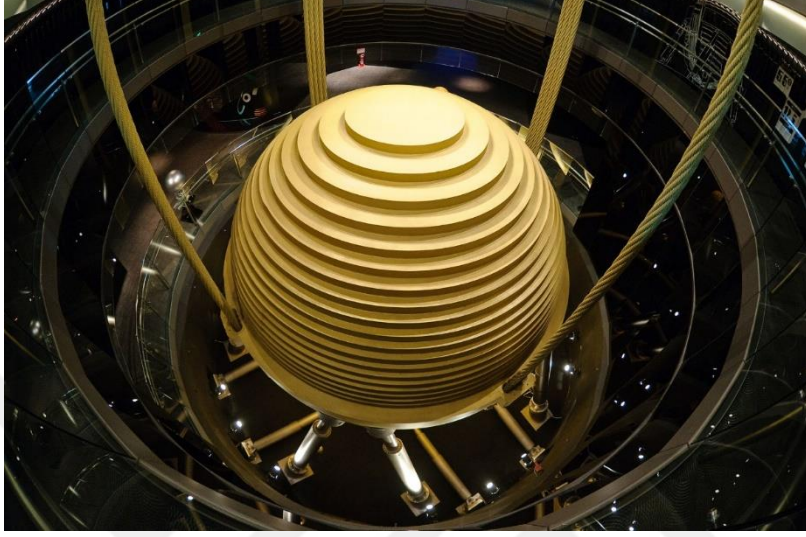
Şekil 2.16 Taipei 101'de bulunan ayarlı kütle sönümleyici
