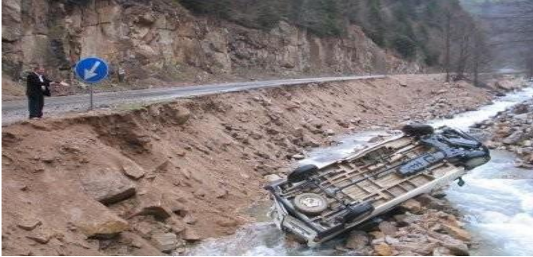
Şekil 3.4. İstinat duvarı ihtiyacı duyulan bir Geoteknik problemi
