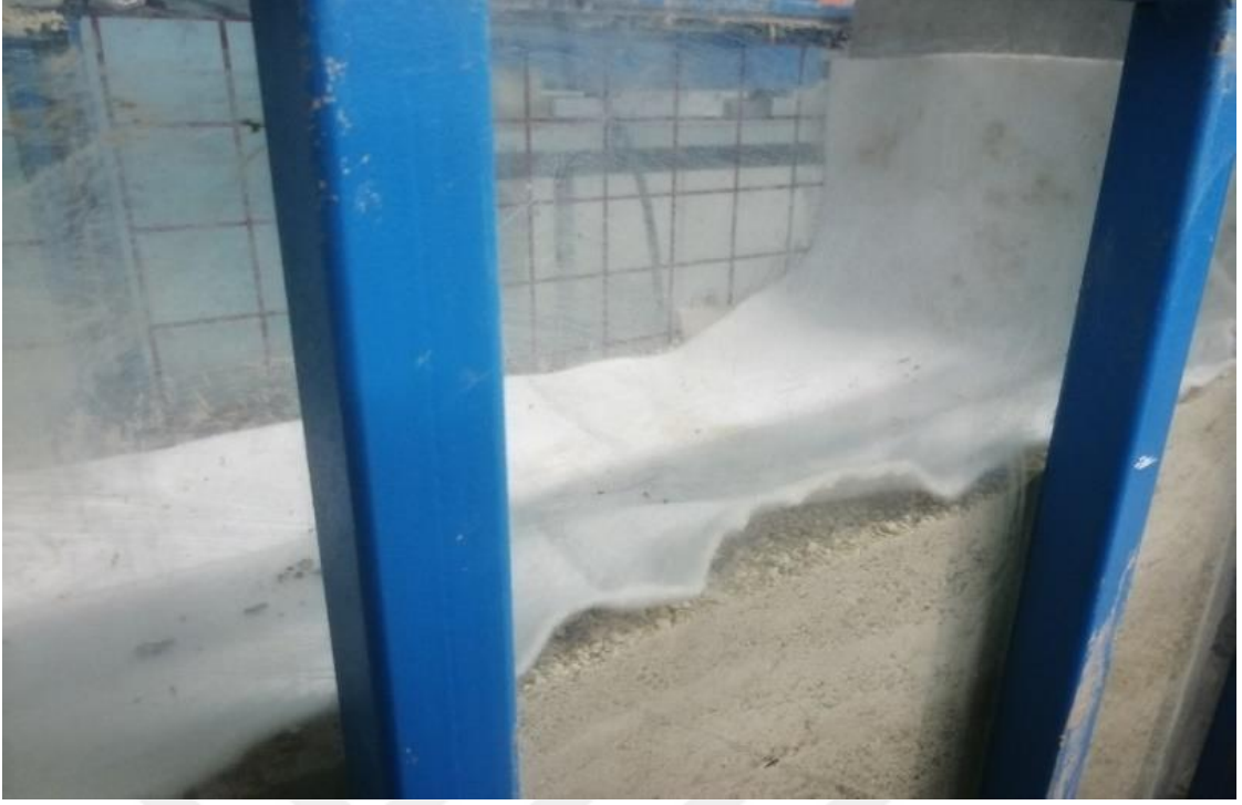
Şekil 4.22. Geotekstil tabakalarının oluşturulması ve bohçalama
