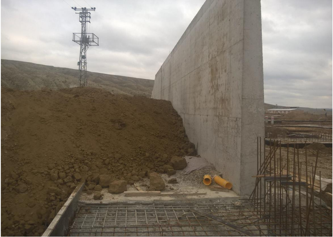
Şekil 1.1: Beton, tuğla, kiremit artıklarının istinat duvarı arka drenaj sisteminde kullanılması
