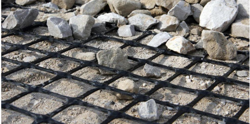
Şekil 3.50. Zeminde geogrid donatı serilmesi
