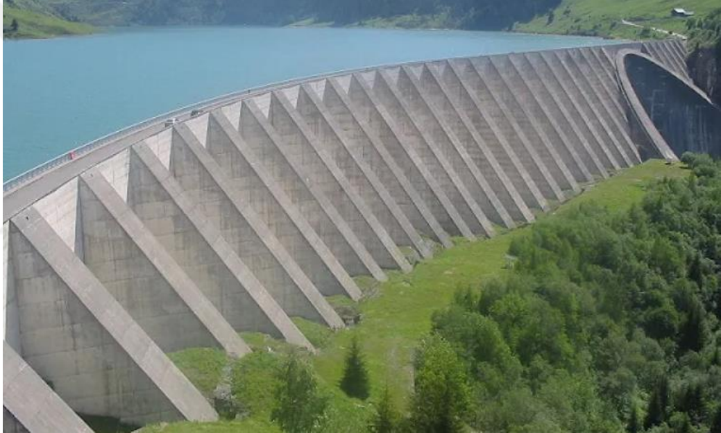
Şekil 3.19. Baraj yapımı için payandalarla güçlendirilmiş istinat duvarı yapısı
