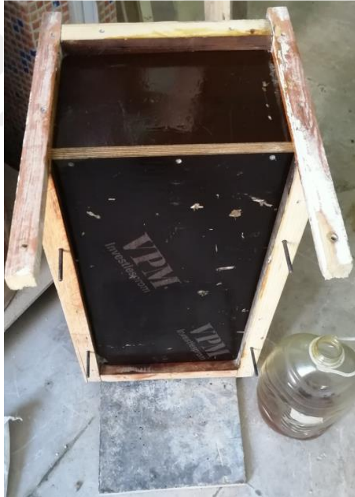
Şekil 3.76. Hazırlanan kalıpların yağlanması
