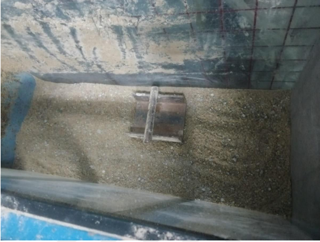
Şekil 3.97. Tank içerisinde istinat duvarı temeli altındaki sıkı kum
