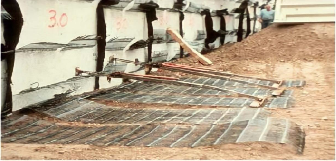
Şekil 3.46. Geotekstil donatılı istinat duvarı (Roven-Fransa, 1971)
