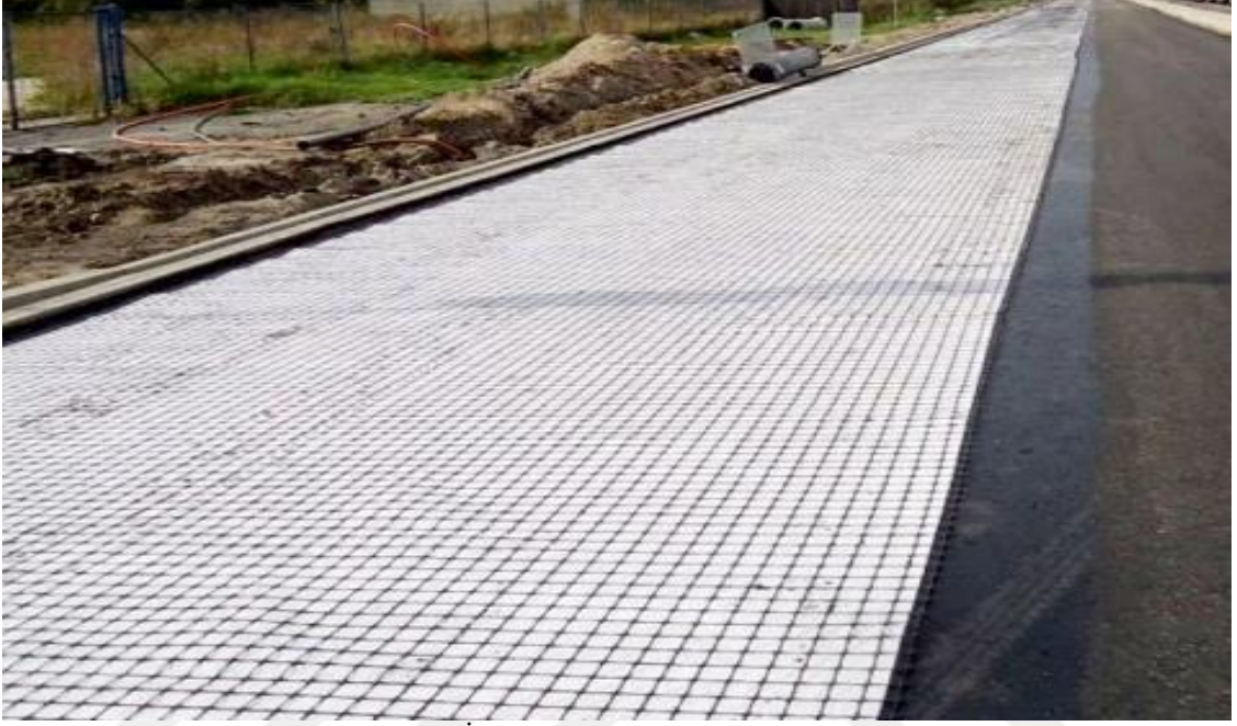
Şekil 3.53. İnşaat uygulamalarında Geokompozit kullanımı
