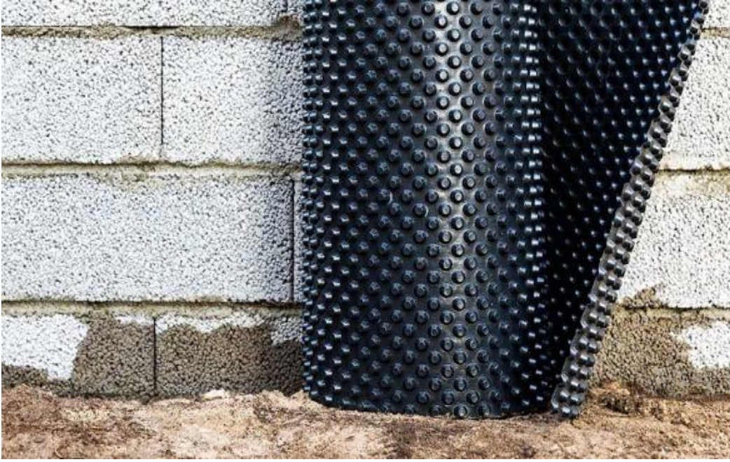
Şekil 3.42. Temel duvarında uygulanan geosentetik yalıtım
