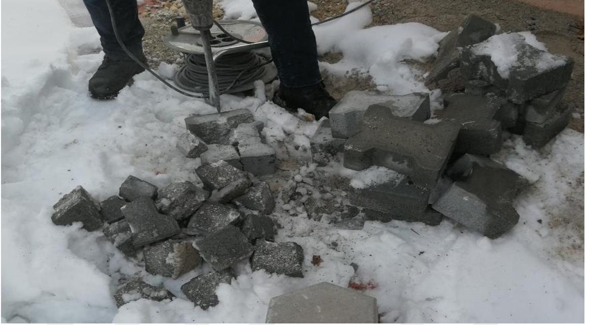
řekil 3.54. Hilti yardımıyla parke betonların paralanması
