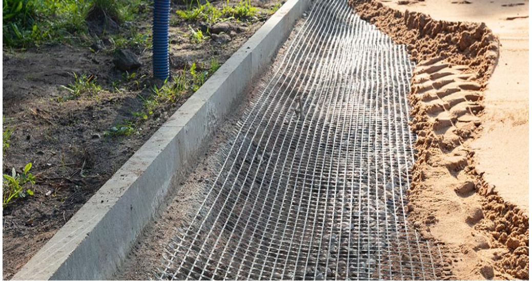
Şekil 3.48. Zeminde geogrid takviyesi
