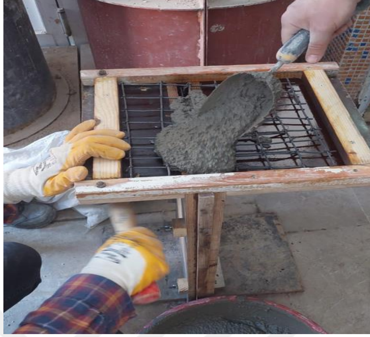
Şekil 3.81. Harcın kalıba dökülmesi
