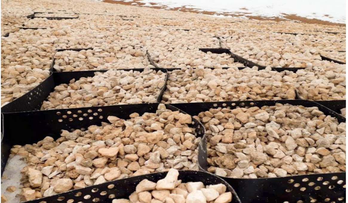
Şekil 3.52. İnşaat uygulamalarında Geocellerin kullanımı
