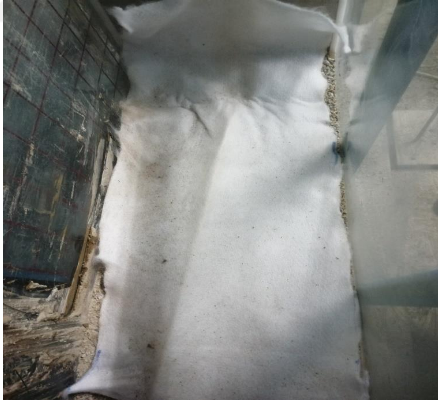
Şekil 4.21 İlk geotekstil tabakanın serilmesi (Üstten görünüş)
