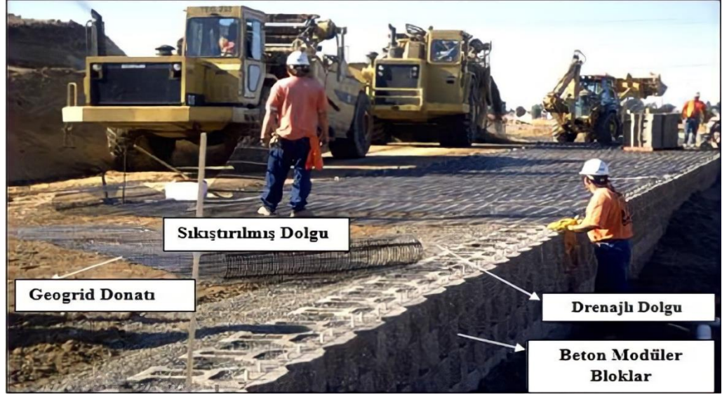
Şekil 3.49. Geogrid donatılı istinat duvarı
