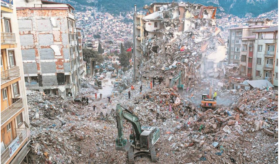
Şekil 3.1. Kahramanmaraş depremi sonrası ortaya çıkan beton atıkları (Hatay-Antakya)
