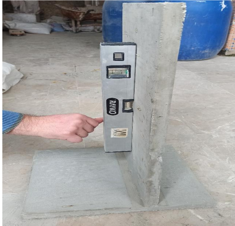
Şekil 3.88. İstinat duvarının terazisine bakılması
