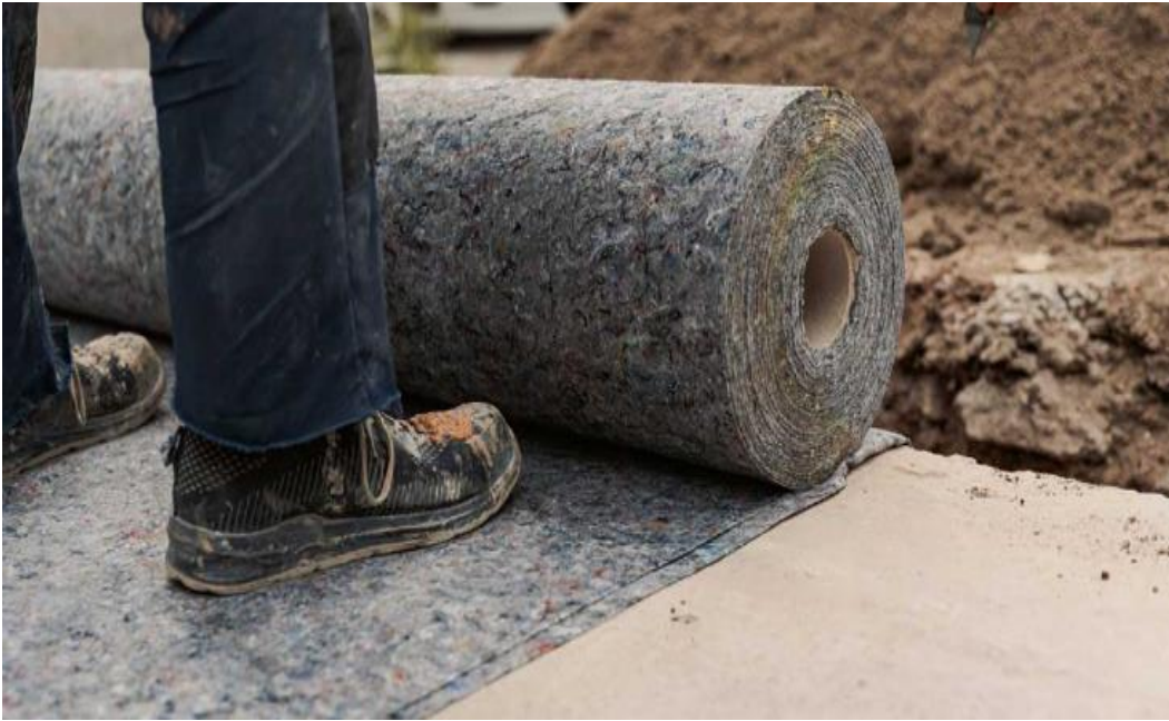
Şekil 3.43. Zemin tabakasında geosentetik uygulaması
