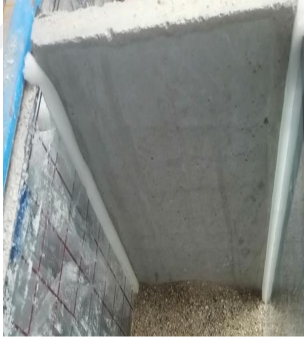
Şekil 3.93. Duvar etrafına kenar koruyucu bant çekilmesi
