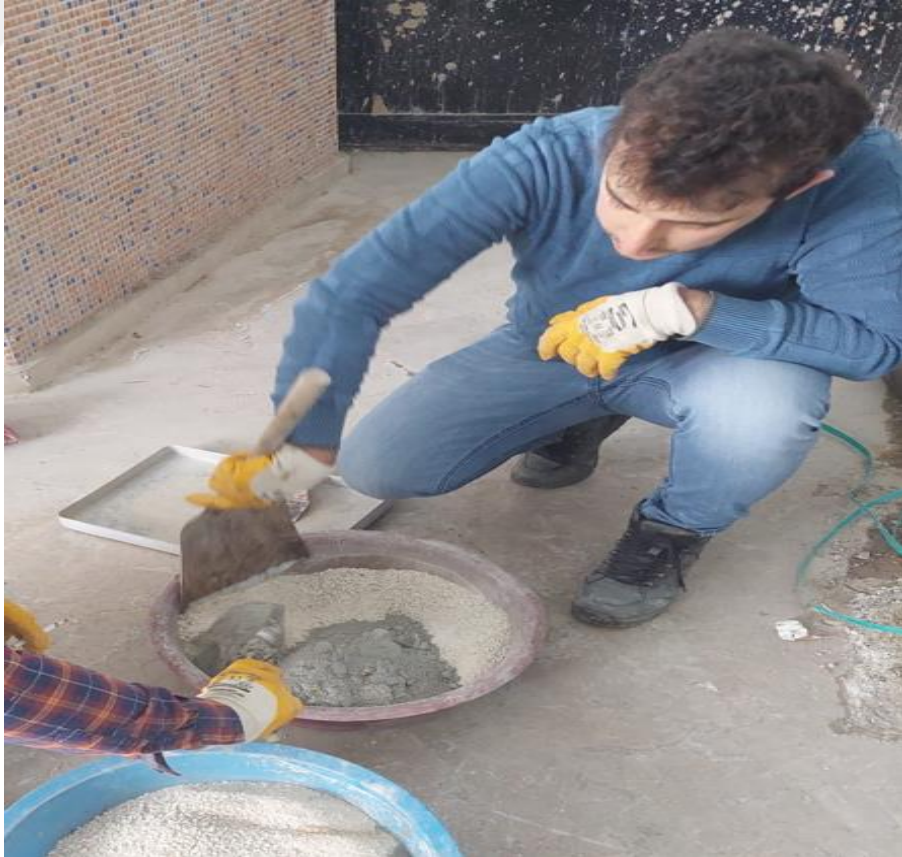
Şekil 3.80. İstinat duvarı betonu için harcın hazırlanması
