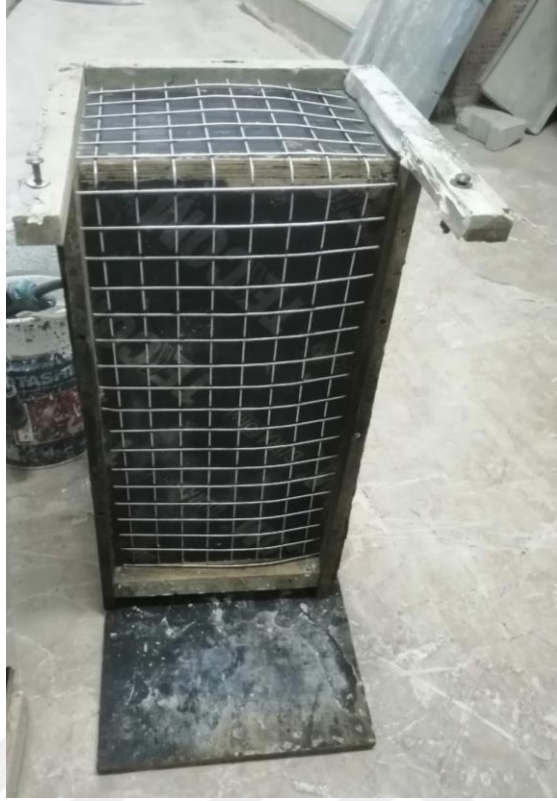
Şekil 3.77. Yağlanmış ve donatısı yerleştirilmiş duvar kalıbı
