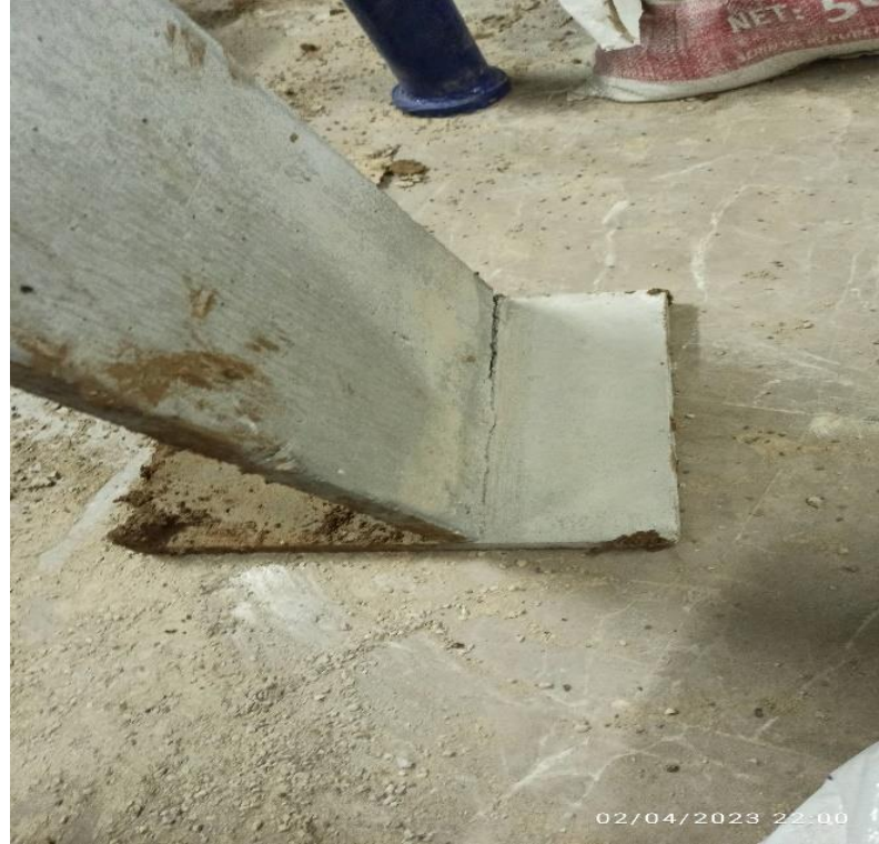
Şekil 4.27. Duvarın aşırı yükleme sonrası kırılmış hali
