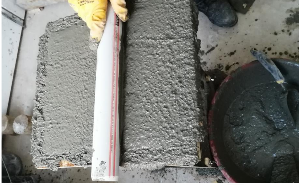
Şekil 3.83. Harcın masterlanması
