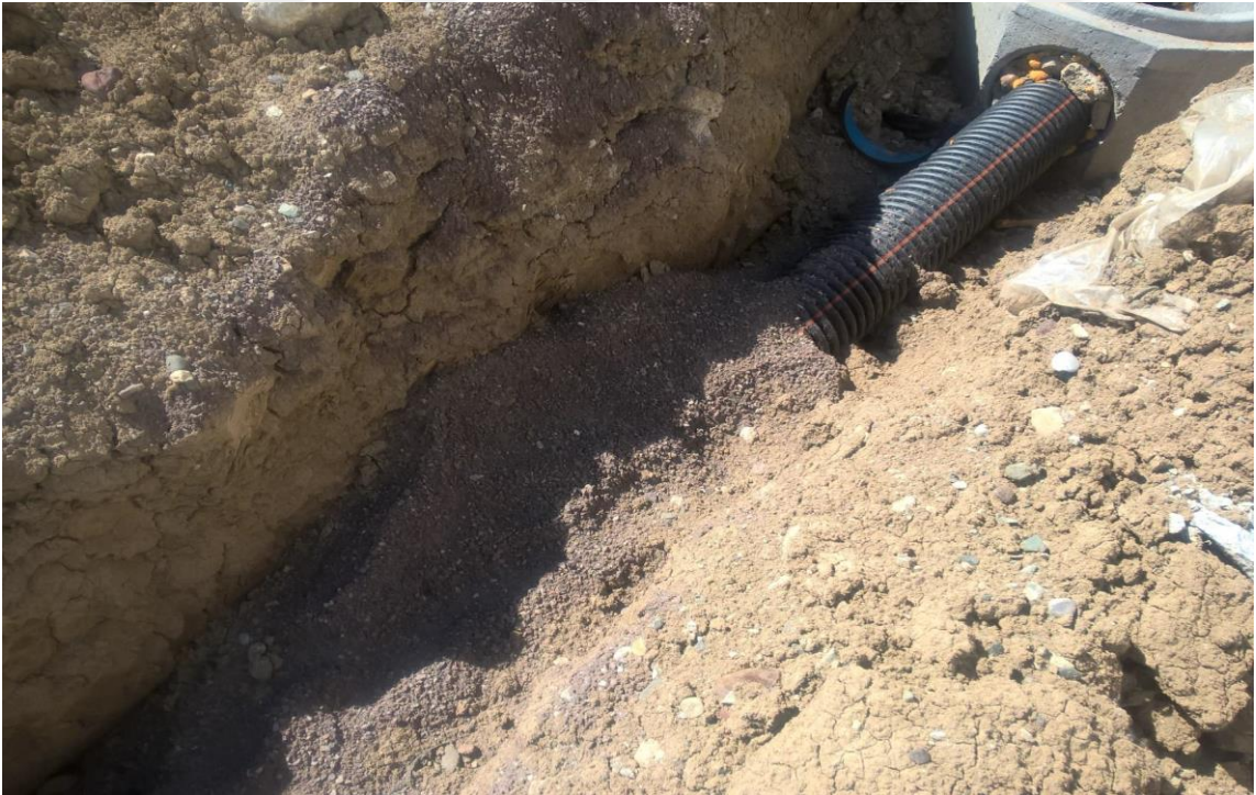
Şekil 1.2: Altyapı imalatlarında boruların yataklanması esnasında borunun sabit şekilde kalması amacıyla yıkıntı atıklarının agrega olarak kullanılması
