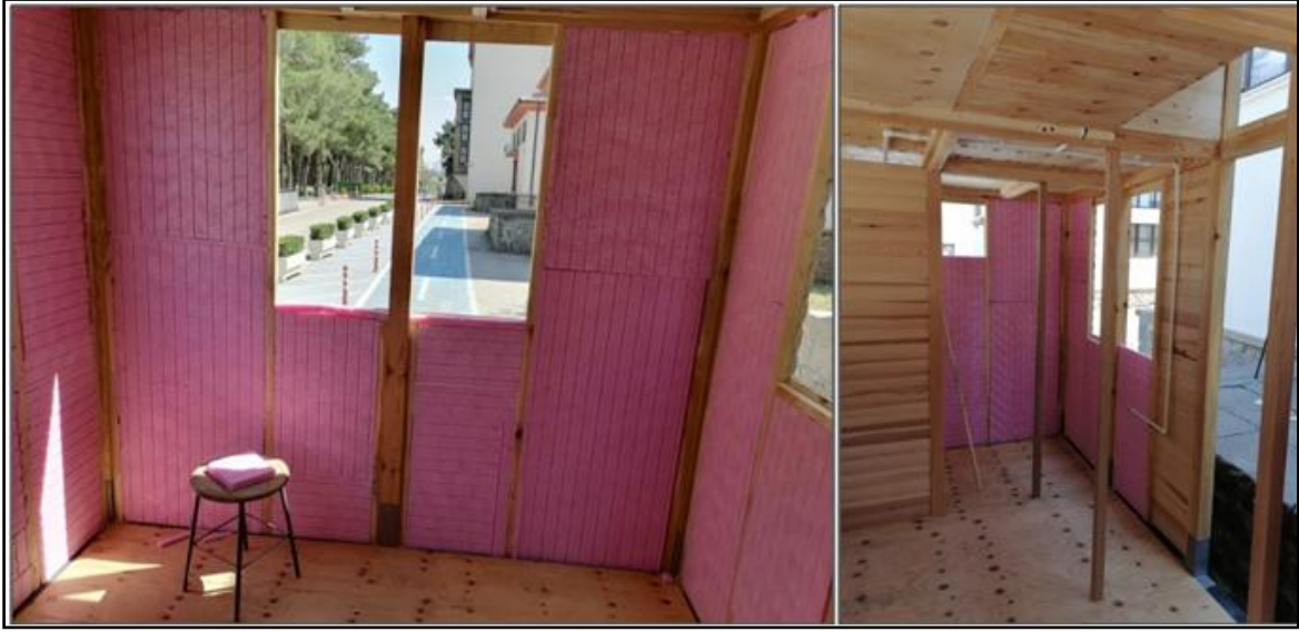
Resim 4.4. Prototip ahşap mobil evde duvar izolasyon imalat detayı
