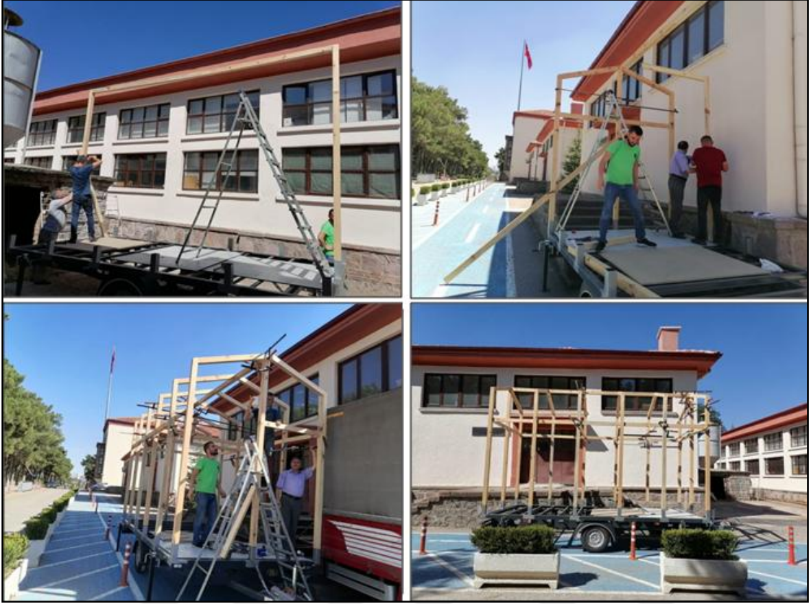
Resim 4.2. Prototip ahşap mobil ev düzlem çerçeve imalat aşaması
