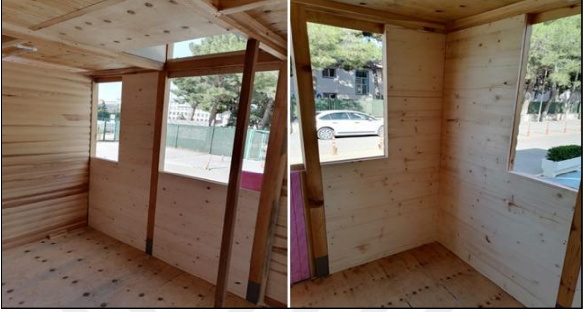
Resim 4.5. Prototip ahşap mobil evde duvar iç kabuk imalat detayı
