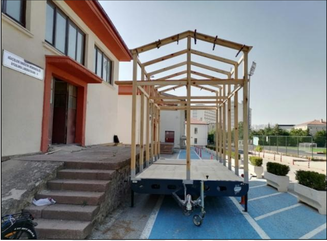
Resim 4.3. Prototip ahşap mobil ev zemin döşeme görünüşü
