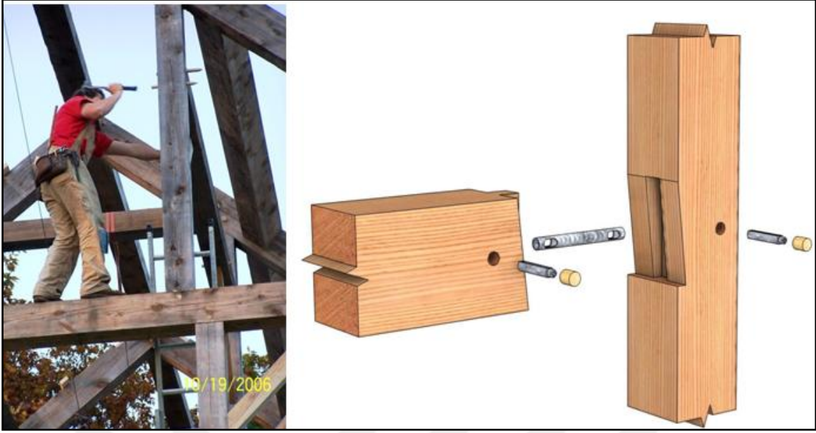
Resim 2.6. Kavelalı birleştirme örneği (URL-3).
