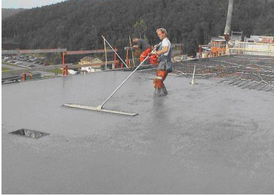
Şekil 1.5 KYB’de perdahlama
