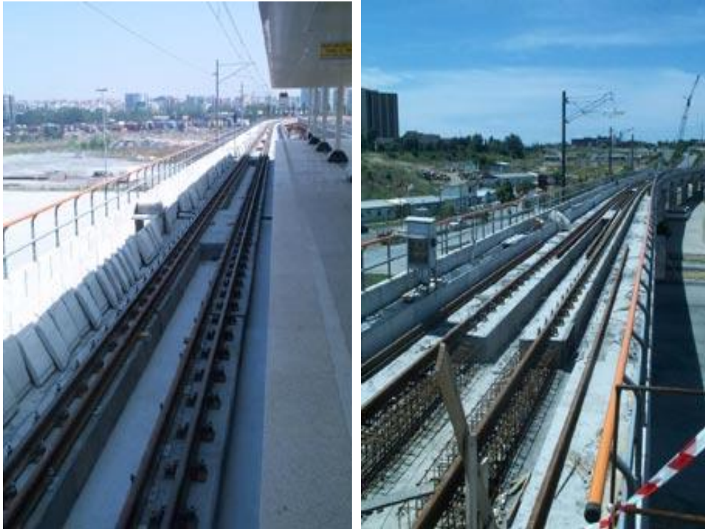
Şekil 1.6 KYB ile prekast sistem imalatı
