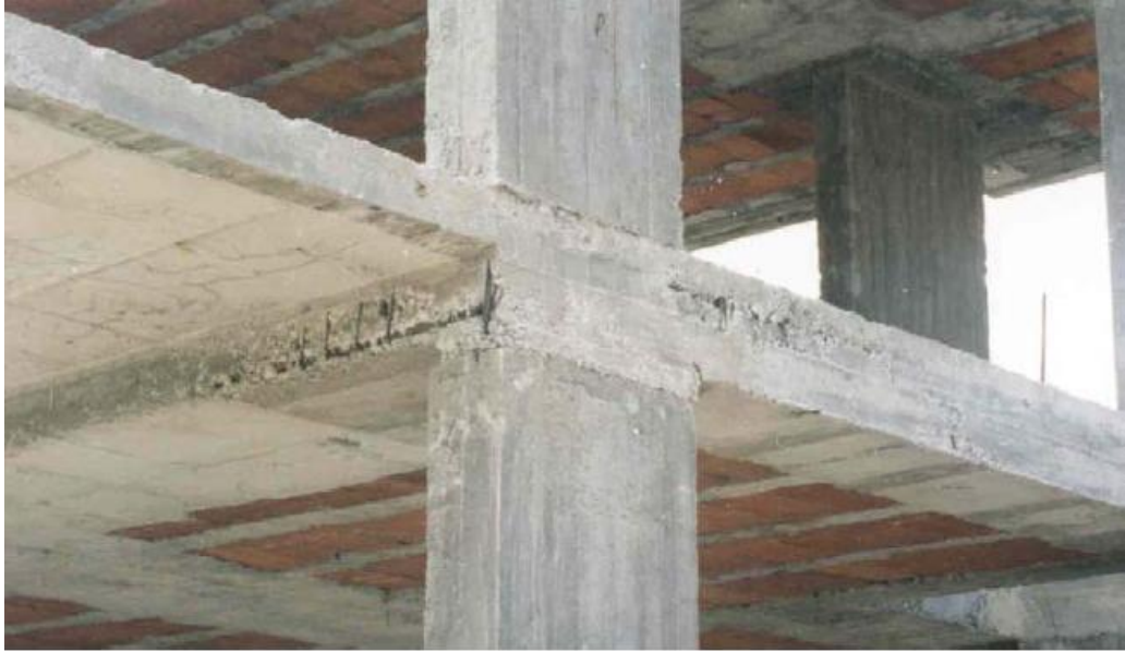
Şekil 1.2 Sıkıştırma yetersizliğinden düğüm noktasında olumsuzluklar
