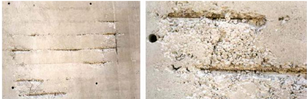
Şekil 1.3 Sıkıştırma yetersizliğinden perdelerde olumsuzluklar
