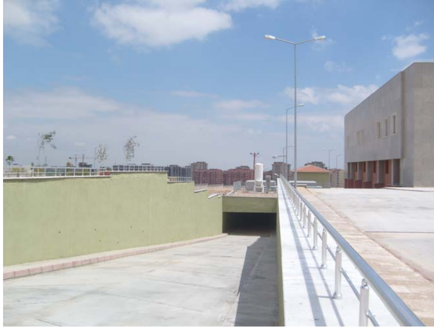
Şekil 4.7 Proje alanının kuzeyinde bulunan yer altı kapalı otopark (Orijinal 2008).
