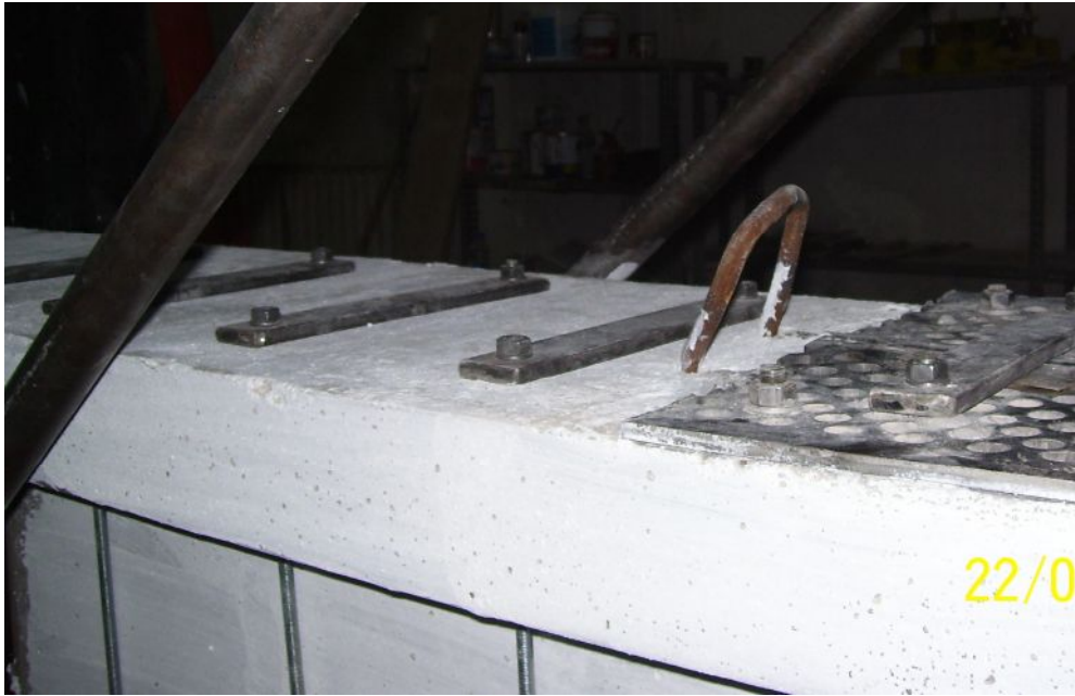
Resim 4.10. Kesmeye karşı oluşturulan güçlendirme tekniği
