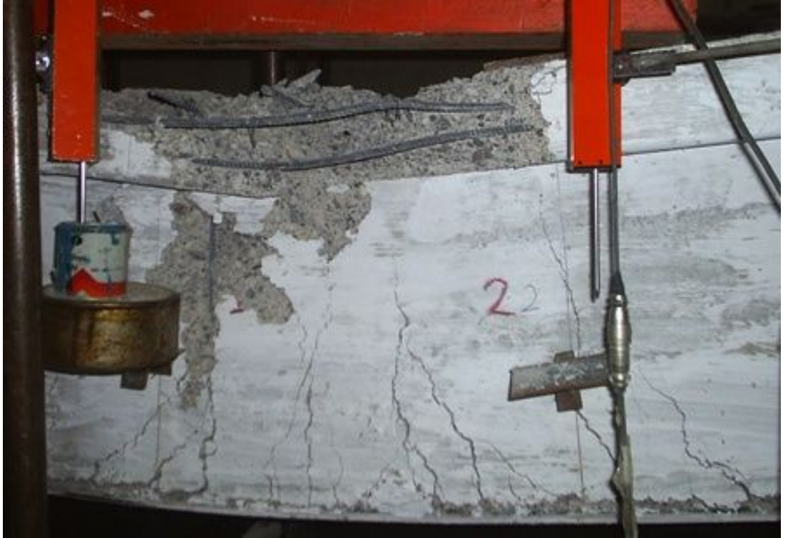
Resim 4.34. S7 deney elemanı hasarların yoğunlaştığı bölge
