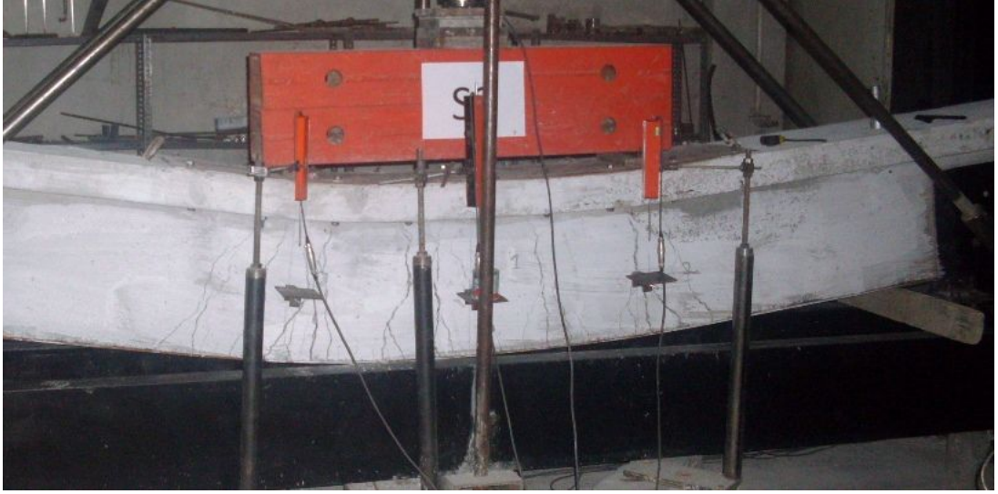
Resim 4.21. S2 elemanında görülen hasarlar
