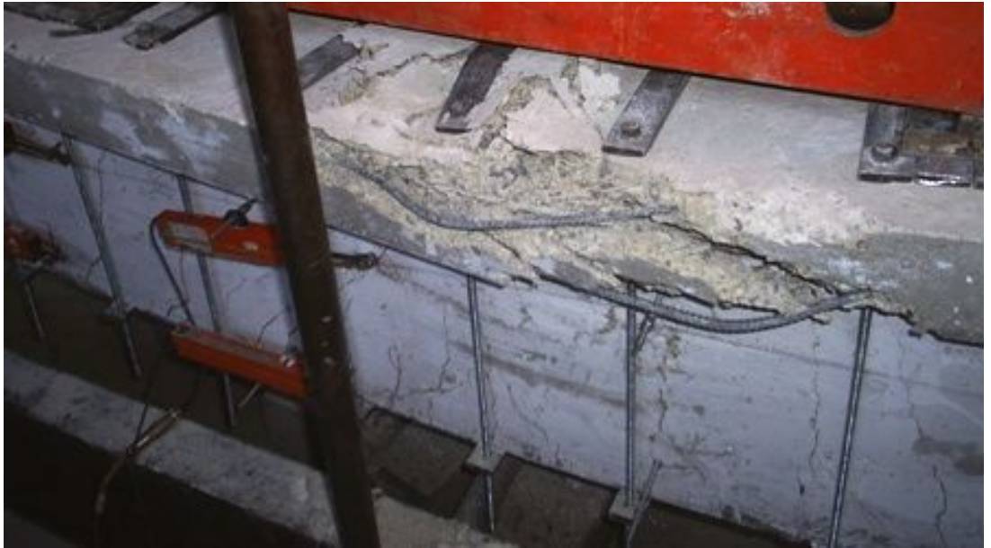
Resim 4.26.S4 deney elemanı hasarlarının yoğunlaştığı orta bölge
