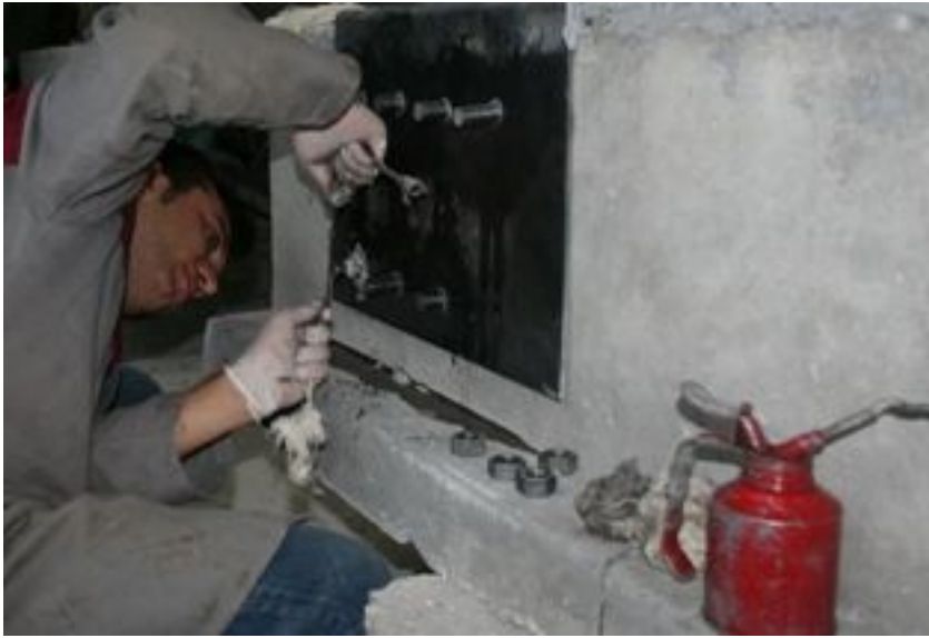
Resim 4.6.Gijon başlarının epoksi artıklarından temizlenmesi
