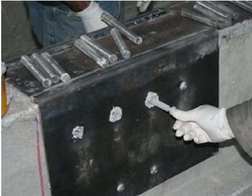
Resim 4.4. Epoksinin deliklere enjeksiyonu
