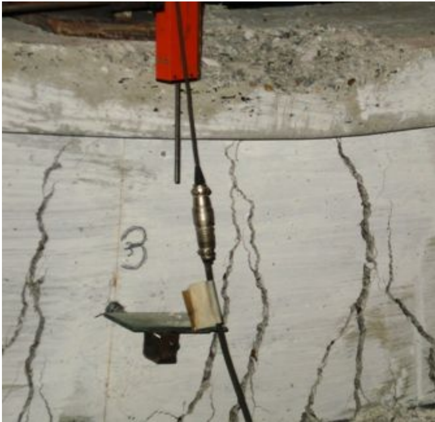
Resim 4.15.RB elemanı beton ezilme bölgesi
