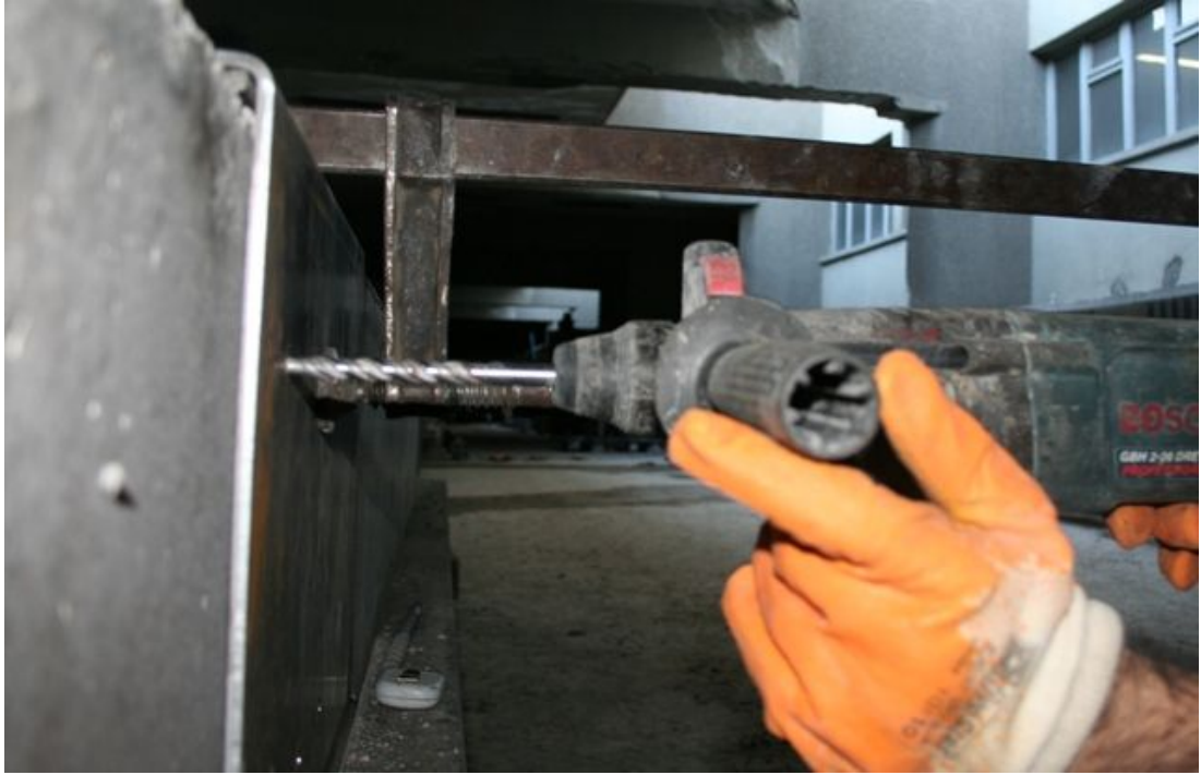
Resim 4.2. 12 mm uç ile betonda ankraj için kılavuz deliklerin açılması
