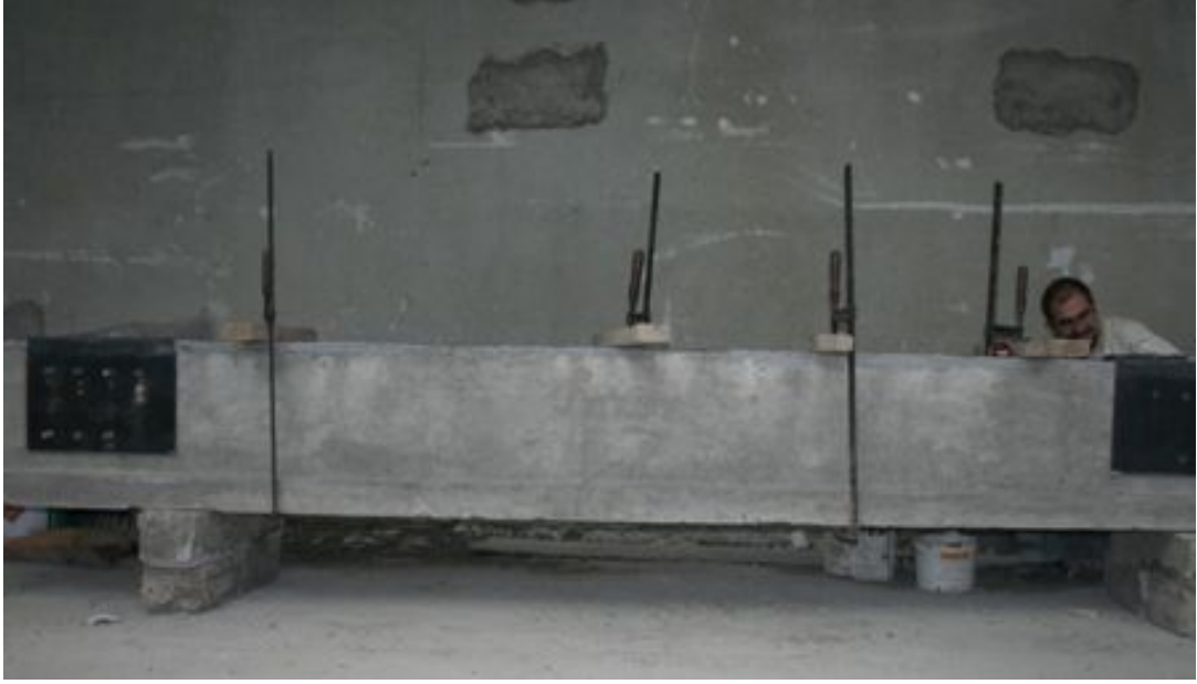
Resim 4.3. Çekme levhasının epoksi ile yapıştırıldıktan sonra işkencelerle desteklenmesi
