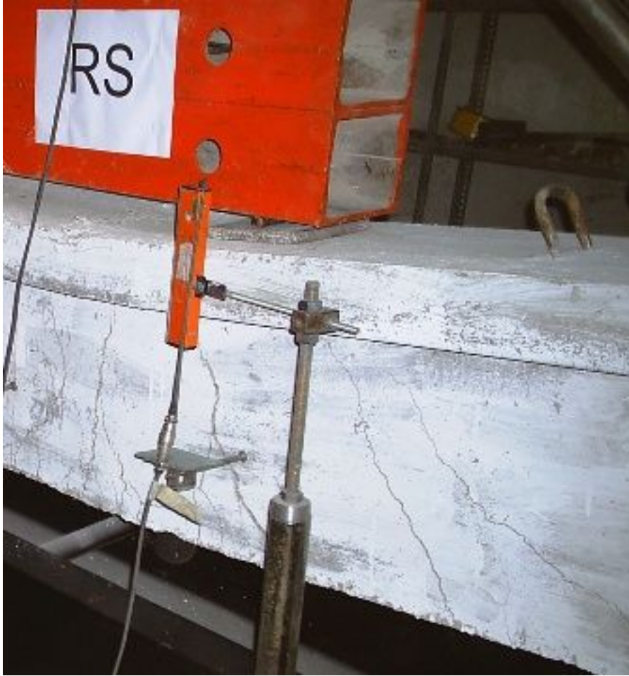
Resim 4.17. RS elemanında görülen çatlaklar
