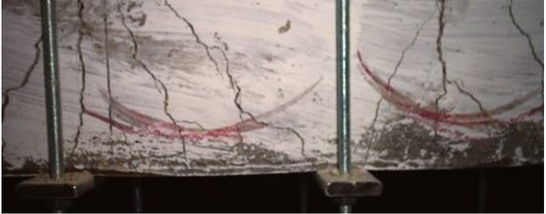
Resim 4.27.Çekme levhasında oluşan yay şeklinde deformasyon
