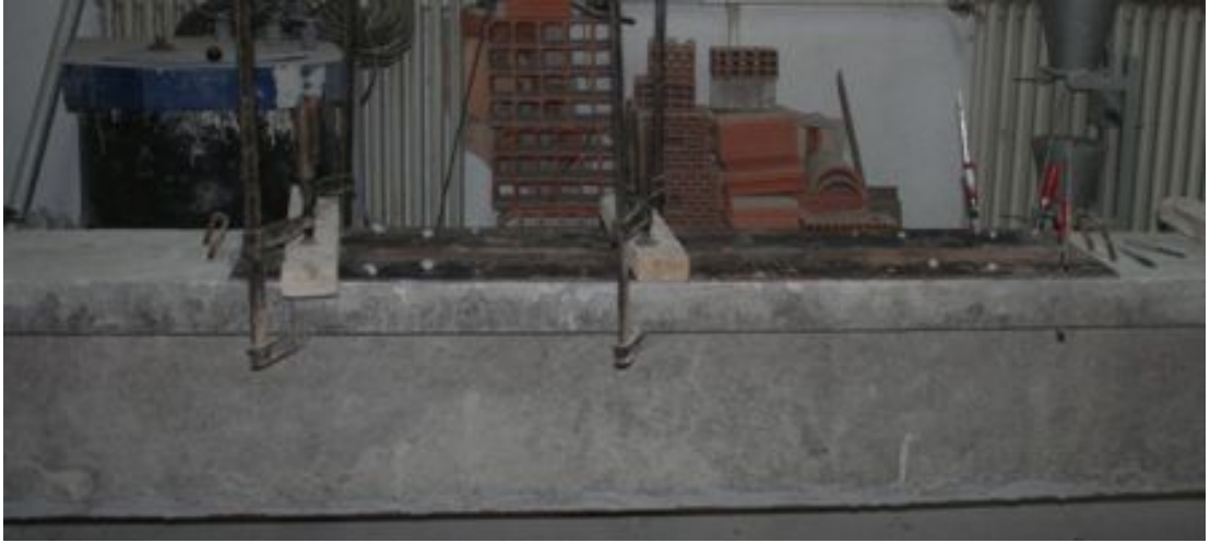
Resim 4.9. Basınç levhasının yapıştırılmış ve desteklenmiş hali
