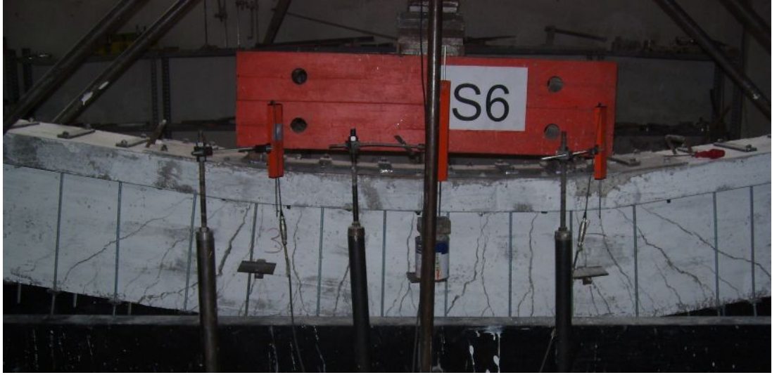
Resim 4.32. S6 deney elemanı hasarları genel görünüm
