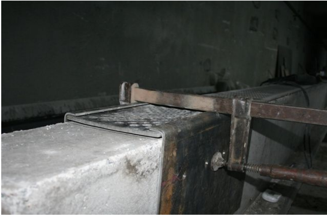
Resim 4.1.Uç yan levhalar işkence ile sabitlenmiştir
