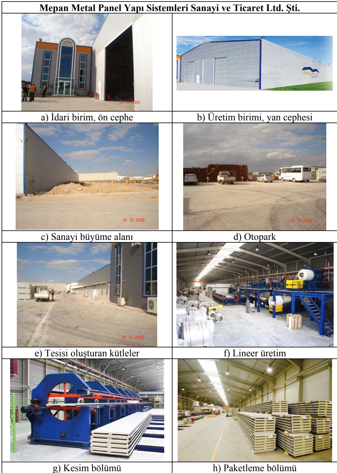
Resim 4.4, Mepan Metal Panel Yapı Sistemleri Sanayi iç ve dış fotoğrafları
