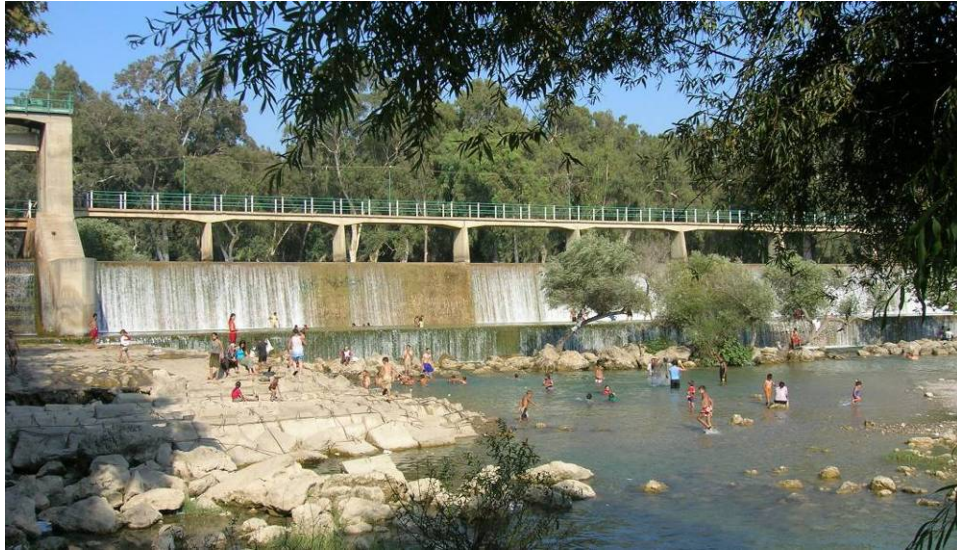
Foto 1.36. Tarsus Barajı Regülatörü. Tarsus Çayı'nın Sularının Tarsus Şehri İçerisine ve Yakın Çevresine Su Sağlamak Üzere Yapılmıştır.
