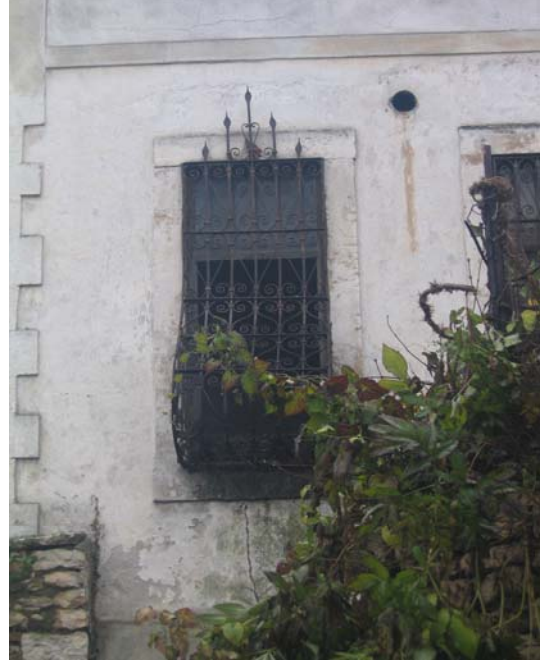
Resim 3.31.-3.32. Zemin kat pencerelerinin taş söveleri ve demir parmaklıkları
