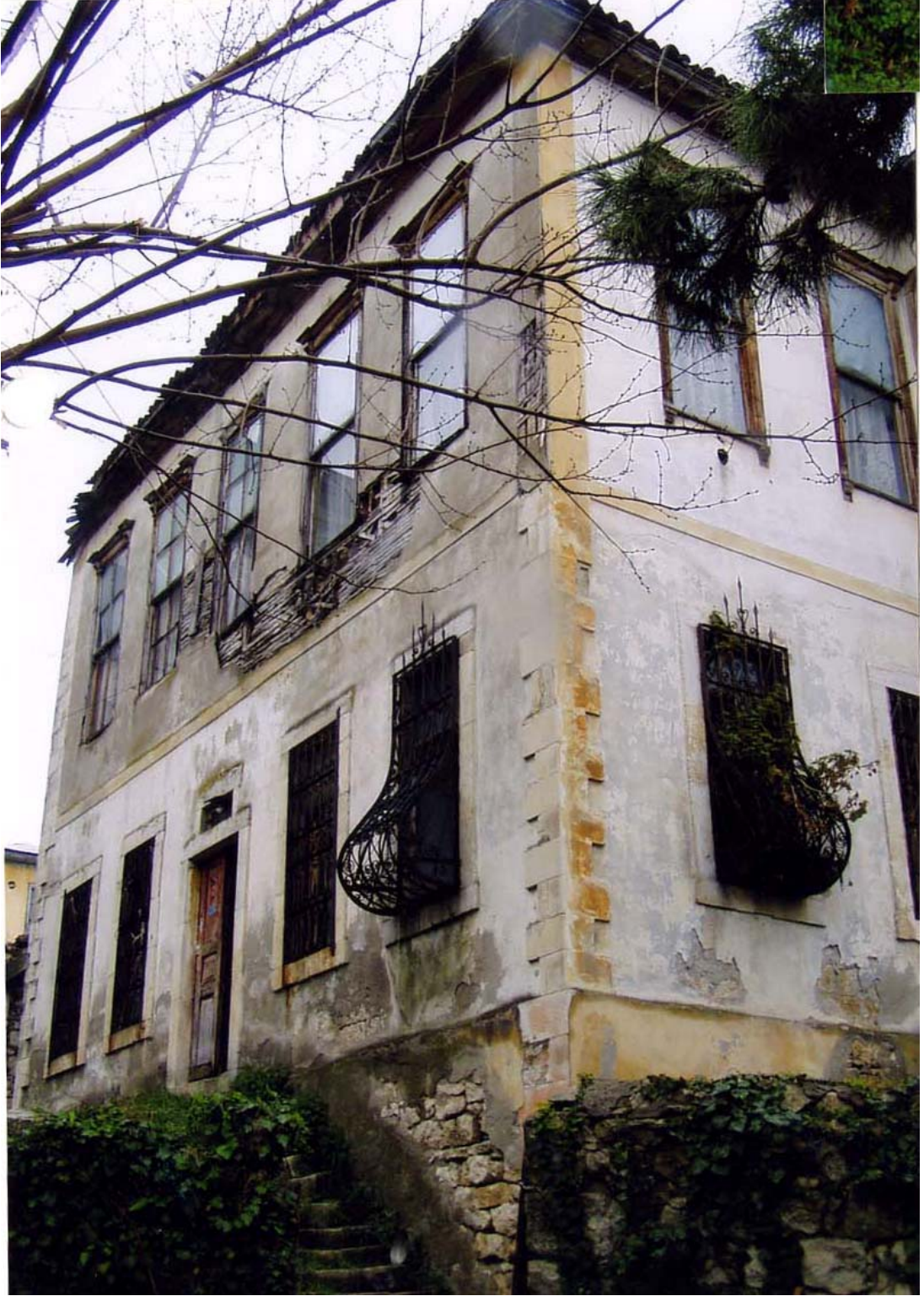
Resim 3.6. Furtun Evi'nin güneybatı cephesi
