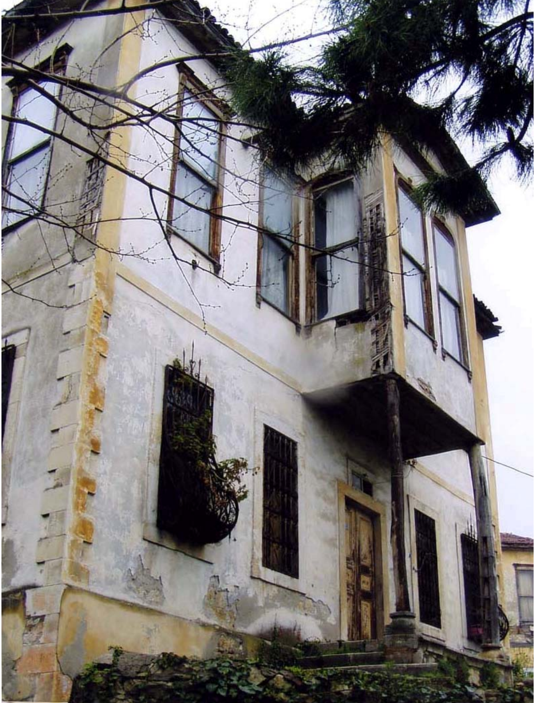
Resim 3.5. Furtun Evi'nin güneydoğu (ön) cephesi
