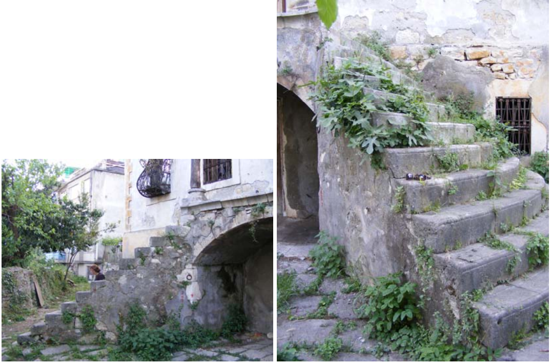
Resim 3.24-3.25. Furtun Evi'nin güneydoğu (ön) cephesindeki çift kollu merdivenin sol ve sağ tarafı
