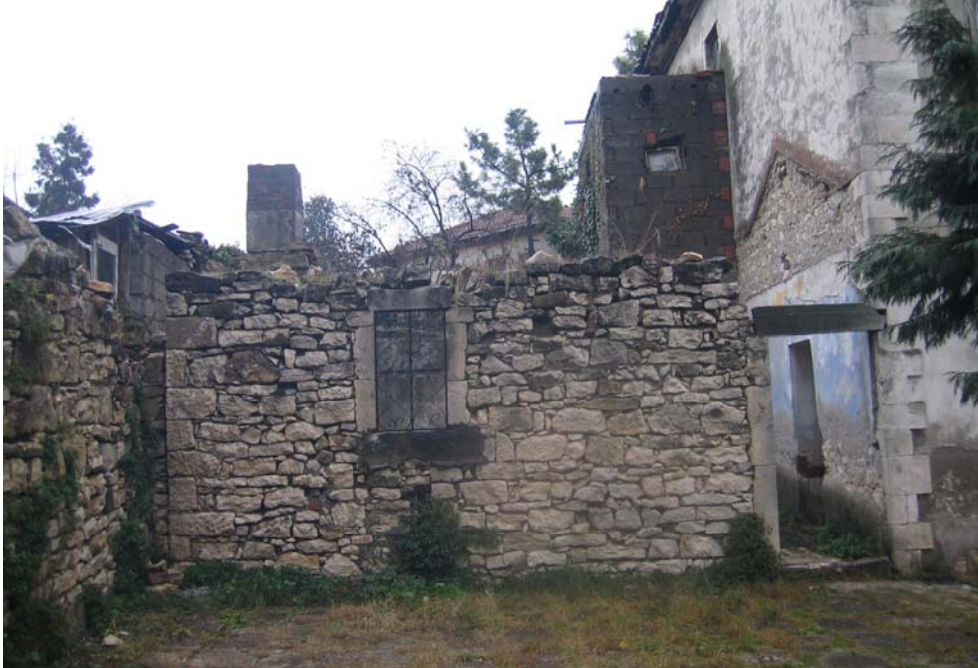
Resim 3.12. Furtun Evi'nin güneybatı cephesi yanındaki mutfak mekanı
