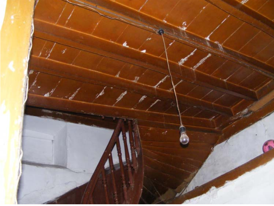
Resim 3.42. Z01A Sofa'nın tavanı ve merdiven alt kaplaması
