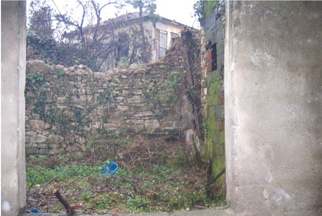
Resim 3.10. Yapının kuzeybatı (arka) cephesi
