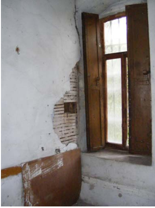
Resim 3.49. Z03-odanın DV4 duvarı
