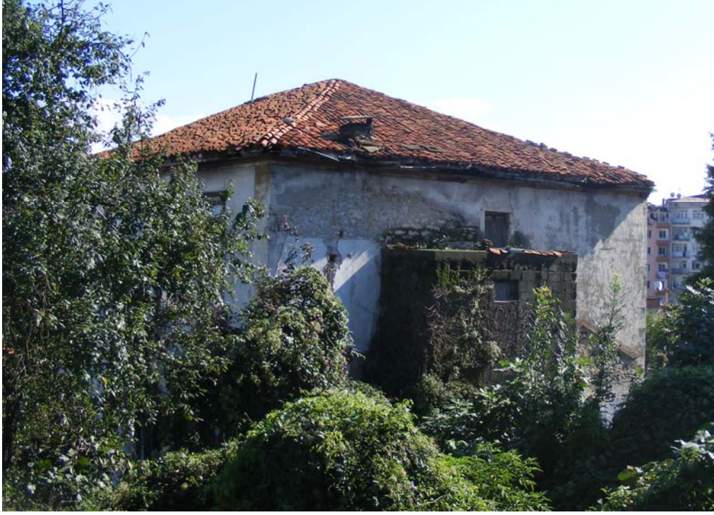
Resim 3.9. Yapının kuzeybatı (arka) cephesi
