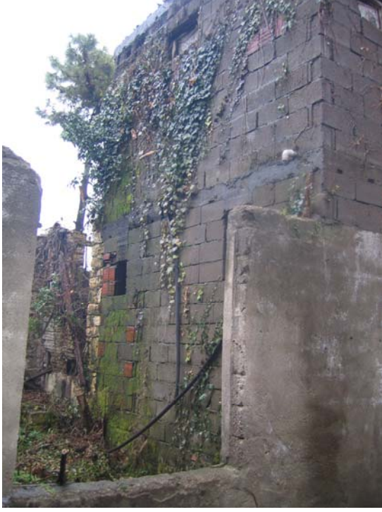
Resim 3.11. Furtun Evi'nin kuzeybatı cephesindeki ıslak hacim mekanı
