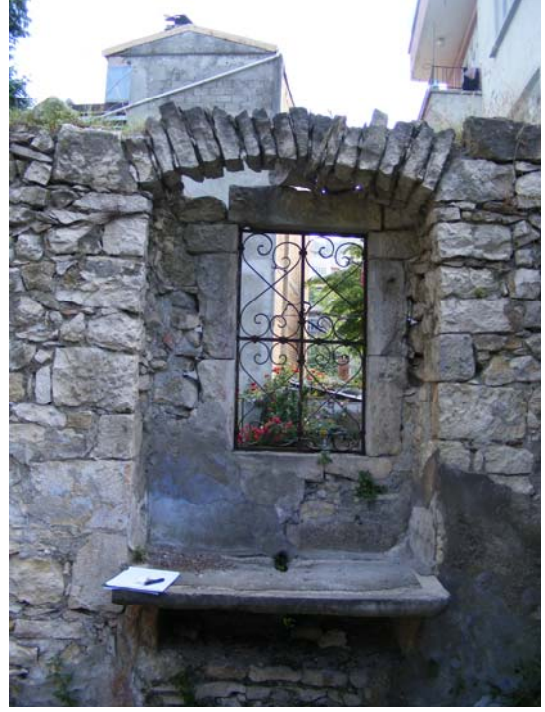
Resim 3.64. Z07-Mutfak penceresi (P5) ve yıkama tezgahı
