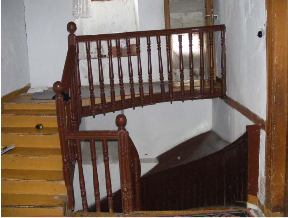
Resim 3.68. 101-Sofa'da bulunan ve 107-Banyo-WC'ye ulaşımı sağlayan merdiven
