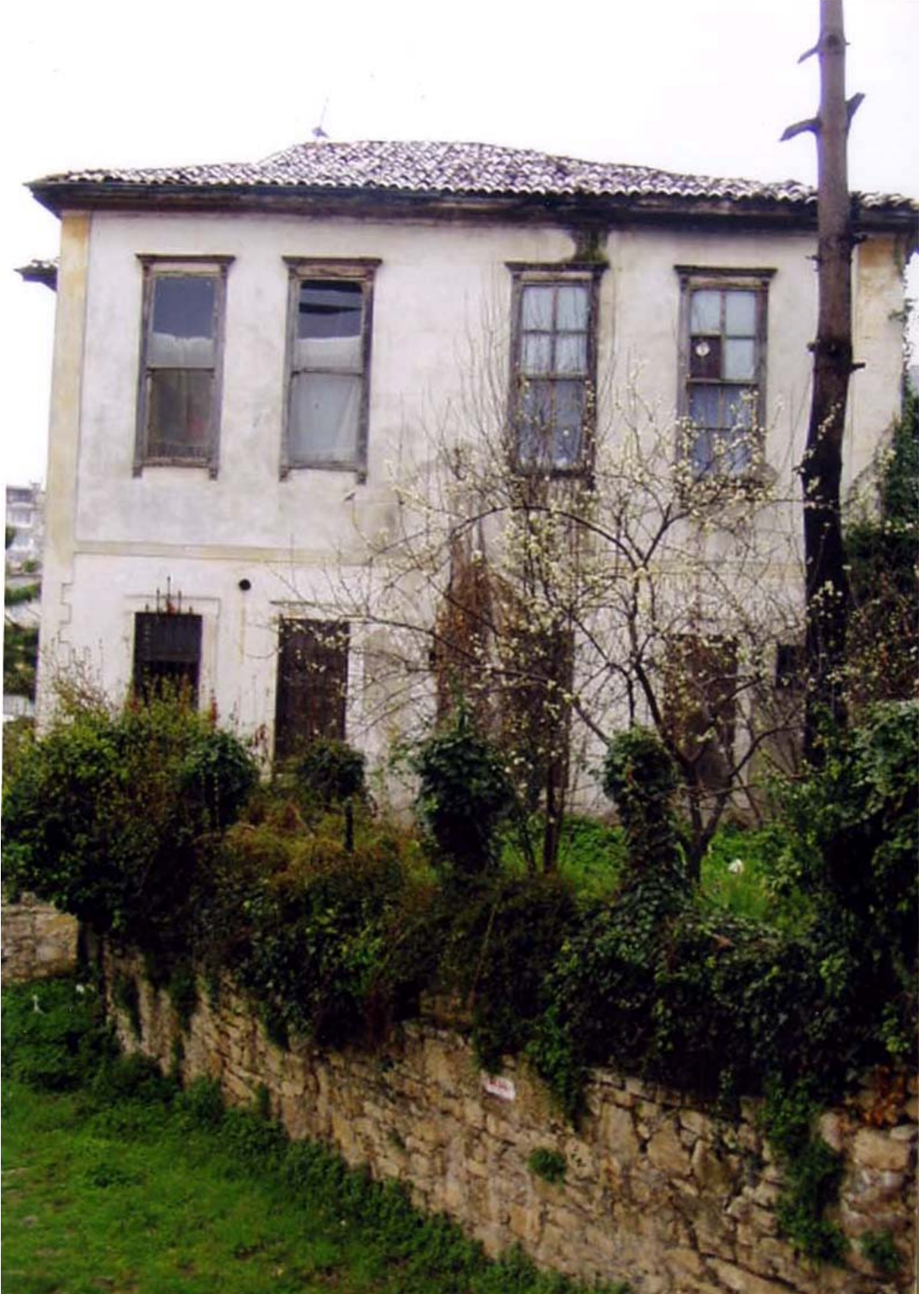
Resim 3.8. Yapının kuzeydoğu cephesi
