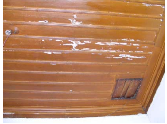
Resim 3.71. 101-Sofa tavanındaki çatıya çıkış boşluğu
