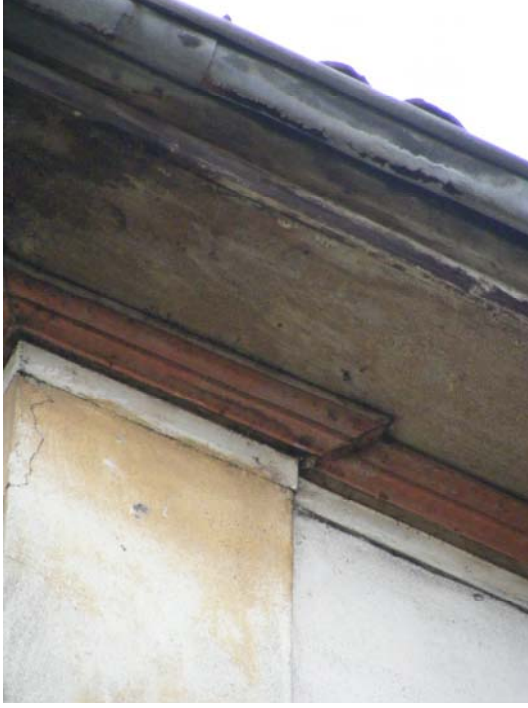
Resim 3.28. Ahşap çatı silmesi
