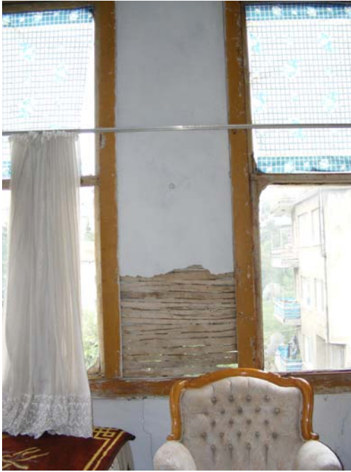
Resim 3.89. 105-oda pencereleri (P9) ve DV2 duvarı
