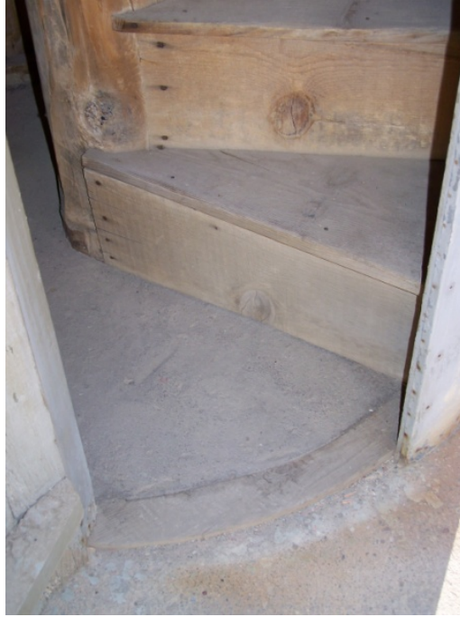
Resim 27- Hacı Hamza Mescidi Ahşap Minare İçerden Görünüşü (Kültür İnş)
