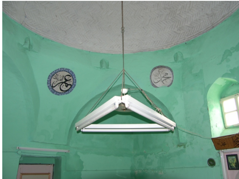
Resim 50- Kızılca Mescidi Kubbeye Geçiş Elemanları ve Kubbe ( Kültür İnş )
