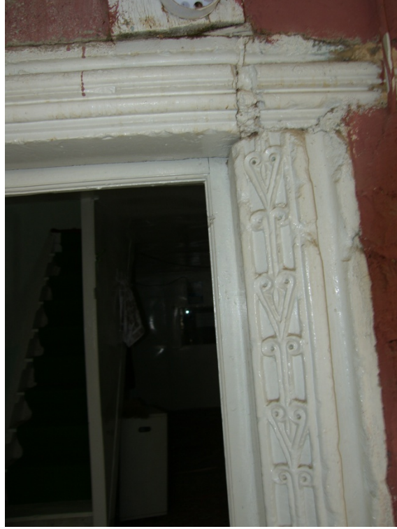
Resim 22- Altunkalem Mescidi Kapının Yanındaki Devşirme Taşlar (Kültür İnş)
