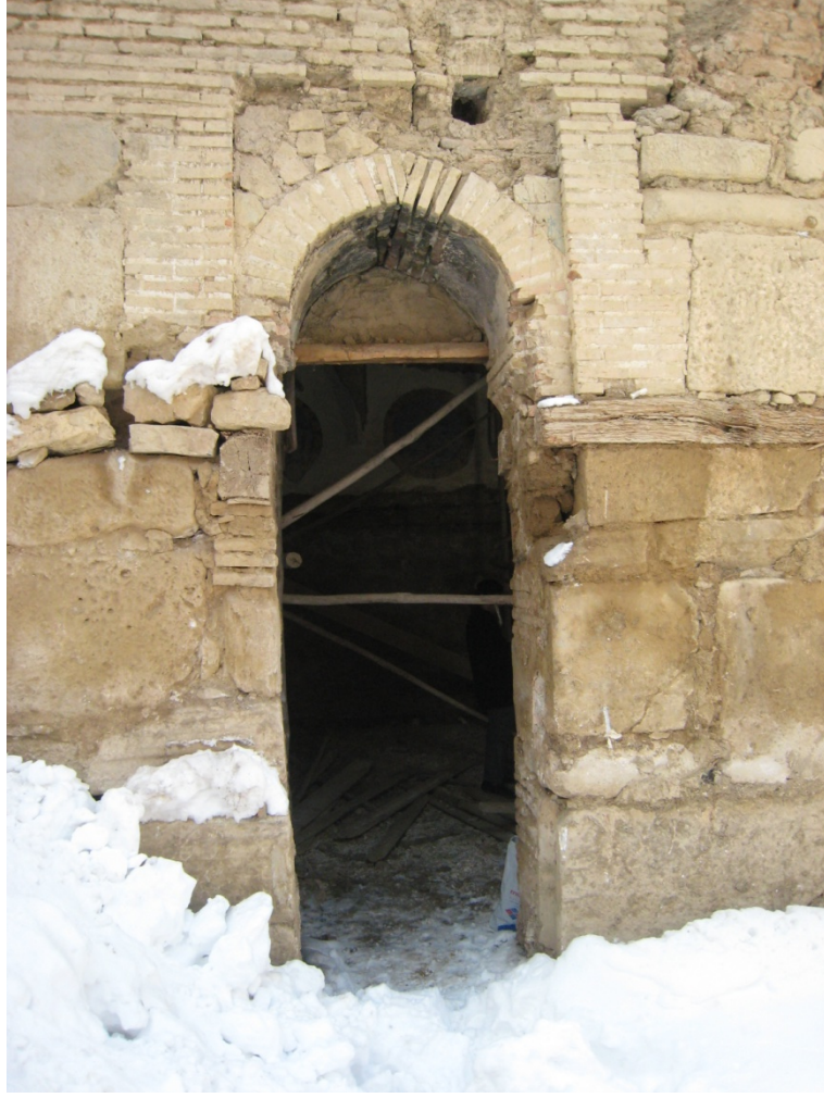
Resim 40- Hacı Hamza Mescidi Doğu Cephesindeki Pencere Düzeni (Kültür İnş)
