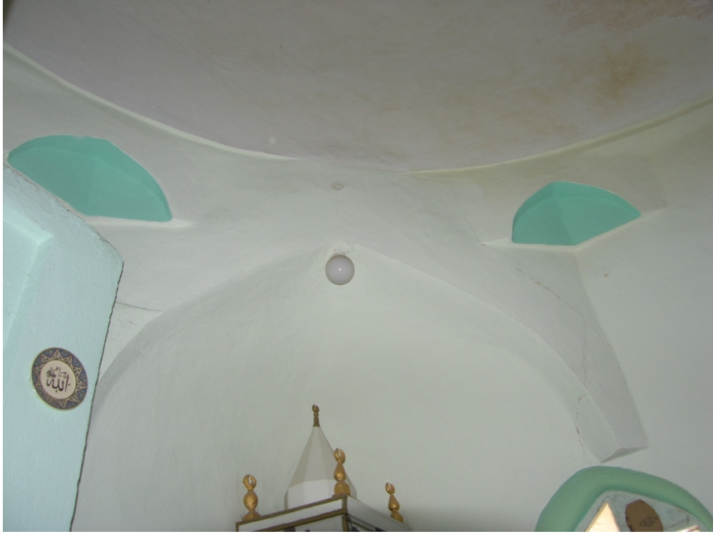
Resim 21- Altunkalem Mescidi Kubbeye Geçiş Elemanları (Kültür İnş)
