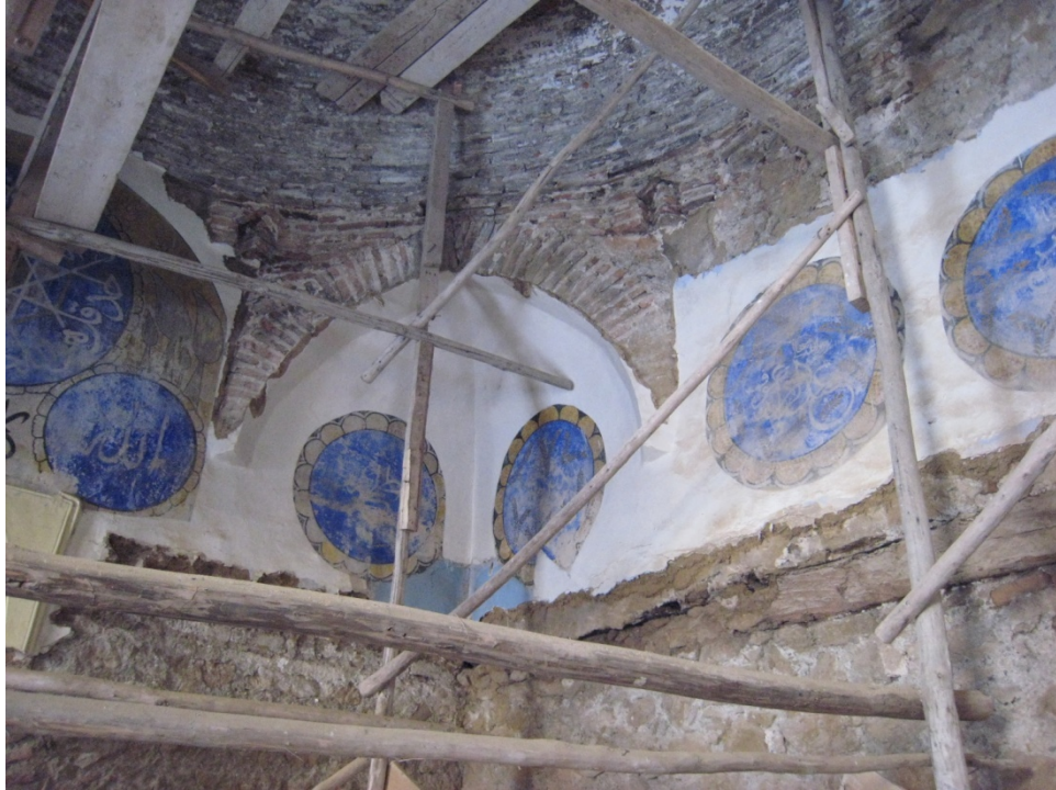
Resim 42- Hacı Hamza Mescidi Kubbeye Geçiş Elemanları ve Kubbe (Kültür İnş)
