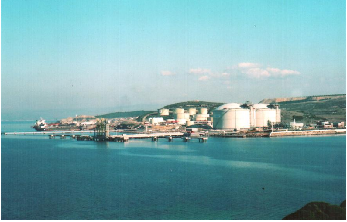
Fotoğraf 59: Ilıca Burun ve Taşlı Burun arasında akaryakıt depolama tesislerinin liman iskelelerinden görünüş.
