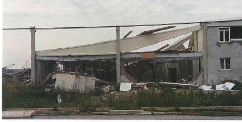
Şekil 4.1. Dolu Gövdeli Kirişin Üst Başlıktan Sıyrılması
