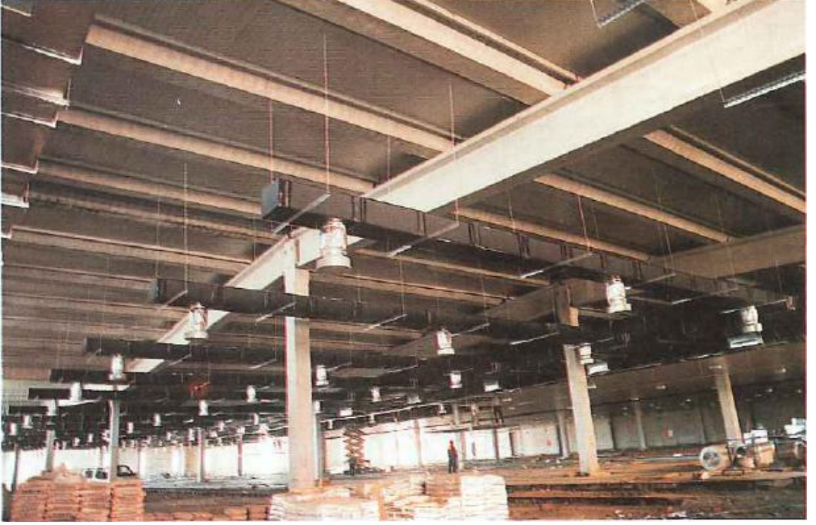
Şekil 2. 4. Prefabrik Sanayi Yapısı
