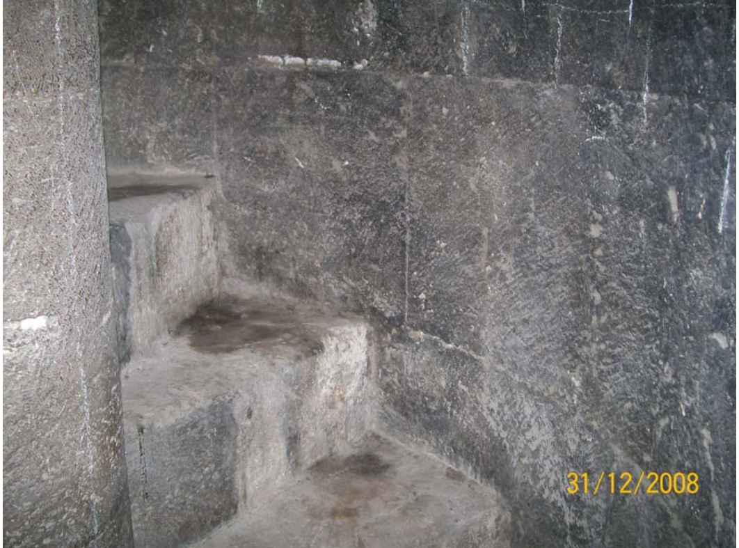
Resim 19 Yeni Camii Minaresi
