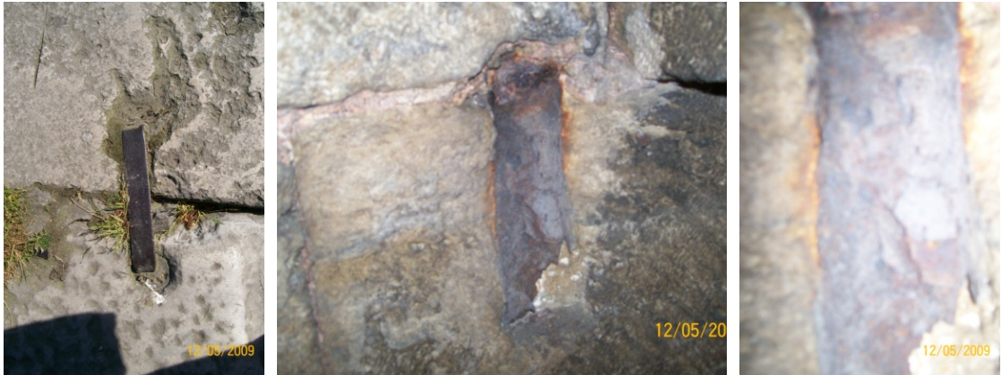
Resim 15 Minarenin yapımında kullanılan ankrajlar
