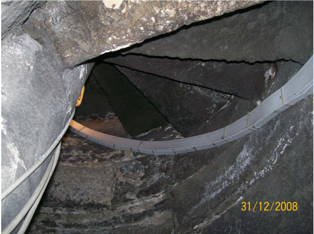
Resim 22 Yeni Camii Minaresi
