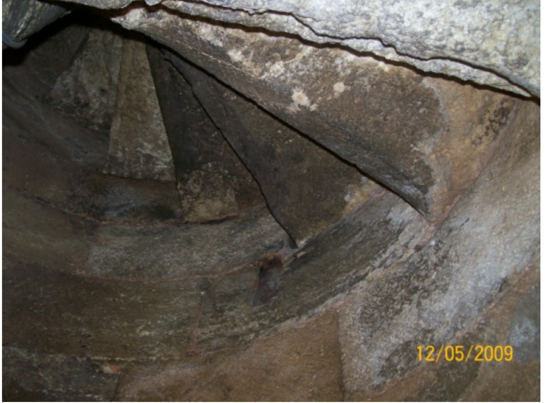
Resim 16 Mihrimah Camii Minaresi, merdivenlerin alttan görünüşü
