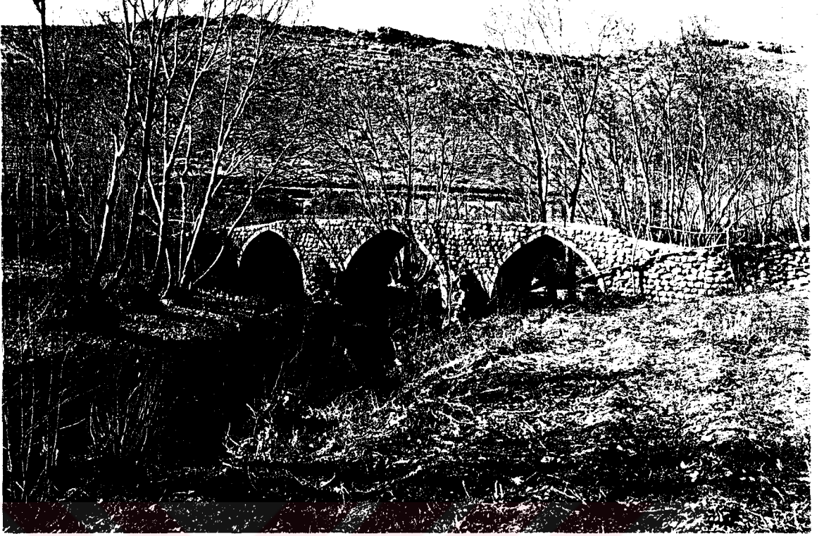
Resim: 173- Hisarkaya Köyü Köprüsü'nün Genel Görünüşü.
