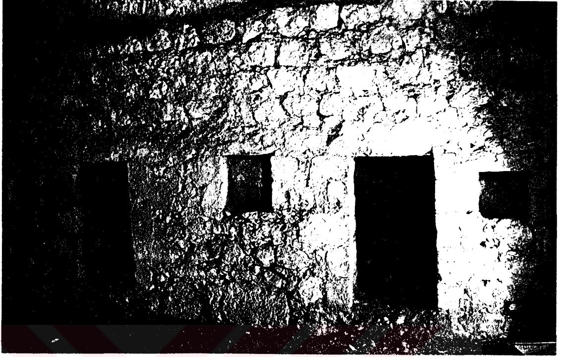
Resim: 19- Savur Eski Camii'nin Medresesinin Kuzey Odasının Doğu Duvarı.
