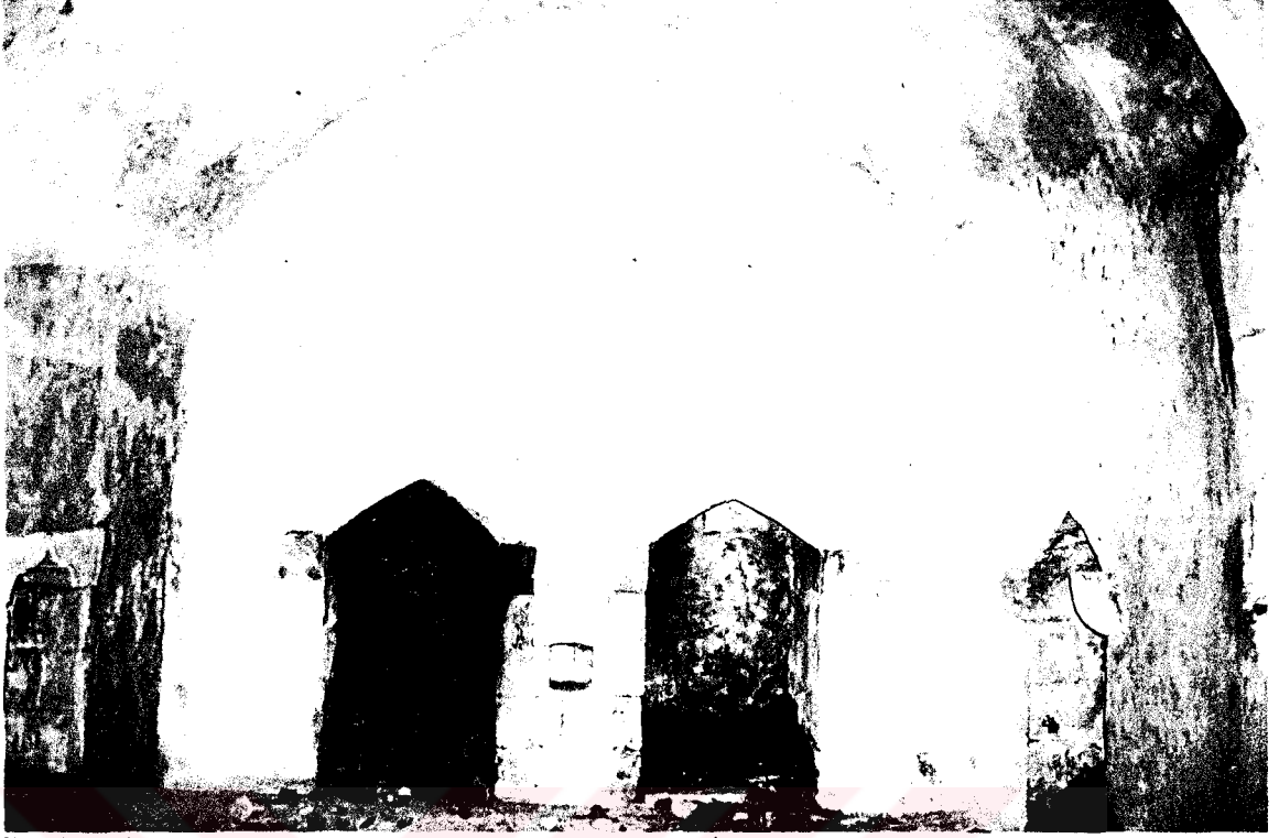
Resim: 161- Necmettin Kaya Çamaşırvhanesi'nin İç Mekanındaki Ocak Nişleri.
