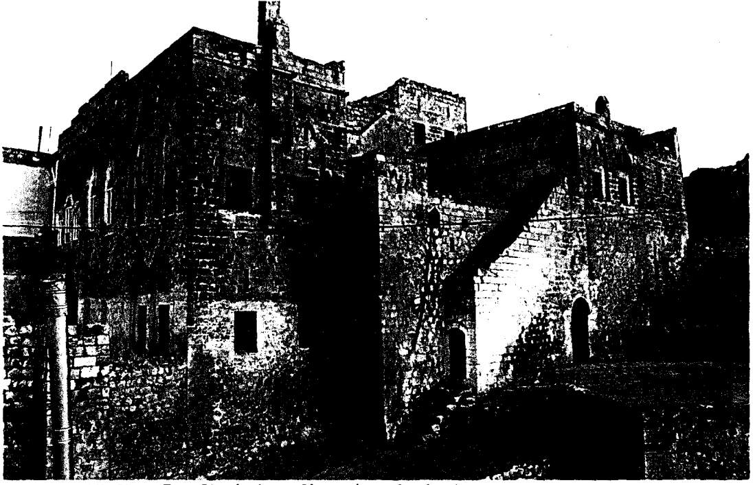
Resim: 215- Hacı Bey K şk 'n n Kuzeybatı Cephesi.
