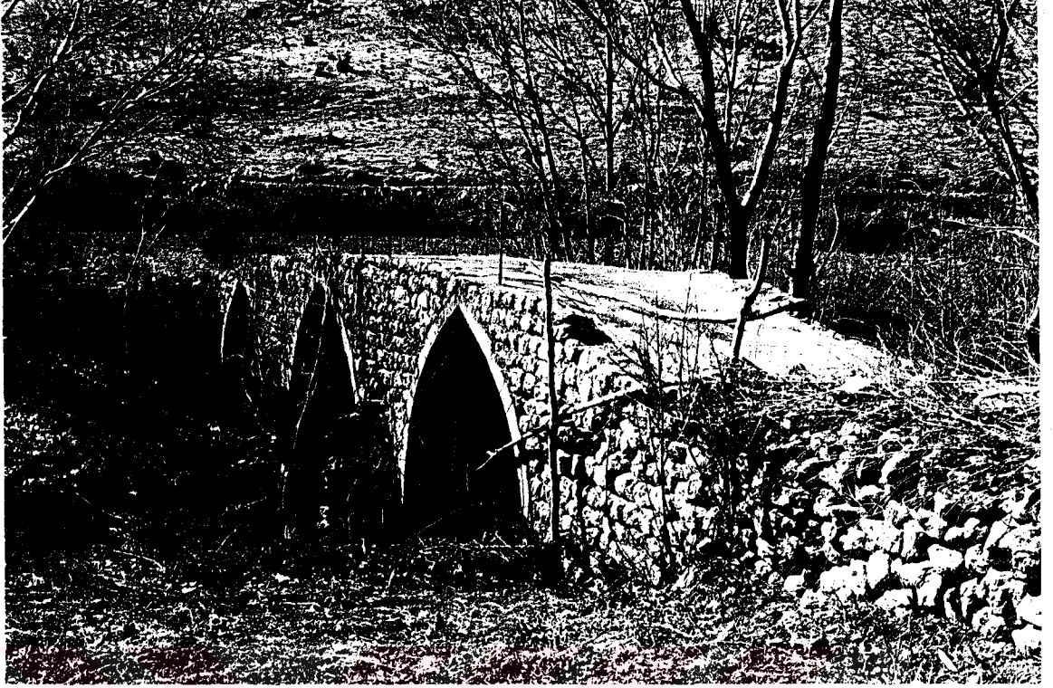
Resim: 175- Hisarkaya Köyü Köprüsü'nün Menba Görünüşü ve Selyaranları.
