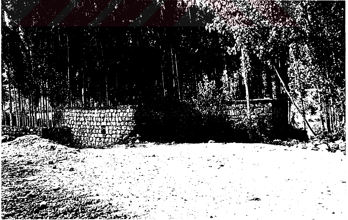
Resim: 154- Meydan Çamaşırvhanesi'nin Doğu Cephesi.
