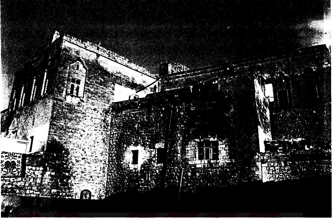
Resim: 247- Asım Fidan Evi'nin Batı Cephesi.
