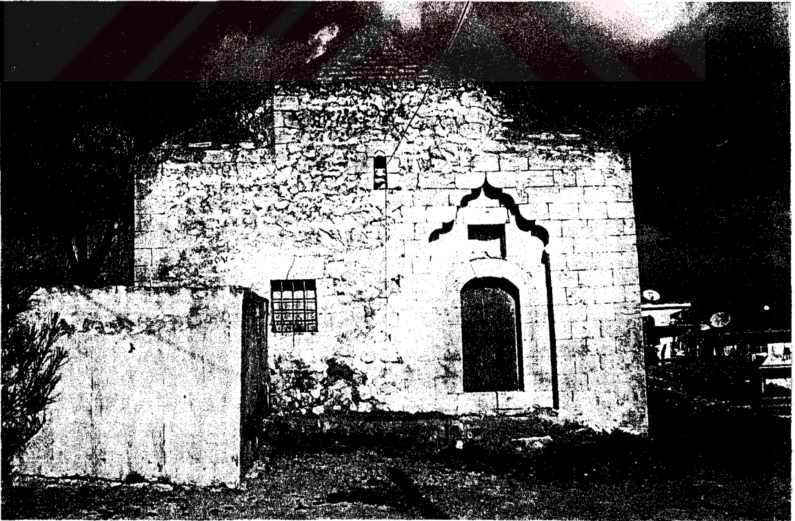
Resim: 64- Şeyh Abdülhalim Türbesi'nin Güney Cephesi.
