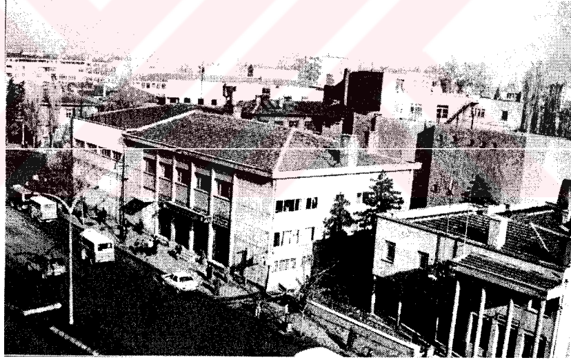
Şekil 4.12. Tekel Binası (Foto.:Karakaya, N., 1985)
