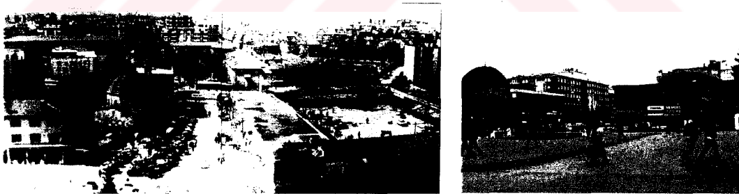
Şekil 5.8. Eski Hal binası (1975-1980)-Alanın yeni durumu (2002)
