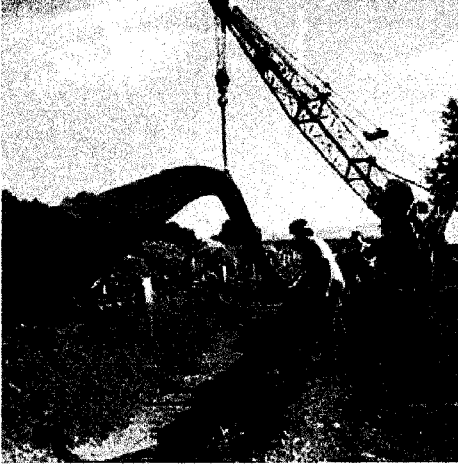
Şekil II.6.3. Kanal dışında birleştirme
