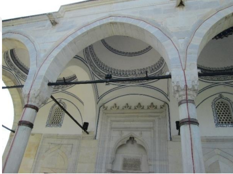
b) Mustafa Paşa Camii'nde metal gergi uygulaması.
