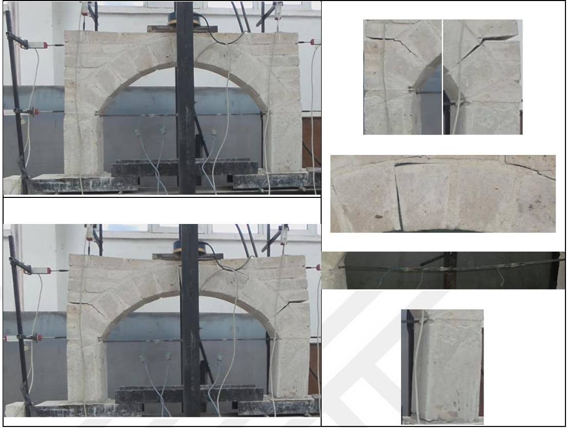
Şekil 4.14. Numune 1 deney numunesinin deney öncesi, sonrası görünümü ve çatlak detayları.
