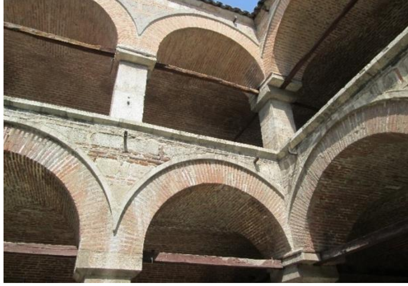
a) Kurşunlu Han'da ahşap gergi uygulaması.
