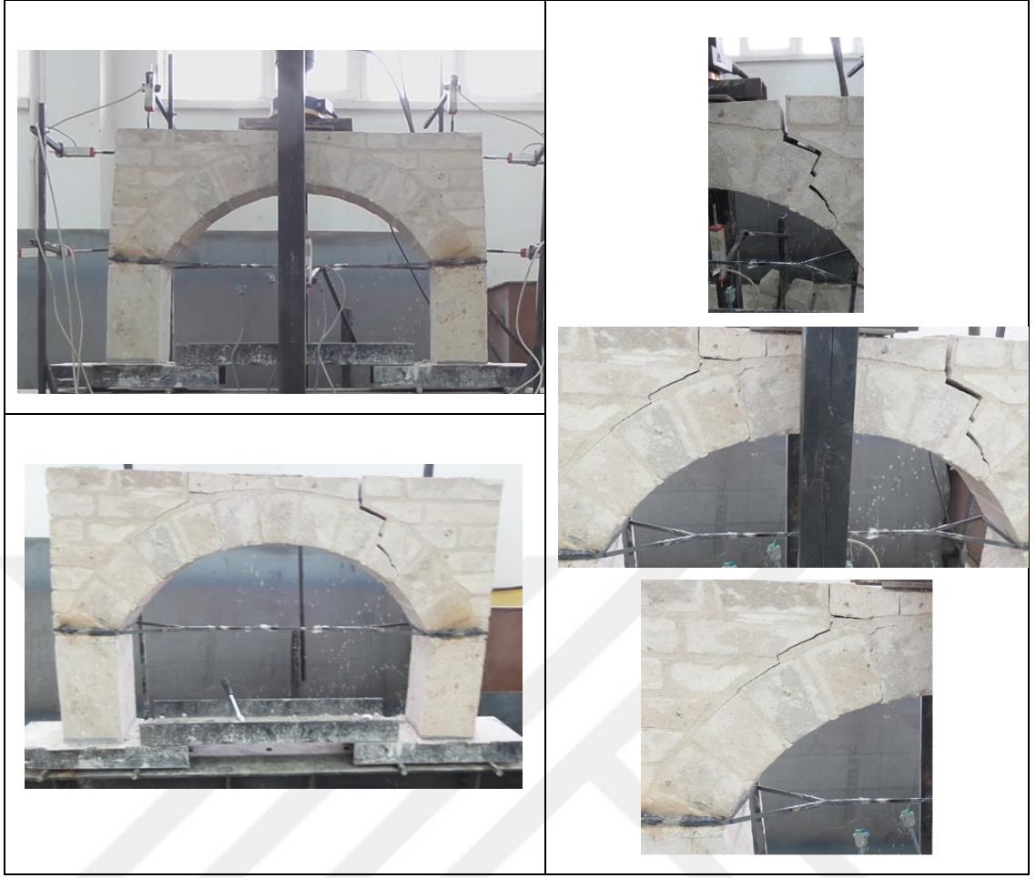
Şekil 4.29. Numune 5 deney numunesinin deney öncesi, sonrası görünümü ve çatlak detayları.
