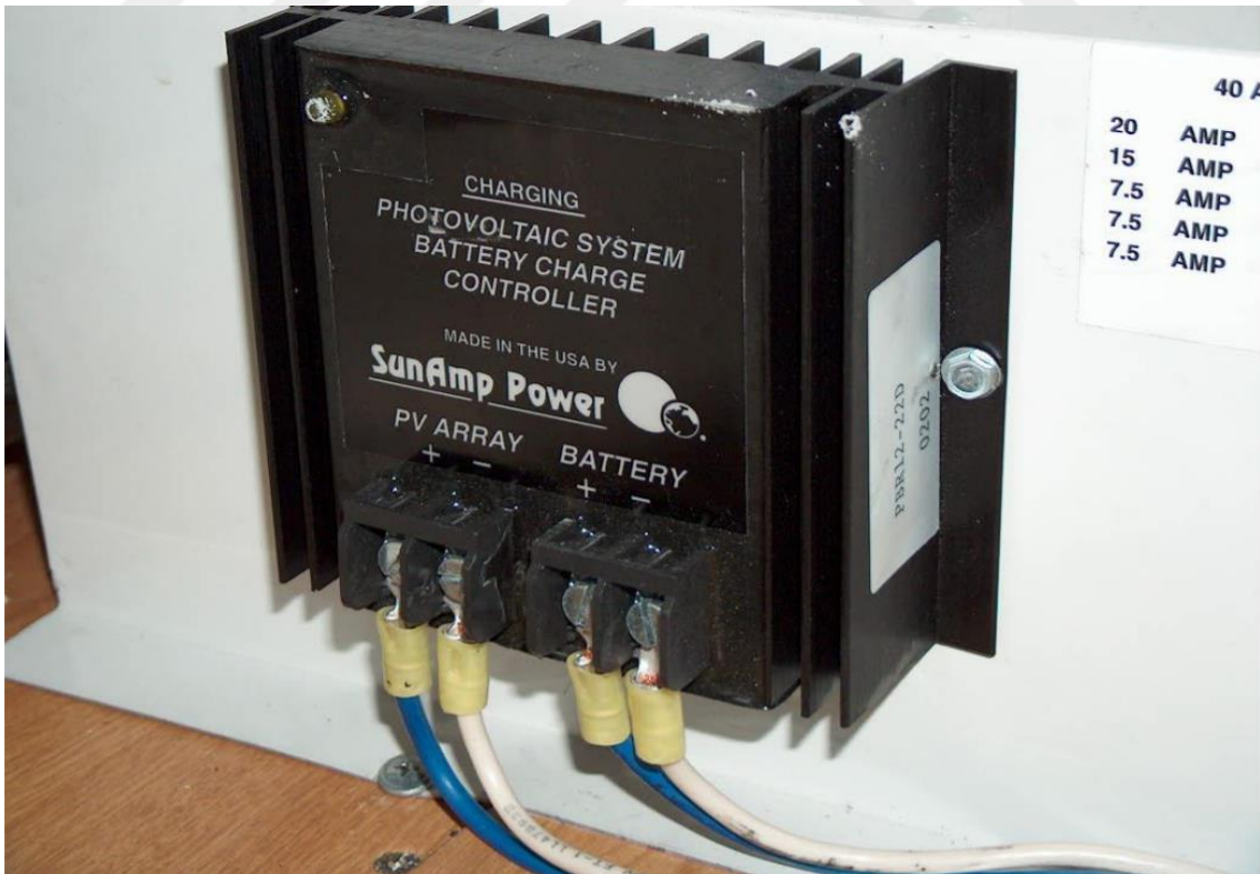
Şekil 4.16. Akü şarj regülâtörü
