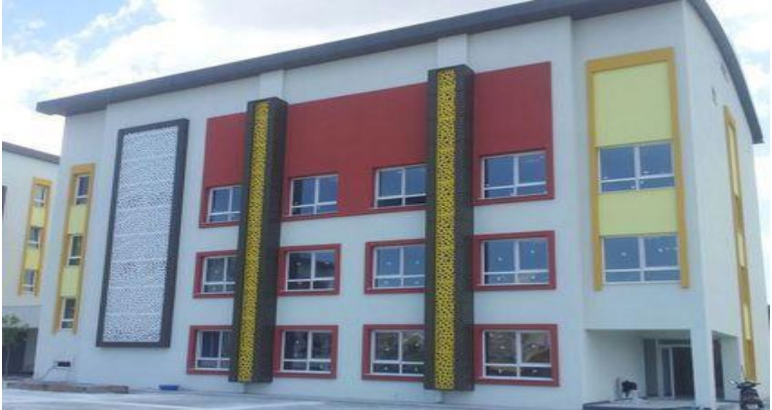
Fotoğraf 8: Aliağa Yeni Belediye Binası
