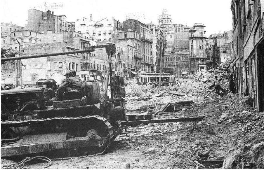
Şekil 3.17 : Karaköy Meydanı'nda yıkım çalışmaları (Url-4).
