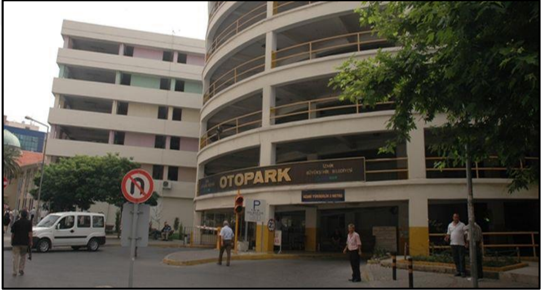
Şekil 3.4: İstanbul'da Katlı Otopark Örneği
