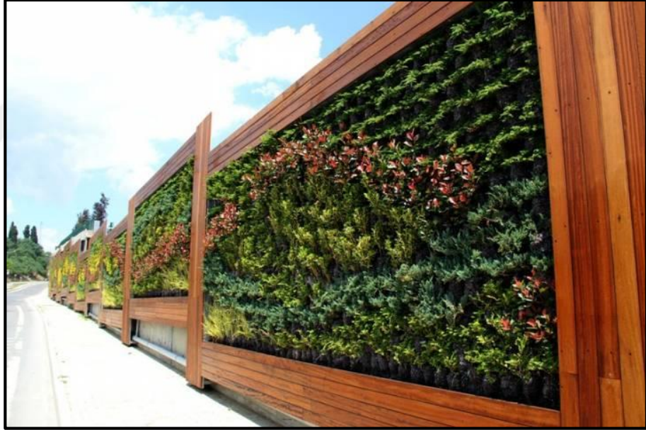
Şekil 2.2: Şehir İçi Yollarda Duvar Bahçe Uygulama Örneği
