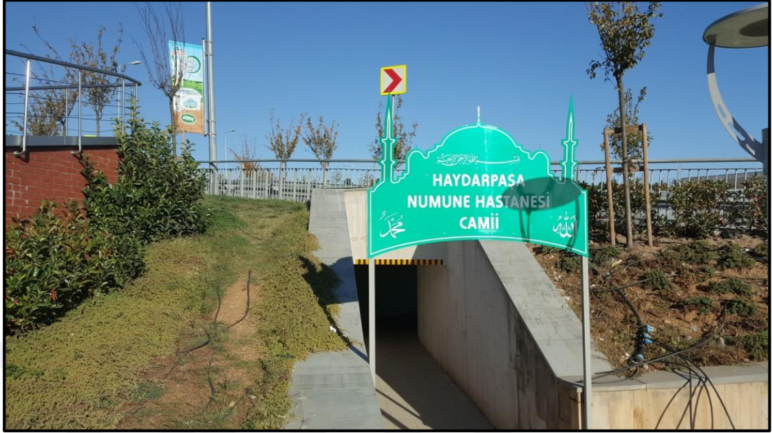
Şekil 5.10: Haydarpaşa Numune Hastanesi zemin altı camii
