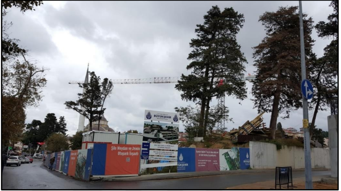
Şekil 5.21: Şile Meydanı zemin altı otopark inşaatı (2017)
