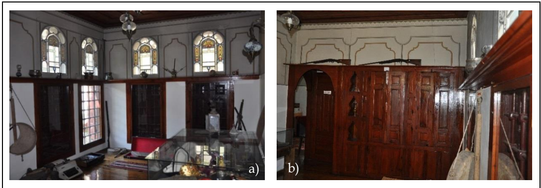
Şekil.4.20: 1-06 mekânı a) Kuzey- Batı duvarına bakış b)Güney duvarına bakış.
