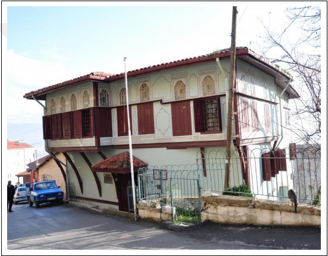
Şekil.4.21: Yapıya Kuzeyden bakış.
