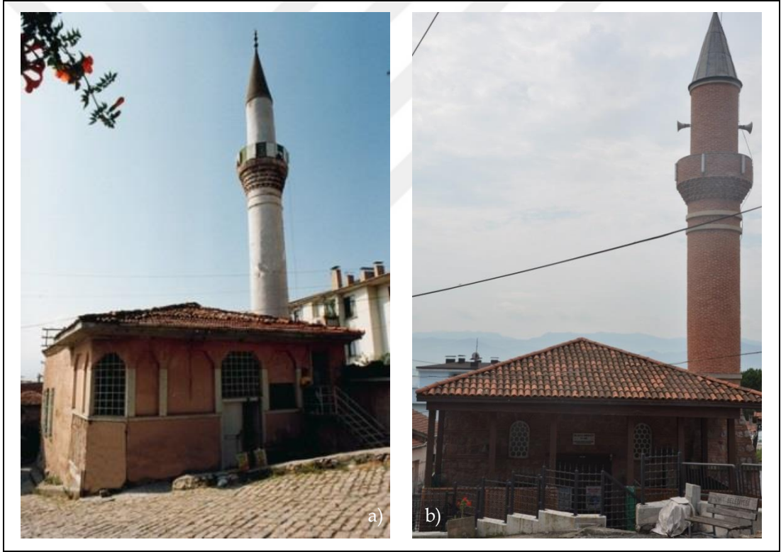
Şekil 2.18: Alacamescit Camii.a) 2003 b) Restorasyon sonrası 2018.
