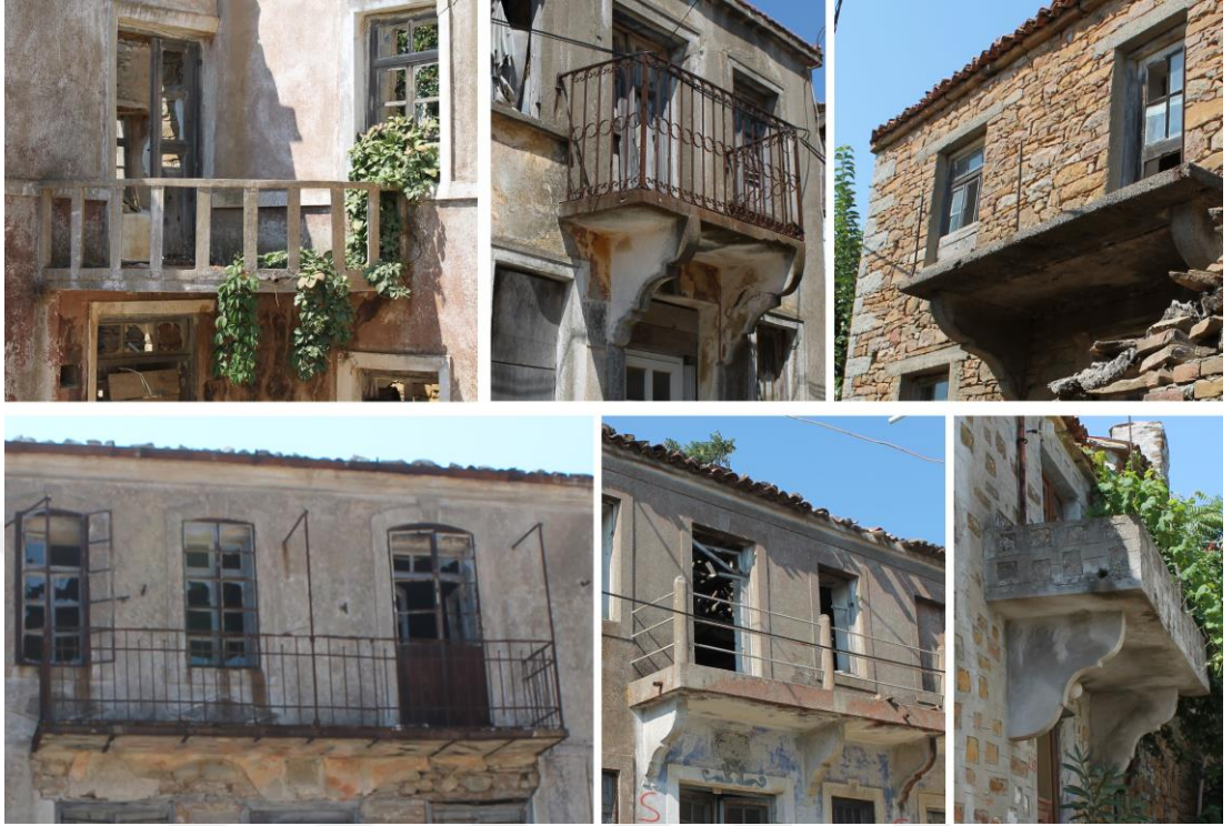
Şekil 2.91 : Metal ve betonarme strüktürlü balkon tipleri.
