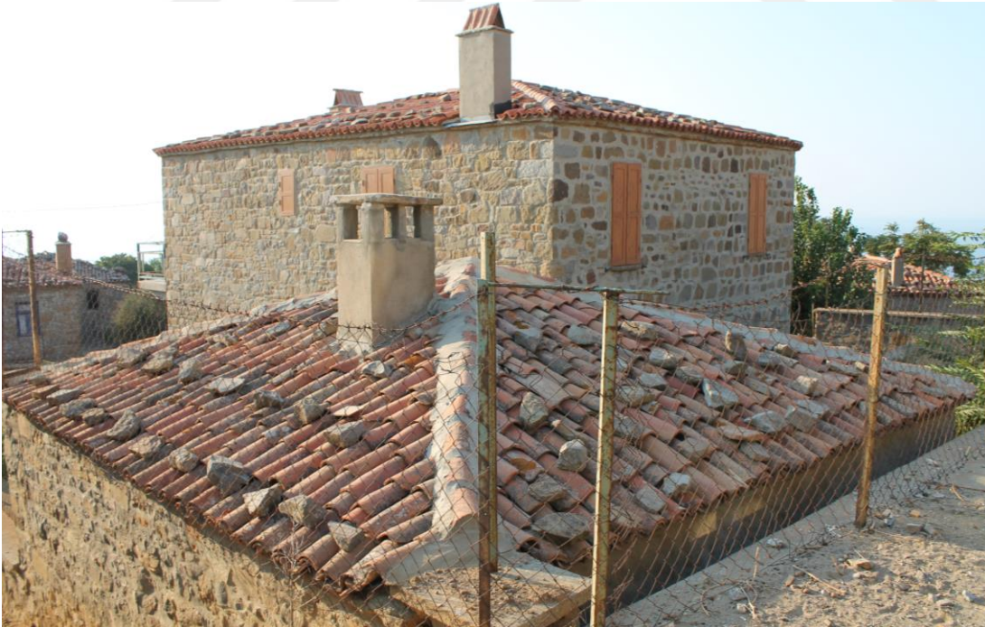
Şekil 2.85 : Geleneksel bir yapının çatısı.
