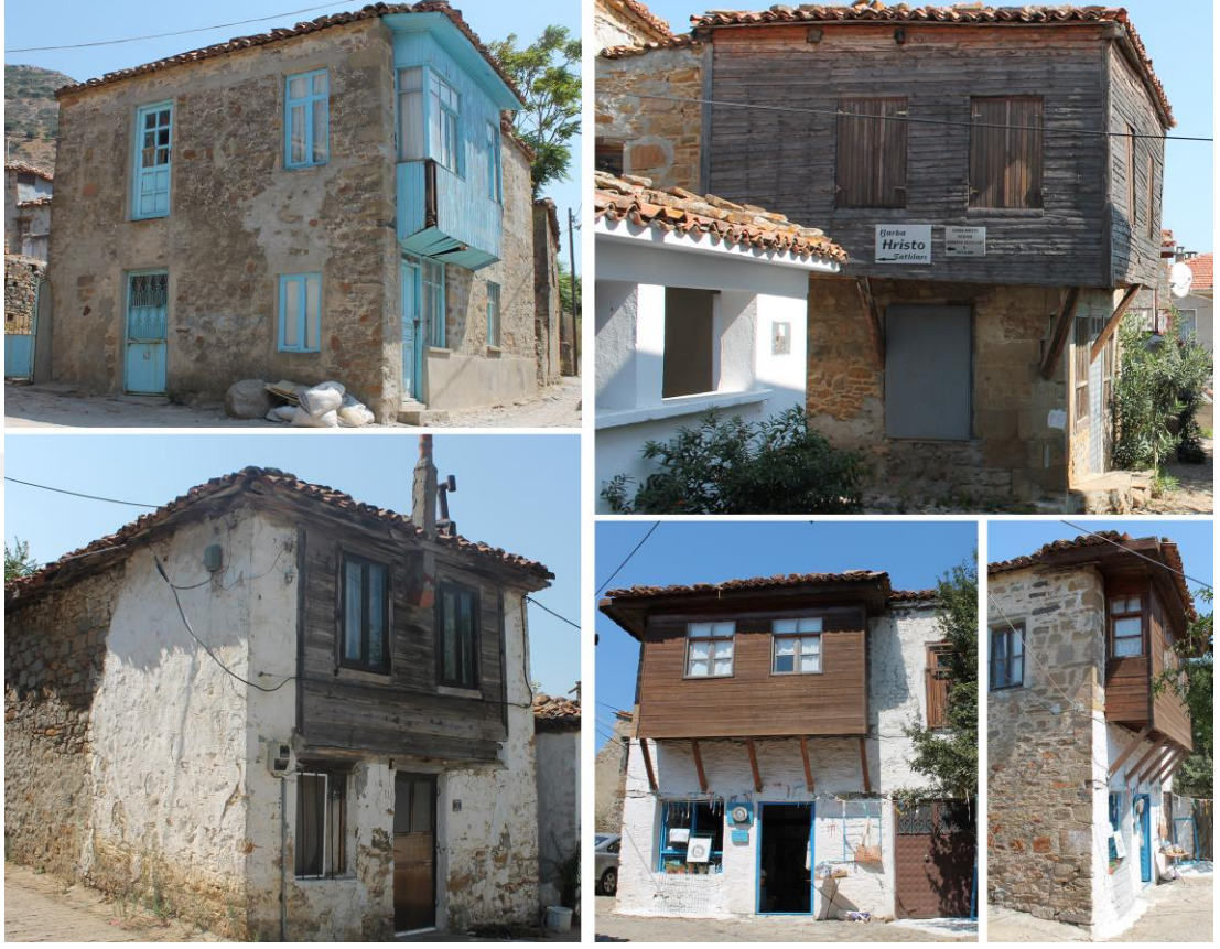
Şekil 2.82 : Ahşap cumbalı yapı örnekleri.
