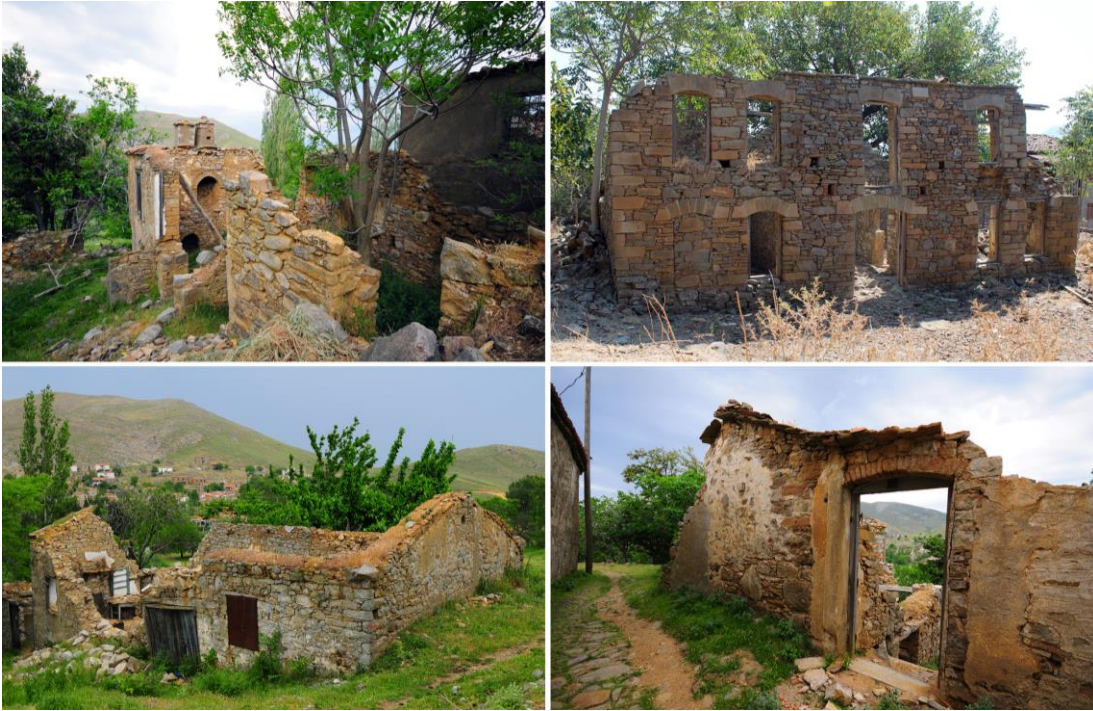
Şekil 5.13 : Dış etkenlerden zarar gören yapılar.
