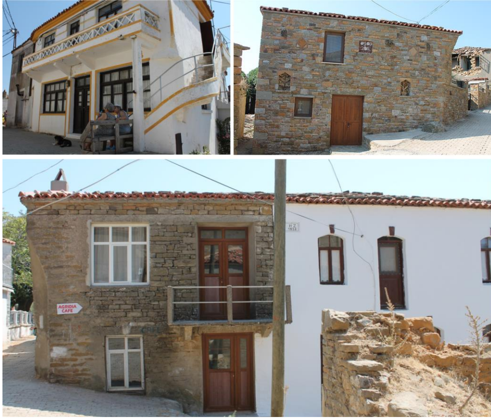
Şekil 5.4 : Niteliksiz onarımlara Tepeköy'den örnekler.
