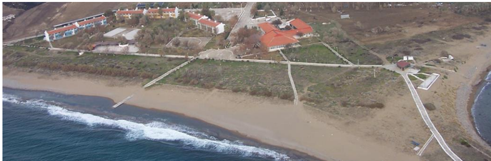
Şekil 5.7 : Adalet Bakanlığı Tesisleri (Gökçeada Kaymakamlığı Arşivi).
