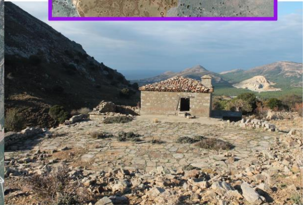
8- Dam yapılarına bir örnek
