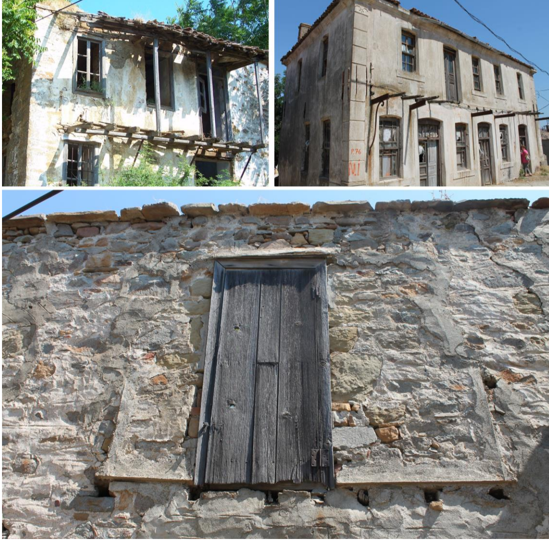
Şekil 2.90 : Ahşap strüktürlü balkon izleri.
