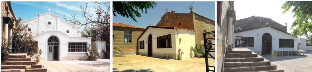
Şekil 2.48 : Tepeköy Evangelismos Theotoku Kilisesi; soldan sağa yapının eskiden yeniye durumu (sol ve orta t.y., sağda 2014 depremi sonrası).
