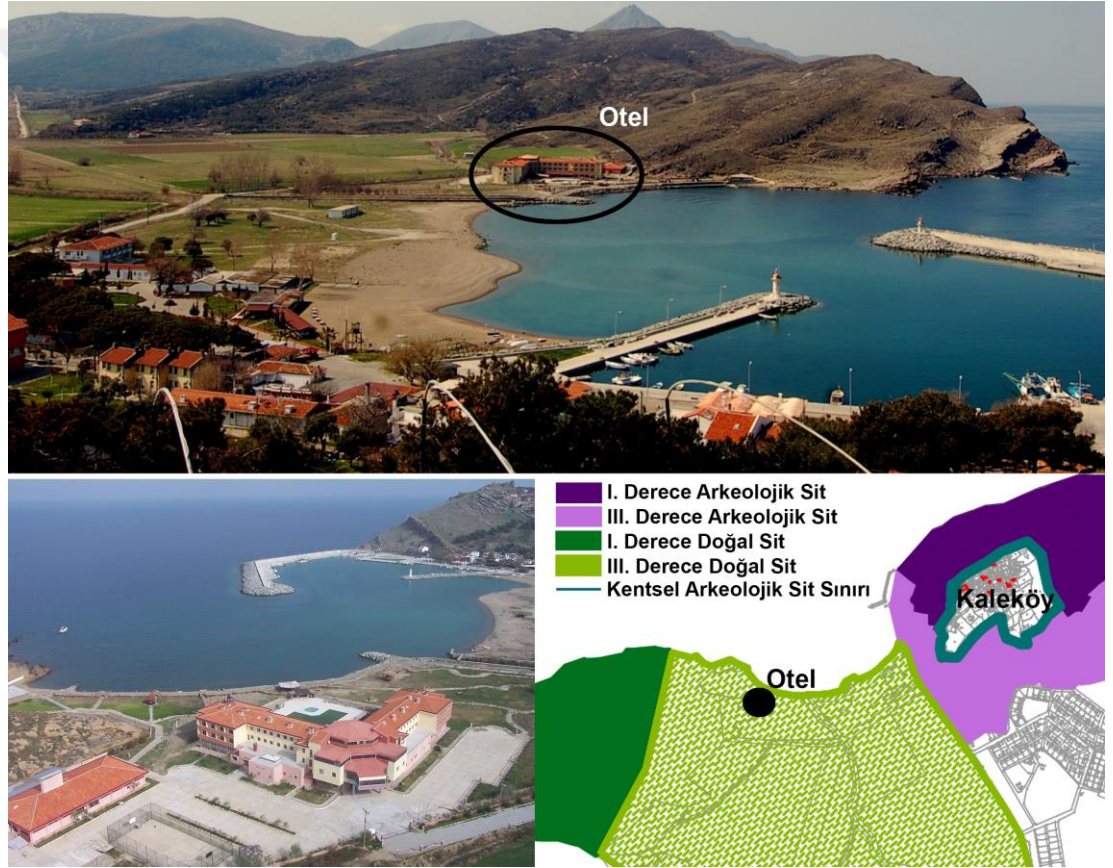
Şekil 5.9 : Kaleköy sahilindeki otel yapısı.
