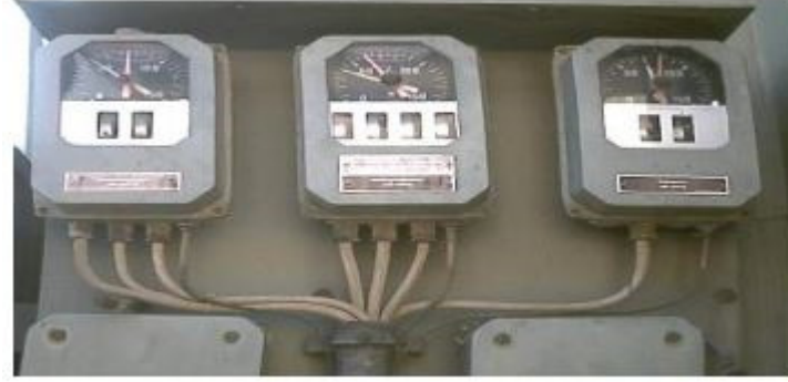
Şekil 4.5: Isıdan koruma (temperatür) röleleri[19].
