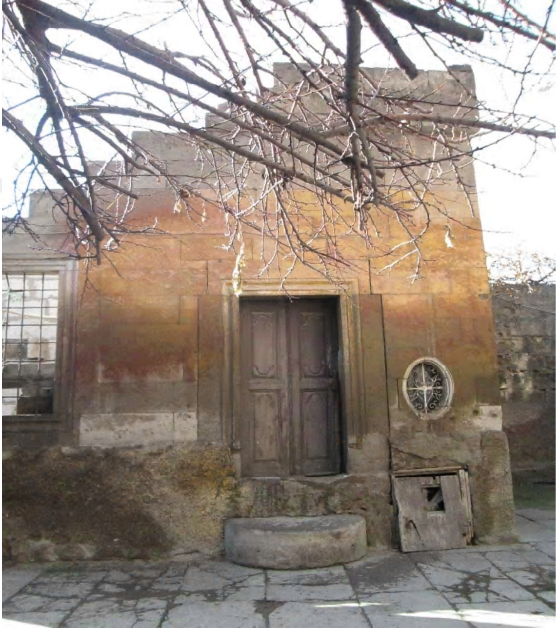
ŞEKİL.A.10.Surp Krikor Lusavoriç Kilisesinde Bulunan Sarkis Gümüşyan Okulunun Bir Odası/ 09.03.2018
