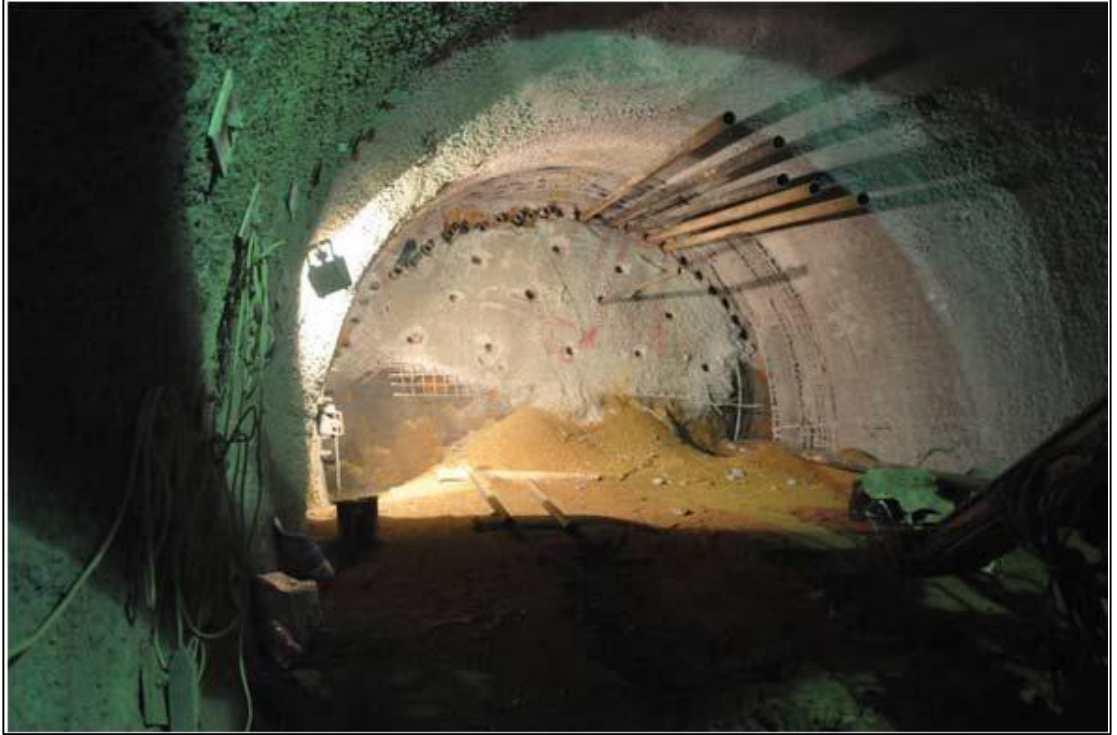
Şekil 6.3. Umbrella boruları Kabataş-Mecidiyeköy Metro uygulaması
