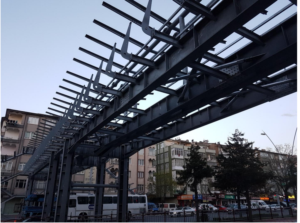
Şekil 1.1. Üst geçit yapısındaki kirişlerde enine berkitme uygulaması
