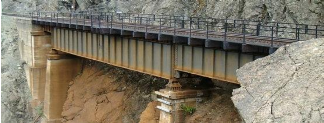
Şekil 1.3. Demir yolu köprüsü kirişlerinde enine berkitme uygulaması [25]
