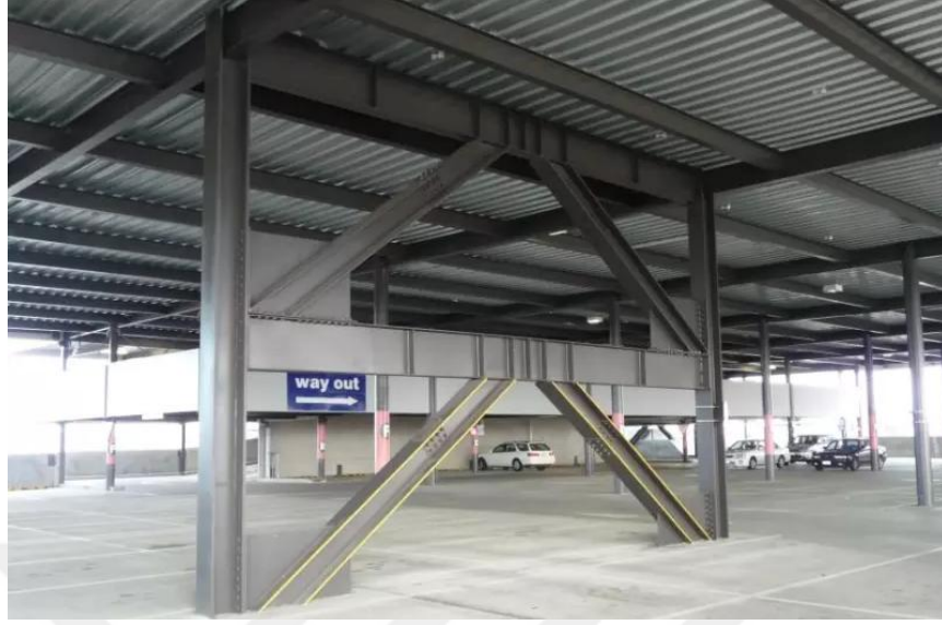
Şekil 1.2. Dış merkez çelik çaprazlı yapılarda bağ kirişinde berkitme uygulaması [24]
