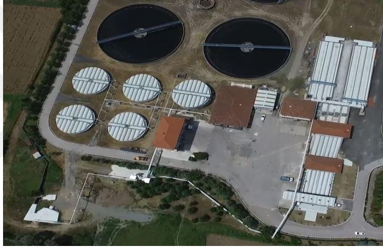
Şekil 2.1. Üzeri Kapatılan Ünitelerin Görünüşü
