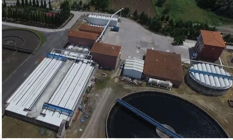
Şekil 2.4. Üzeri Kapatılan Havalandırmalı Kum ve Yağ Tutucu Ünitesi
