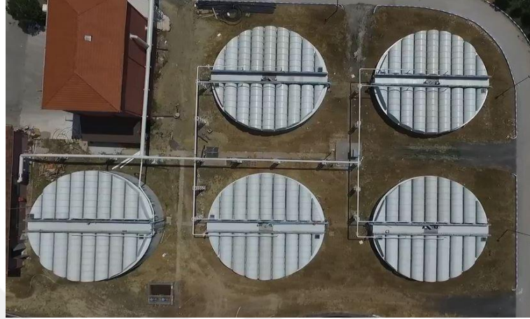
Şekil 2.5. Üzeri Kapatılan Çamur Yoğunlaştırma Havuzları
