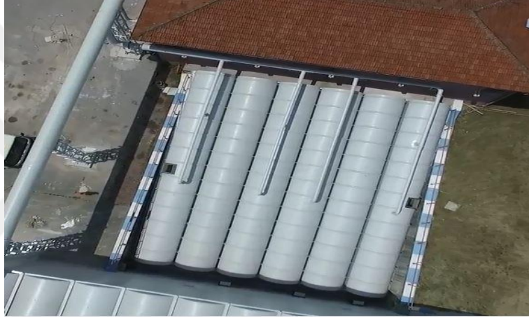
Şekil 2.3. Üzeri Kapatılan Arşimediyen Pompa Bölümü
