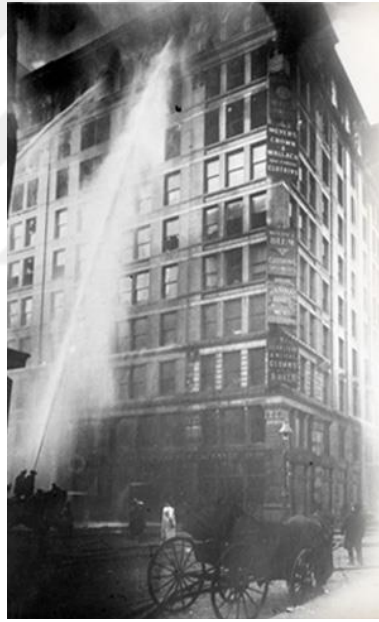
Şekil 2. 21 Triangle fabrikası yangın söndürme çalışmaları [45]
