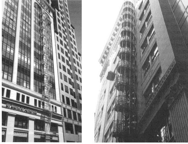
Şekil 2. 19 ABD’de dış kaçış merdivenleri [1]
