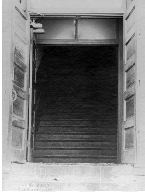
Şekil 2. 25 Italian Hall binasının dışı açılan kapısı [48].
