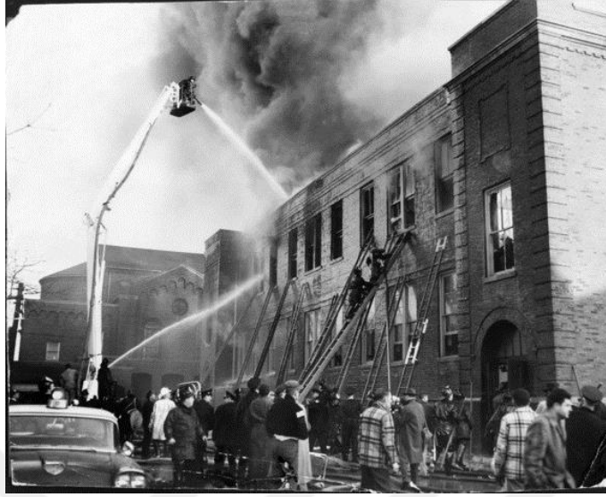
Şekil 2. 26 Our Lady of Angels binasında yangın söndürme çalışmaları [50]
