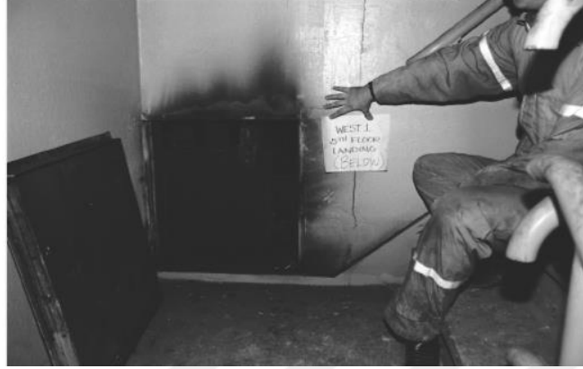
Şekil 2. 29 Havalandırma sisteminden dumanın ulaşması [3].
