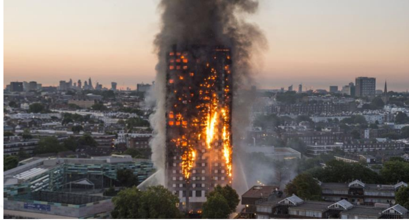
Şekil 2. 33 Grenfell Tower yangını [57]
