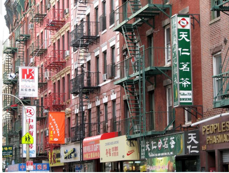
Şekil 2. 16 Dış kaçış merdivenlerinde alınan önlemler [40]
