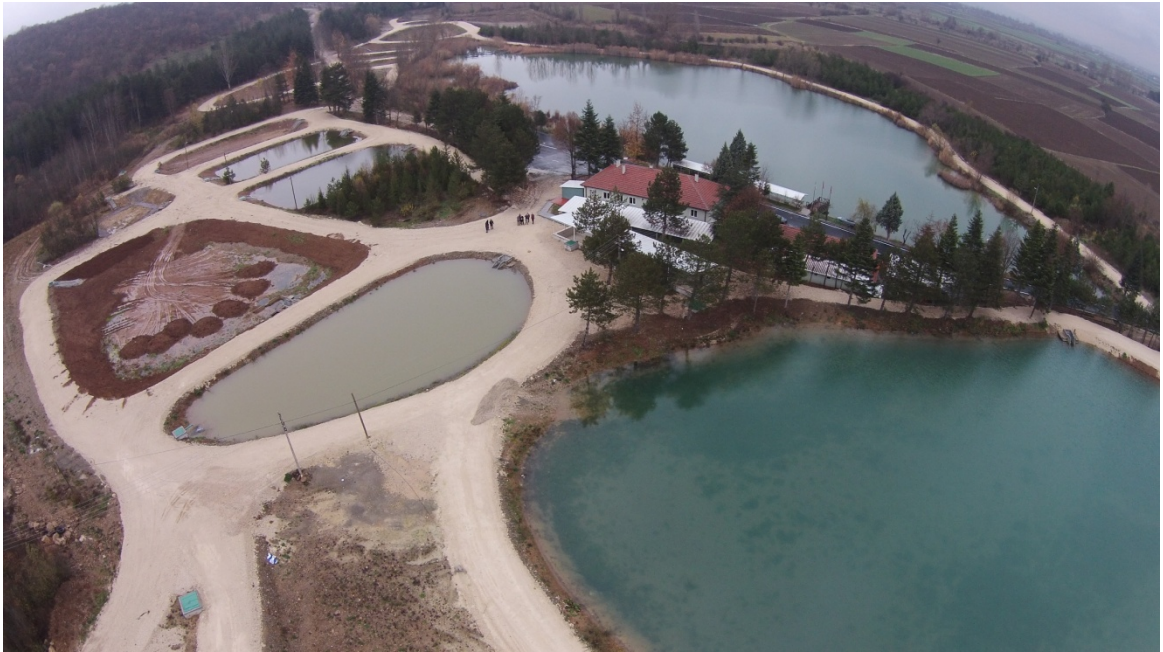
Şekil 3.3. DSİ Bolu-Gölköy Su Ürünleri İstasyonuna ait balık üretim havuzları (Orijinal)
