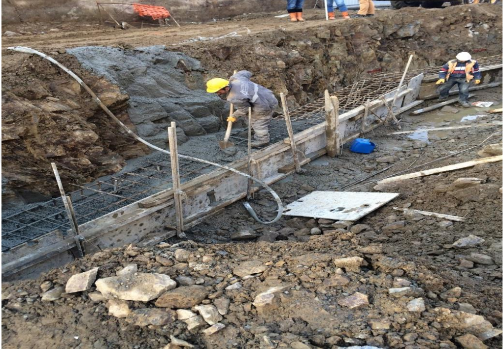
Şekil 4.15. Beton dökme aşamasına ait görsel
