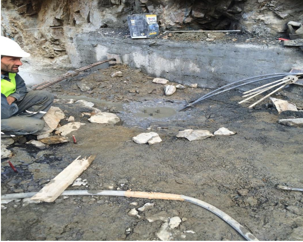
Şekil 4.7. Mini kazık imalatında çimento enjeksiyonunu gösteren görsel
