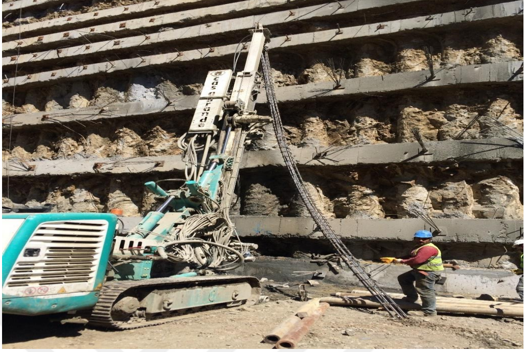
Şekil 4.6. Donatı kafesinin kuyuya indirilmesine ait görsel
