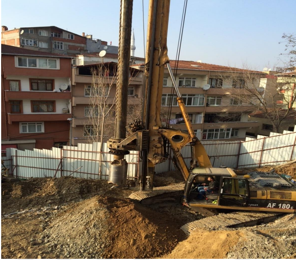
Şekil 4.1. Fore kazık imalat aşamasına ait görsel
