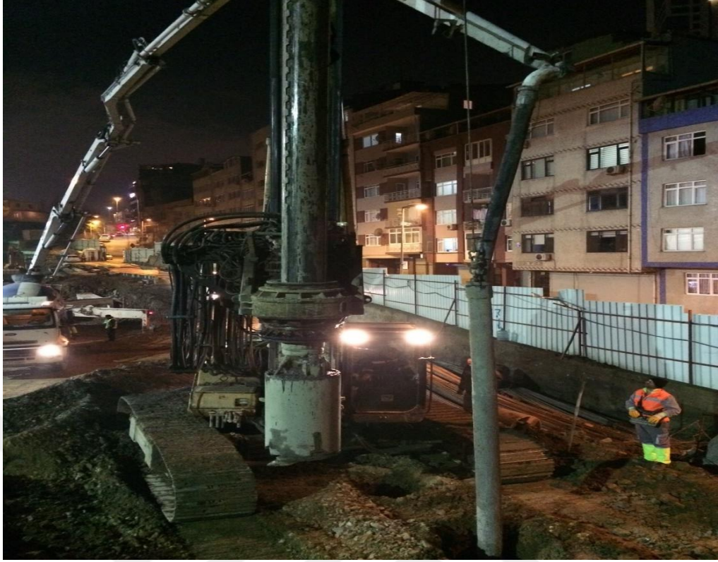
Şekil 4.4. Fore kazık betonlama imalatına ait görsel
