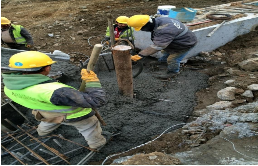
Şekil 4.16. Başlık kirişi betonunun vibratör yardımıyla yerleştirilmesi
