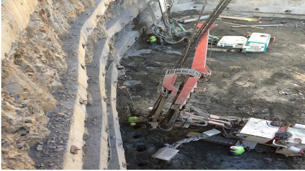
Şekil 4.5. Mini kazık imalat aşamasına ait görsel
