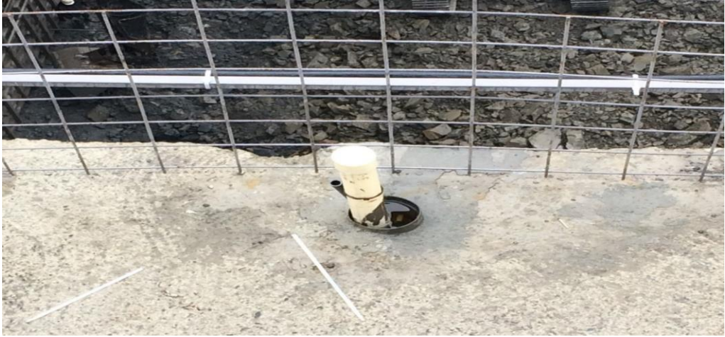
Şekil 4.17. İnklinometre borusunu gösteren görsel
