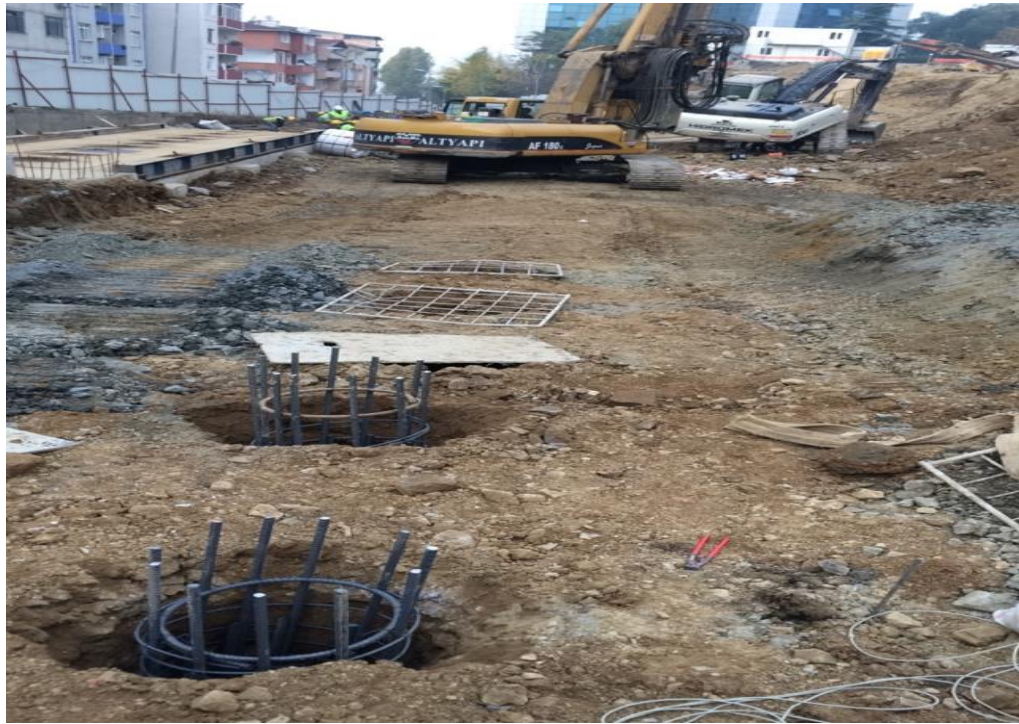
Şekil 4.3. Donatı kafesinin kuyu içindeki halini gösteren görsel
