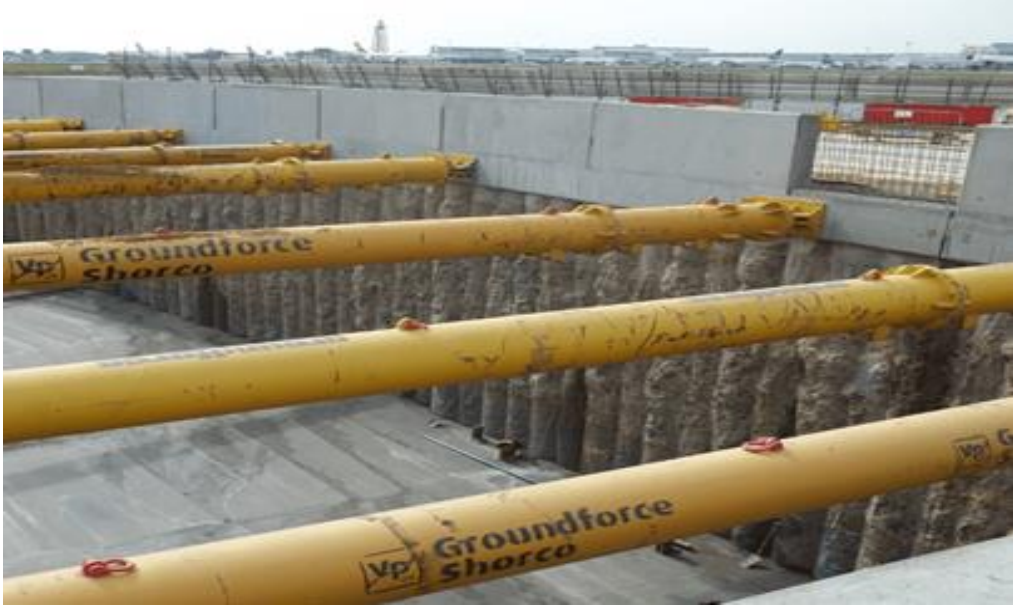
Şekil 1.9. Strut (boru destek) imalatına örnek olan bir görsel [16]
