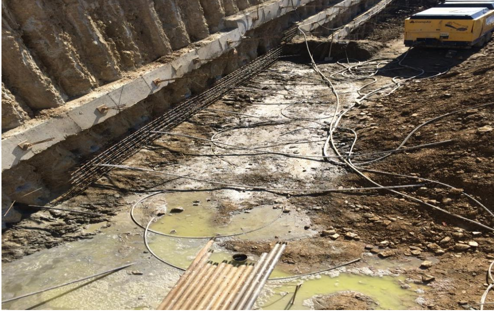
Şekil 4.13. Kuşak kirişi donatı montajını gösteren görsel
