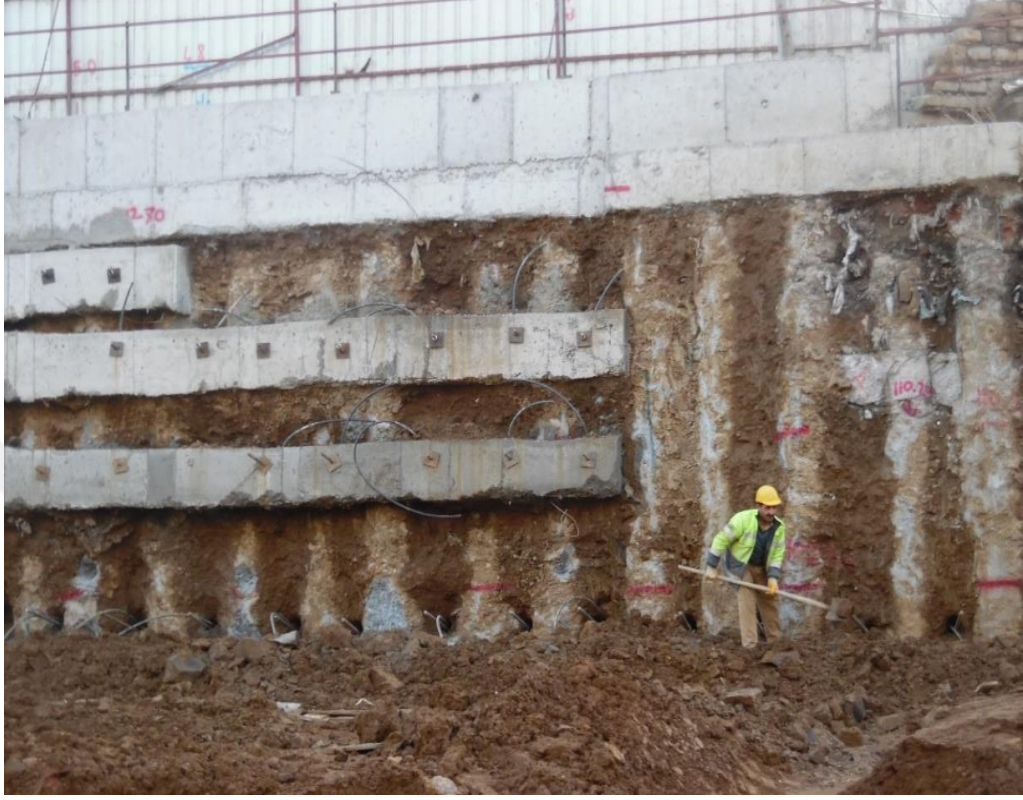
Şekil 4.10. Tendonların yerleştirildiğini gösteren görsel
