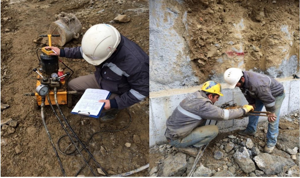
Şekil 4.12. Ankraj germe işlemine ait görsel
