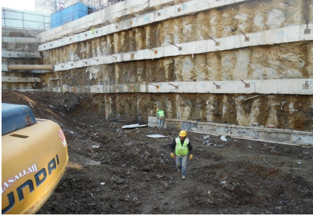
Şekil 4.14. Kuşak kirişi kalıp kapatılma aşamasına ait görsel
