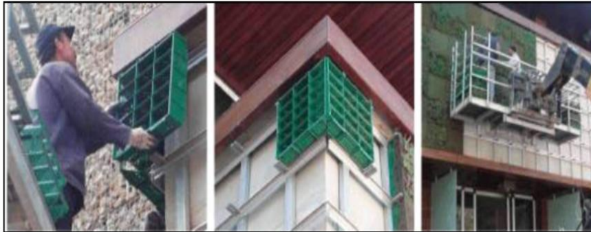
Şekil 2.18 Panel sistem ile dikey bahçe uygulaması, Panel modüler sistem (Erdoğan ve Khabbazi, 2013).
