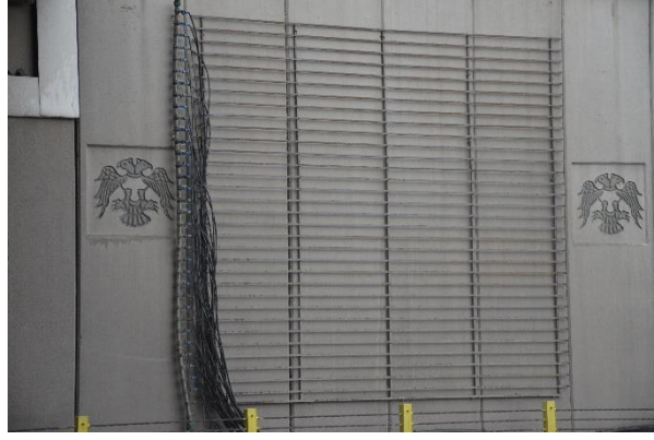
Şekil 4.2 Metal konstrüksiyon ve damlama su tesisatının duvara sabitlenmesi (Orijinal 2018).
