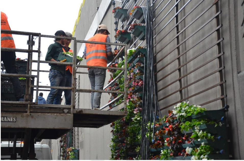
Şekil 4.5 Sille alt geçidi, yüklenici firma tarafından yapılan dikey bahçe uygulama görüntüleri (Orijinal 2018).
