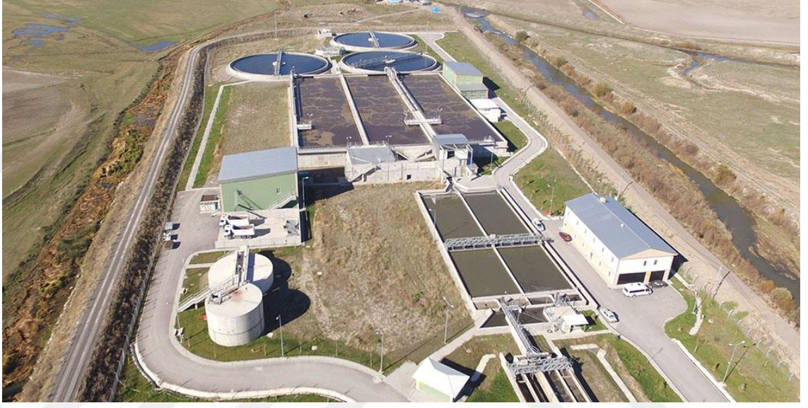
Şekil 3.3. Erzurum biyolojik atık su arıtma tesisi (Anonim 2018)
