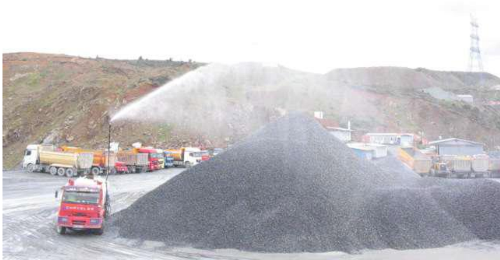
Şekil 5.3. Stok sahası sulama sistemi
