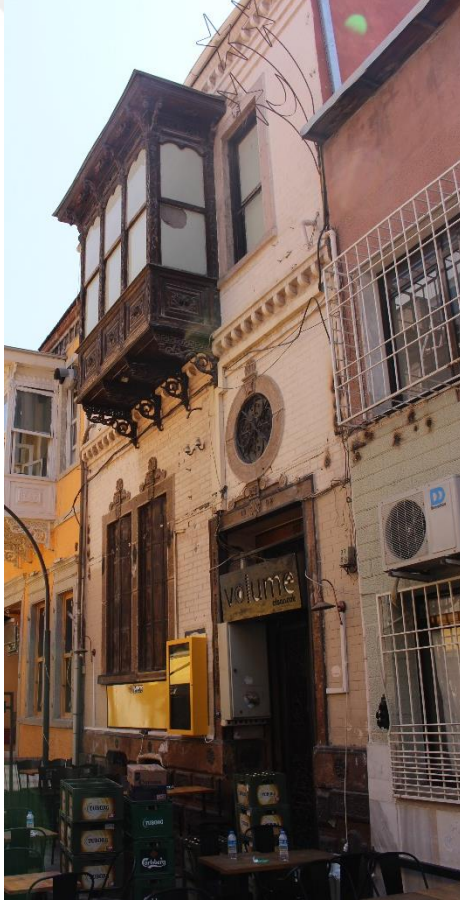
Fotoğraf 133. Alsancak Mahallesi, 1482 Sok., No:18, Konak adresindeki konutun genel görünüşü.
