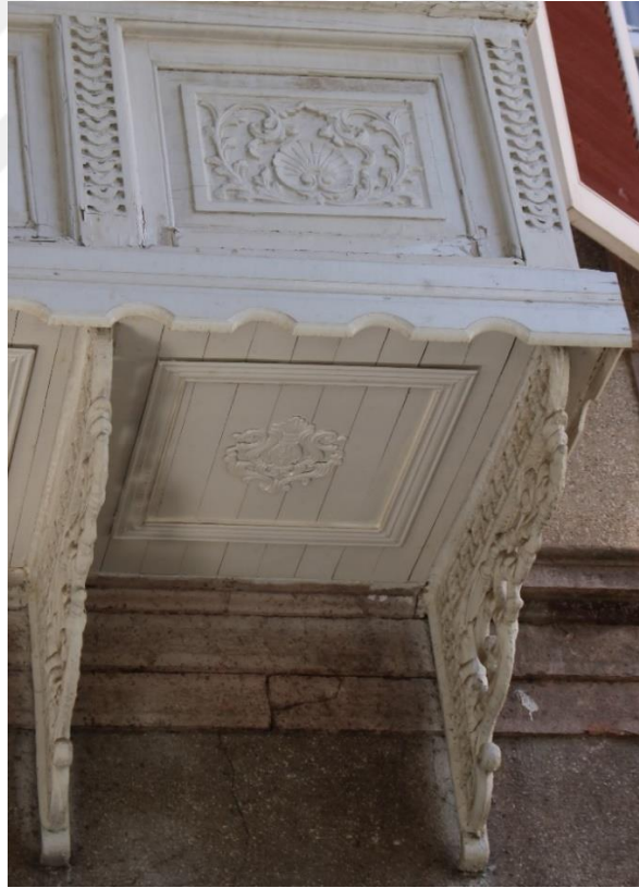
Fotoğraf 24. Göztepe Mahallesi, Mithatpaşa Cad., No:862, Konak adresindeki konutun cumba korkuluğu ve cumba alt yüzeyi.
