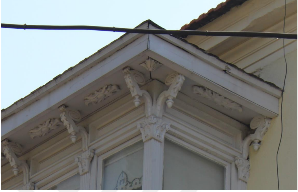
Fotoğraf 234. Dumlupınar Mahallesi, Uğur Mumcu Cad., No:47, Buca adresindeki konutun cumba saçak alt yüzeyi.
