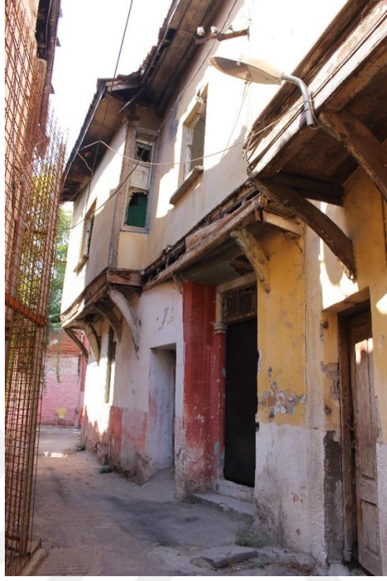
Fotoğraf 276. Pazaryeri Mahallesi, 945 Sok., No:32A, Konak adresindeki konutun genel görünüşü.
