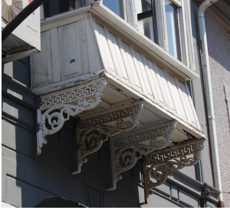
Fotoğraf 126. Alsancak Mahallesi, 1482 Sok., No:9A, Konak adresindeki konutun cumba korkuluğu.
