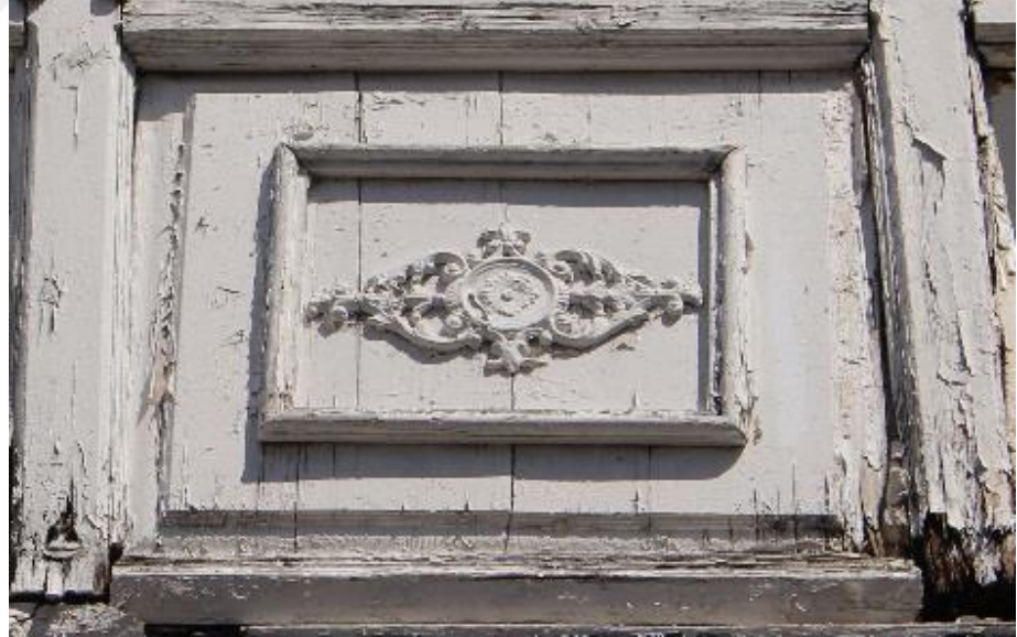
Fotoğraf 92. Alsancak Mahallesi, 1451 Sok., No:7, Konak adresindeki konutun cumba korkuluk panosu.
