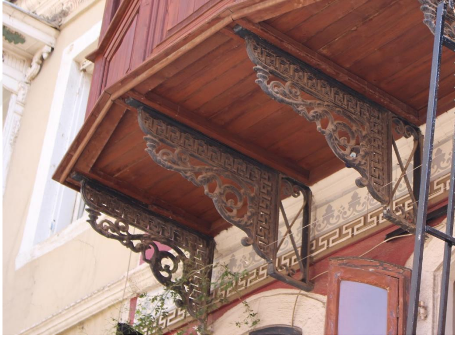
Fotoğraf 179. Alsancak Mahallesi, 1460 Sok., No:33-35, Konak adresindeki konutun cumba konsolu.
