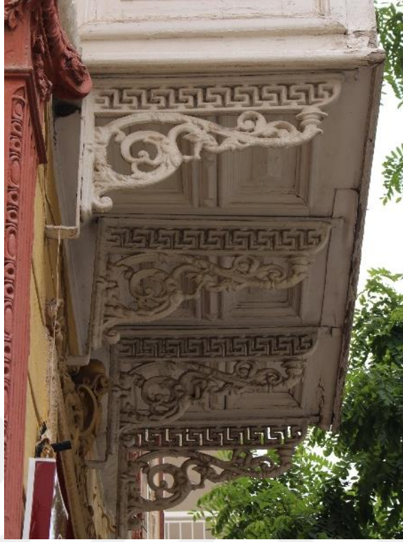
Fotoğraf 9. Güzelyalı Mahallesi, 59 Sok., No:17, Konak adresindeki konutun cumba alt yüzeyi ve cumba konsolları
