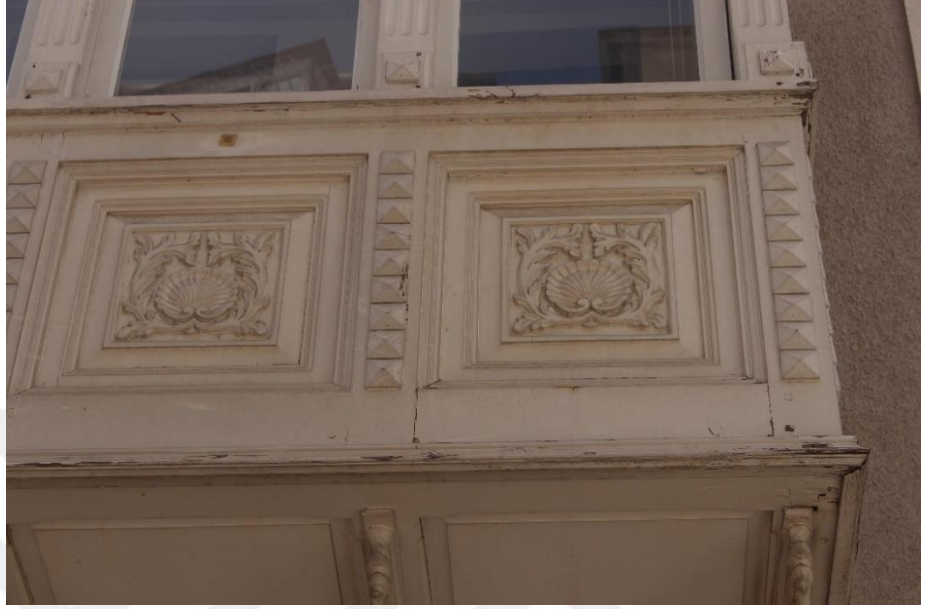
Fotoğraf 3. Güzelyalı Mahallesi, Mithatpaşa Cad., No:1021, Konak adresindeki konutun cumba korkuluğu
