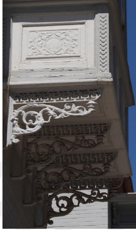
Fotoğraf 20. Göztepe Mahallesi, Mithatpaşa Cad., No:894-896, Konak adresindeki konutun cumba korkuluk ve konsol detayı.
