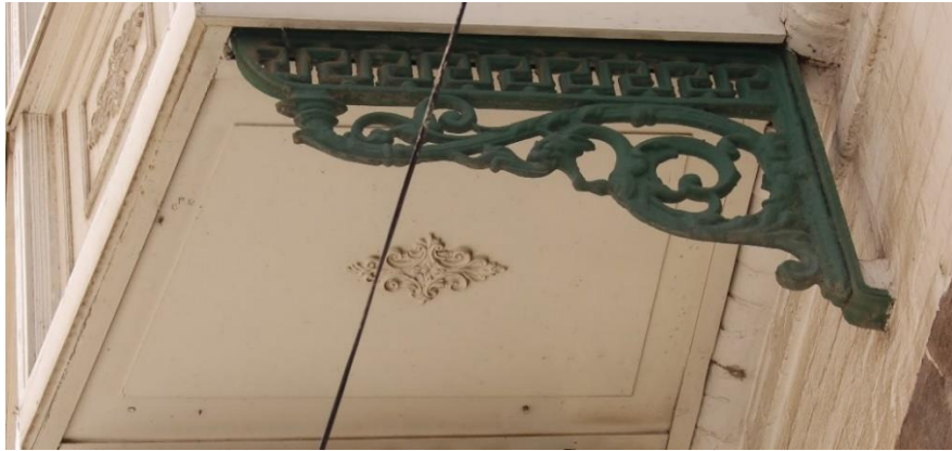
Fotoğraf 17. Göztepe Mahallesi, 77 Sok., No:18, Konak adresindeki konutun cumba alt yüzeyi ve konsolu.
