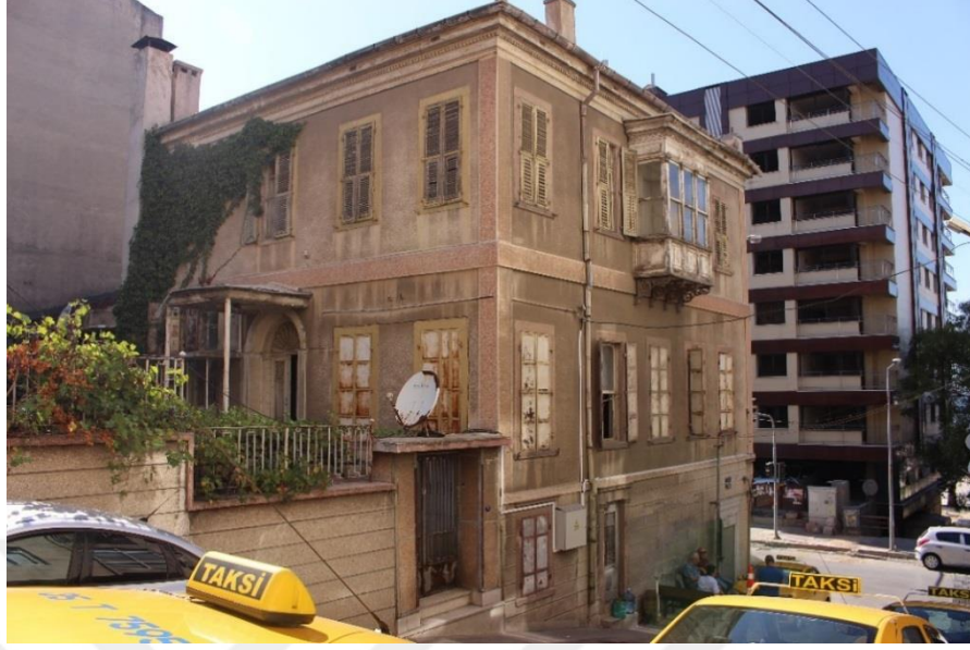
Fotoğraf 50. Mithatpaşa Mahallesi, Mithatpaşa Cad., No:2- 2 A, Konak adresindeki konutun yan cephesinden genel görünüş.
