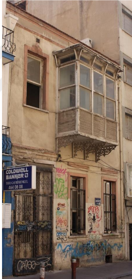
Fotoğraf 76. Alsancak Mahallesi, Cumhuriyet Bul., No:244, Konak adresindeki konutun genel görünüşü
