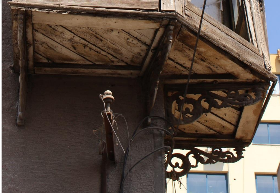
Fotoğraf 187A. Alsancak Mahallesi, 1468 Sok. ve 1464 Sok. kesişimi., No:79, Konak adresindeki konutun cumba konsolları.
