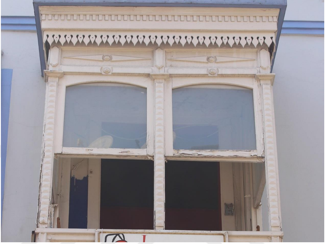
Fotoğraf 110. Alsancak Mahallesi, 1453 Sok., No:26, Konak adresindeki konutun cumba pencereleri ve saçağı.
