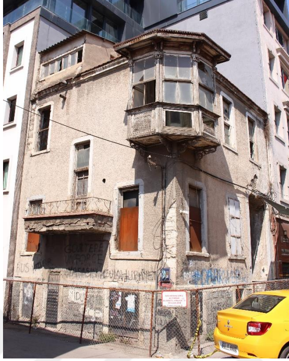
Fotoğraf 185. Alsancak Mahallesi,1468 Sok. ve 1464 Sok. kesişimi., No:79, Konak adresindeki konutun genel görünüşü.
