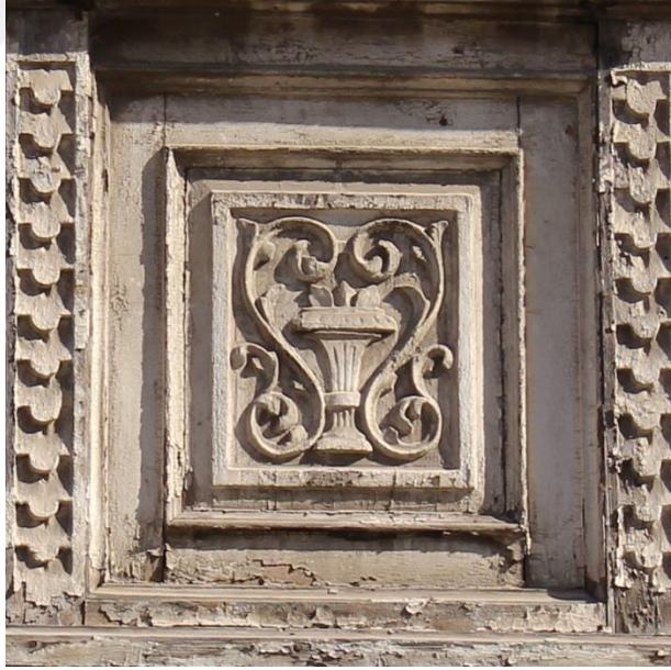
Fotoğraf 49A. Mithatpaşa Mahallesi, Mithatpaşa Cad., No:2- 2 A, Konak adresindeki konutun ön cephede yer alan cumbasından pano detayı.
