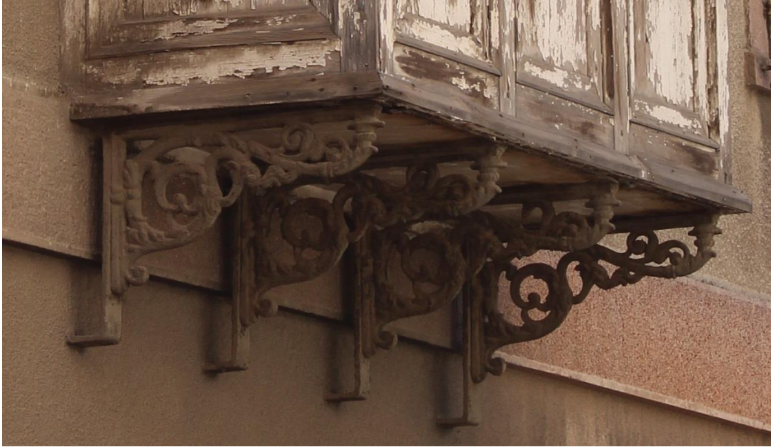
Fotoğraf 51B. Mithatpaşa Mahallesi, Mithatpaşa Cad., No:2- 2 A, Konak adresindeki konutun yan cephede yer alan cumbasından konsol detayı.
