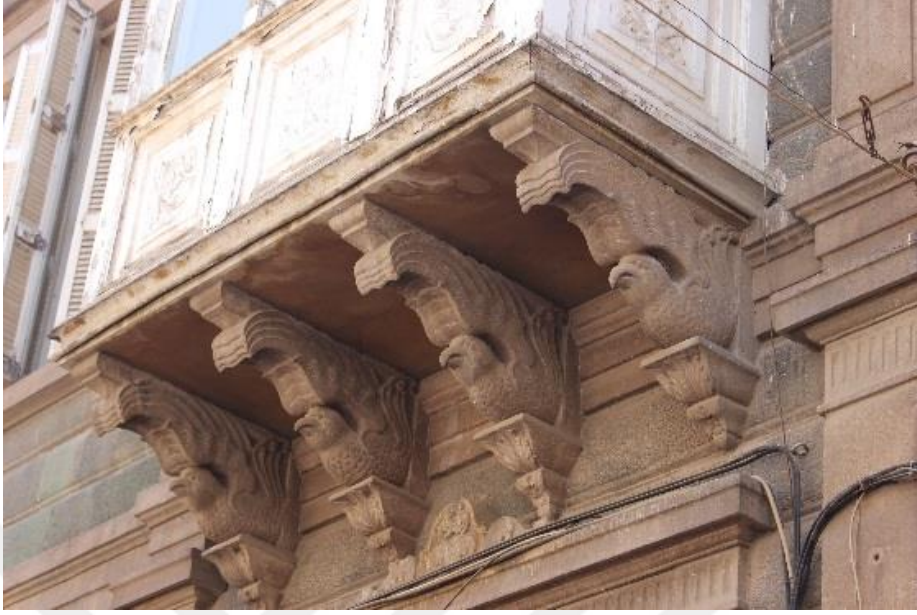
Fotoğraf 131. Alsancak Mahallesi, Muzaffer İzgü Sok., No:14, Konak adresindeki konutun cumba konsolları.
