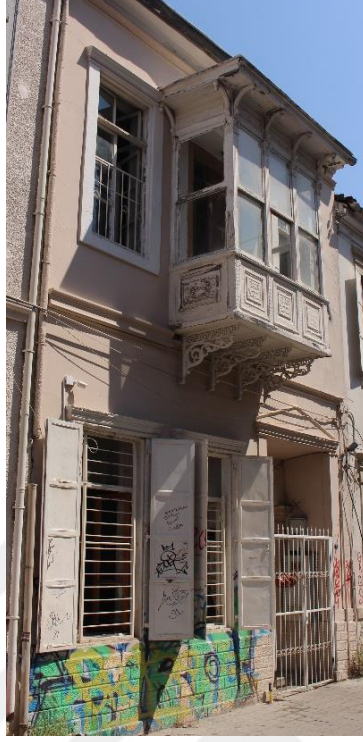
Fotoğraf 93. Alsancak Mahallesi, 1451 Sok., No: 11, Konak adresindeki konutun genel görünüşü.
