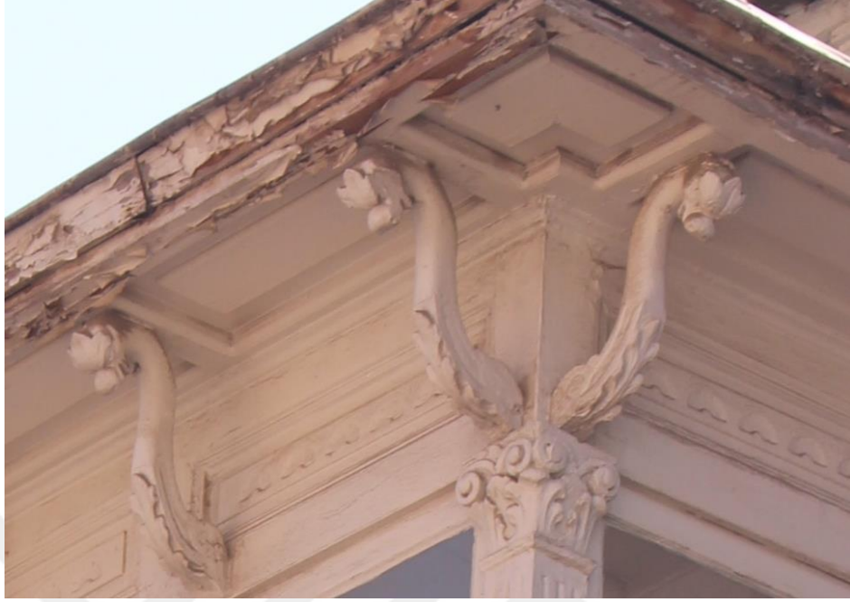
Fotoğraf 174.. Alsancak Mahallesi, 1462 Sok., No:50-52A Konak adresindeki konutun cumba saçağı.
