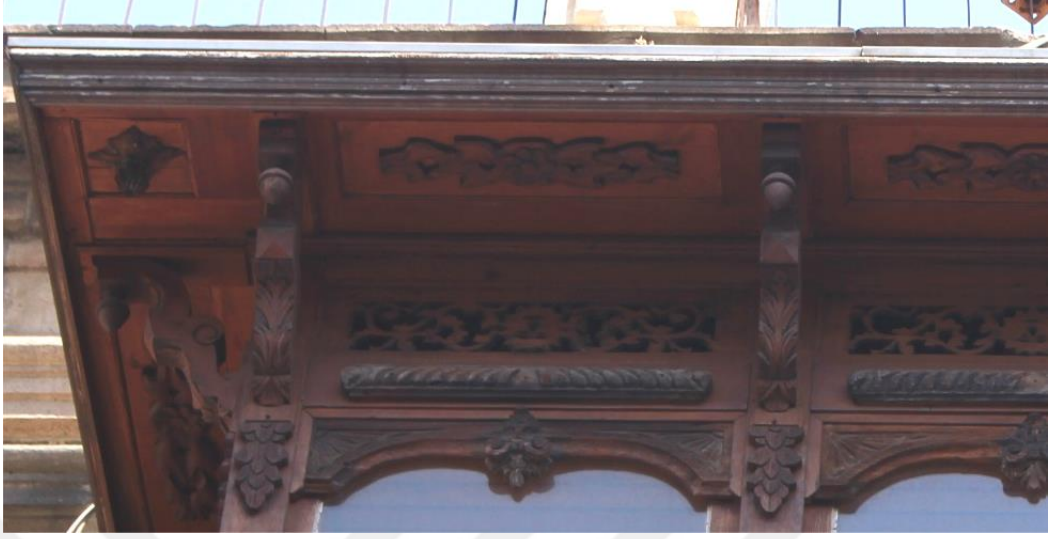
Fotoğraf 106. Alsancak Mahallesi, 1453 Sok., No: 19- 19A, Konak adresindeki konutun cumba saçağı.
