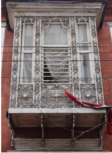
Fotoğraf 201. Akıncı Mahallesi, 945 Sok., No:18, Konak adresindeki konutun cumbası.
