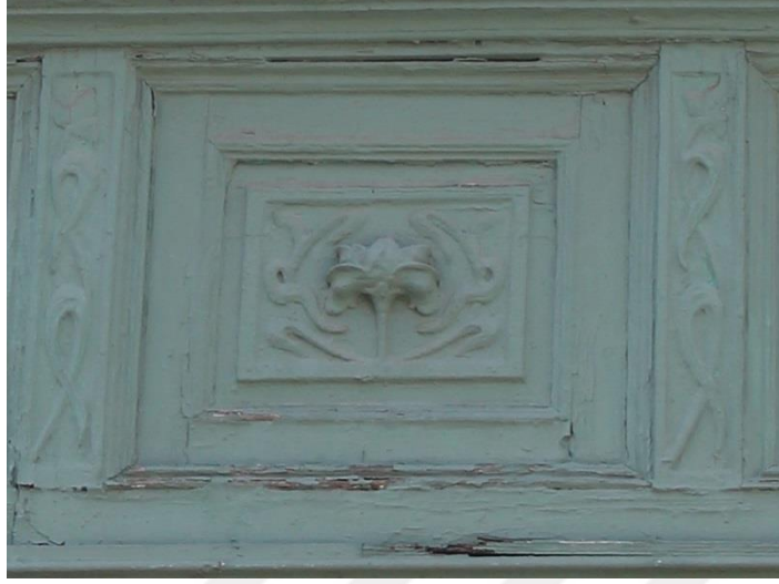
Fotoğraf 98C. Alsancak Mahallesi, 1453 Sok., No:18, Konak adresindeki konutun cumba panosu.
