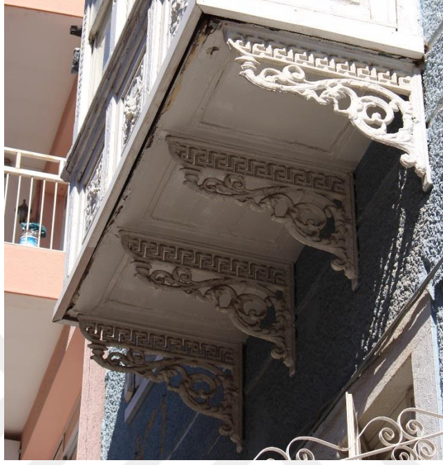
Fotoğraf 33A. Çankaya Mahallesi, 141 Sok., No:51- 51 A- 51 B, Konak adresindeki konutun konsol detayı.
