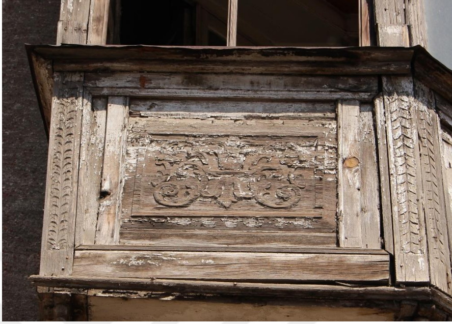
Fotoğraf 187. Alsancak Mahallesi, 1468 Sok. ve 1464 Sok. kesişimi., No:79, Konak adresindeki konutun cumba korkuluk panosu.
