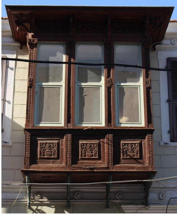
Fotoğraf 44. Mithatpaşa Mahallesi, 211 Sok. No:2, Konak adresindeki konutun cumbası.
