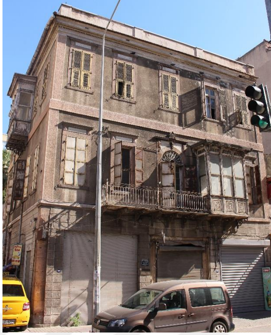
Fotoğraf 47. Mithatpaşa Mahallesi, Mithatpaşa Cad., No:2- 2 A, Konak adresindeki konutun ön cepheden genel görünüşü.
