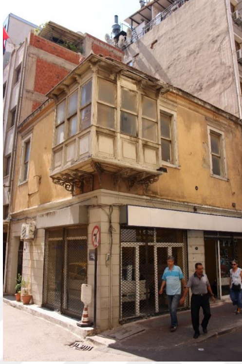
Fotoğraf 192. Alsancak Mahallesi, 1464 Sok. ve 1469 Sok. kesişimi, No:85, Konak adresindeki konutun genel görünüşü.
