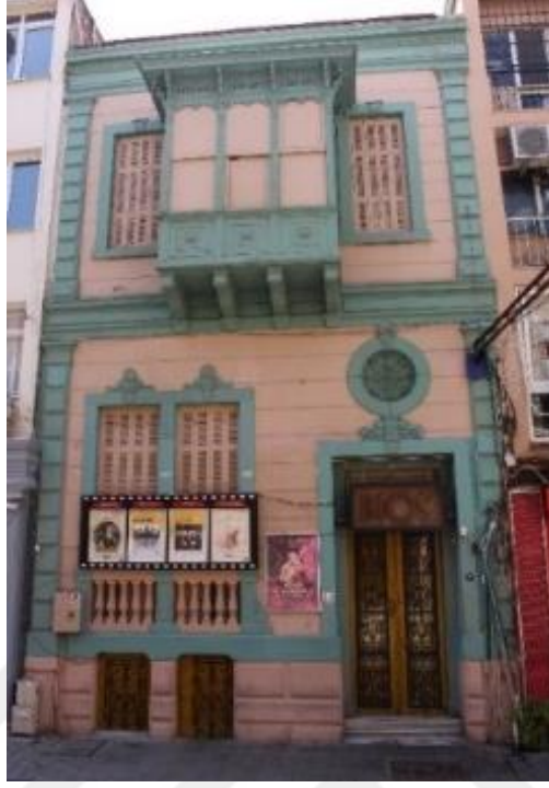
Fotoğraf 97. : Alsancak Mahallesi, 1453 Sok., No:18, Konak adresindeki konutun genel görünüşü.
