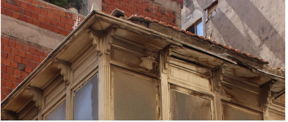
Fotoğrad 194. Alsancak Mahallesi, 1464 Sok. ve 1469 Sok. kesişimi, No:85, Konak adresindeki konutun cumba saçağı.
