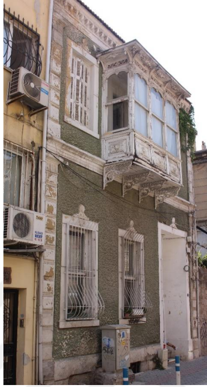
Fotoğraf 151. Alsancak Mahallesi, 1469 Sok., No:6, Konak. konutun genel görünüşü.
