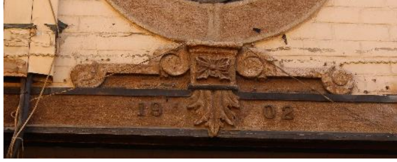
Fotoğraf 132. Alsancak Mahallesi, 1482 Sok., No:18, Konak adresindeki konutun giriş açıklığı.
