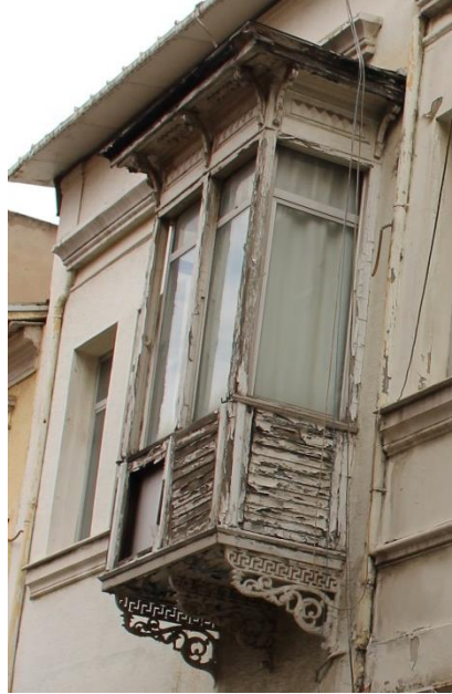
Fotoğraf 197. Akıncı Mahallesi, 1296 Sok., No:25, Konak adresindeki konutun ön cephesinde yer alan cumbası.
