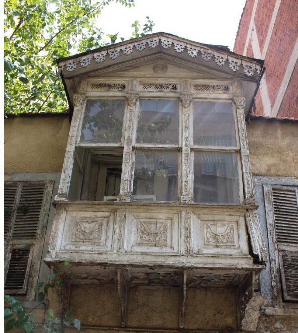
Fotoğraf 253. Tuna Mahallesi, Şehit Üsteğmen Ahmet Konuksever Sok., No:46, Karşıyaka adresindeki konutun cumbası.
