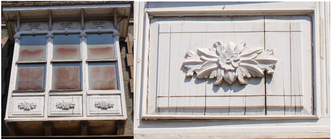
Fotoğraf 103. Alsancak Mahallesi, 1453 Sok., No:17, Konak adresindeki konutun cumbası ve cumba panosundan detay.
