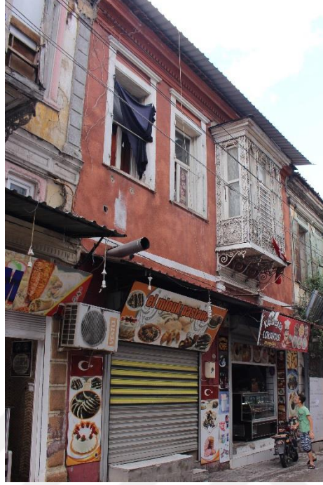
Fotoğraf 200. Akıncı Mahallesi, 945 Sok., No:18, Konak adresindeki konutun genel görünüşü.
