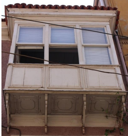
Fotoğraf 59. Turgut Reis Mahallesi, Şehit Kemal Keser Sok., No:59- 59 A, Konak adresindeki konutun cumbası.
