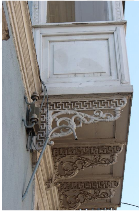
Fotoğraf 227. Dumlupınar Mahallesi ,Uğur Mumcu Cad., No:15, Buca adresindeki konutun cumba konsolları.
