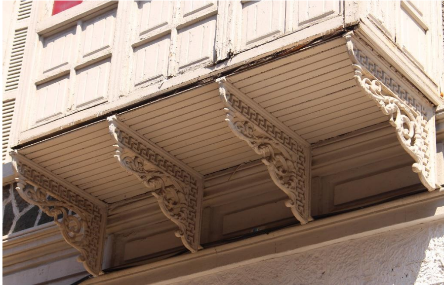
Fotoğraf 96B. Alsancak Mahallesi, 1453 Sok., No:11, Konak adresindeki konutun cumba korkulukları.
