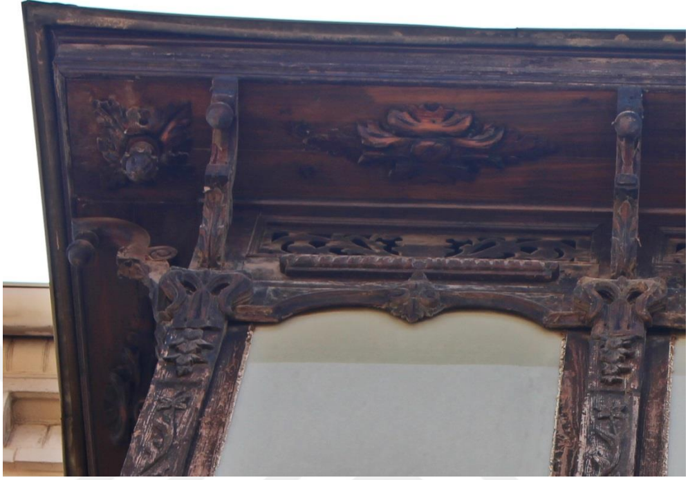
Fotoğraf 135. Alsancak Mahallesi, 1482 Sok., No:18, Konak adresindeki konutun cumba saçak alt yüzeyi.
