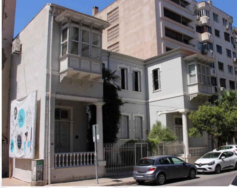
Fotoğraf 18. Göztepe Mahallesi, Mithatpaşa Cad., No:894-896, Konak adresindeki konutun genel görünüşü.
