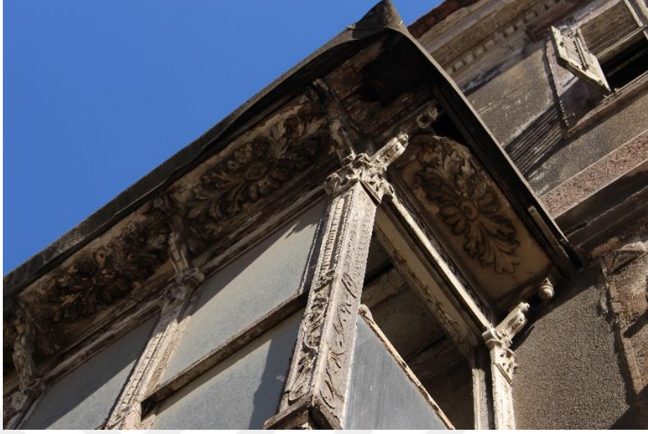
Fotoğraf 49. Mithatpaşa Mahallesi, Mithatpaşa Cad., No:2- 2 A, Konak adresindeki konutun ön cephede yer alan cumbasından saçak detayı.
