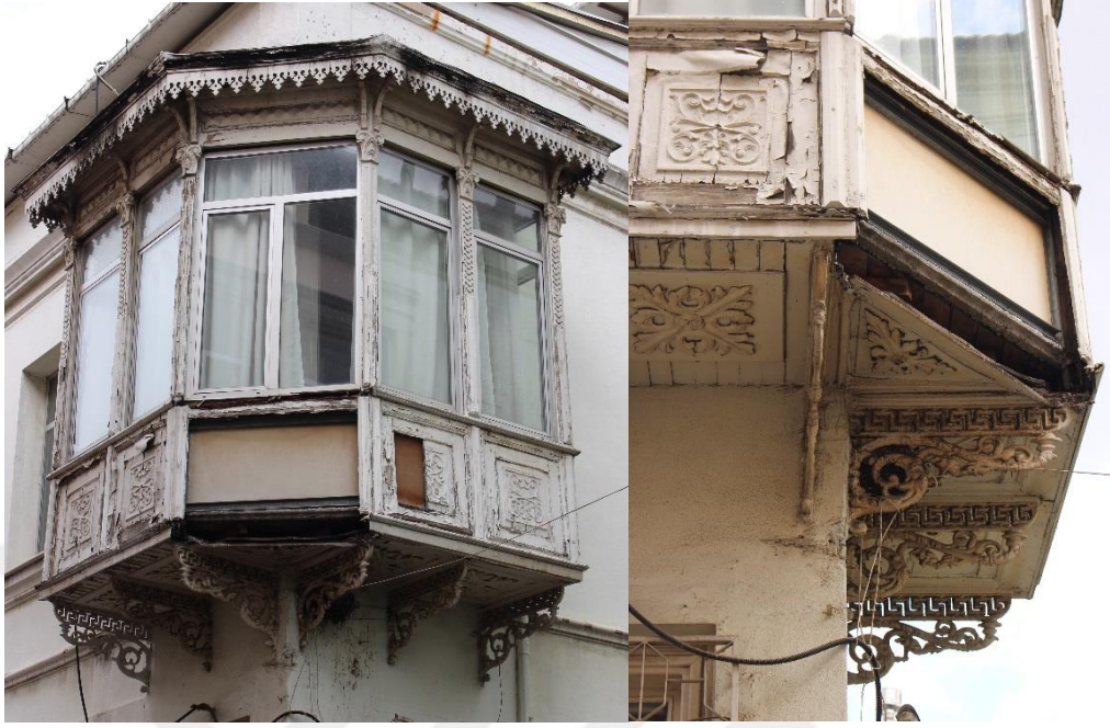
Fotoğraf 198. Akıncı Mahallesi, 1296 Sok., No:25, Konak adresindeki konutun köşede yer alan cumbası ve cumba alt yüzeyi.
