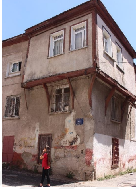
Fotoğraf 278. Pazaryeri Mahallesi, 954 Sok., No:2- 2A, Konak adresindeki konutun genel görünüşü.
