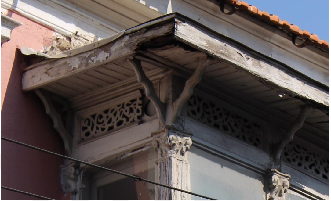
Fotoğraf 223. Vali Rahmi Bey Mahallesi ,Uğur Mumcu Cad., No:16, Buca adresindeki konutun saağı.
