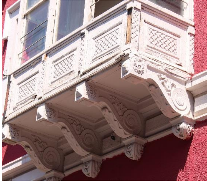
Fotoğraf 101. Alsancak Mahallesi, 1453 Sok., No:15, Konak adresindeki konutun cumba konsolları.
