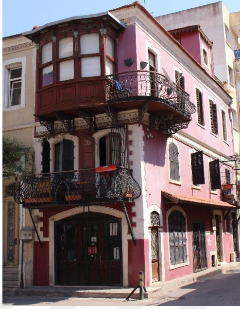
Fotoğraf 176. Alsancak Mahallesi, 1460 Sok., No:33-35, Konak adresindeki konutun genel görünüşü.
