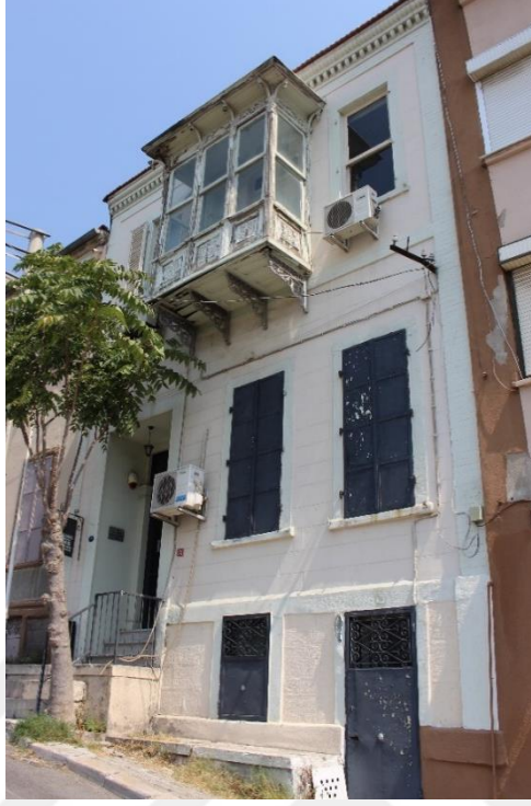
Fotoğraf 248. Bayraklı Mahallesi, 1642 Sok., No:12, Bayraklı adresindeki konutun genel görünüşü.
