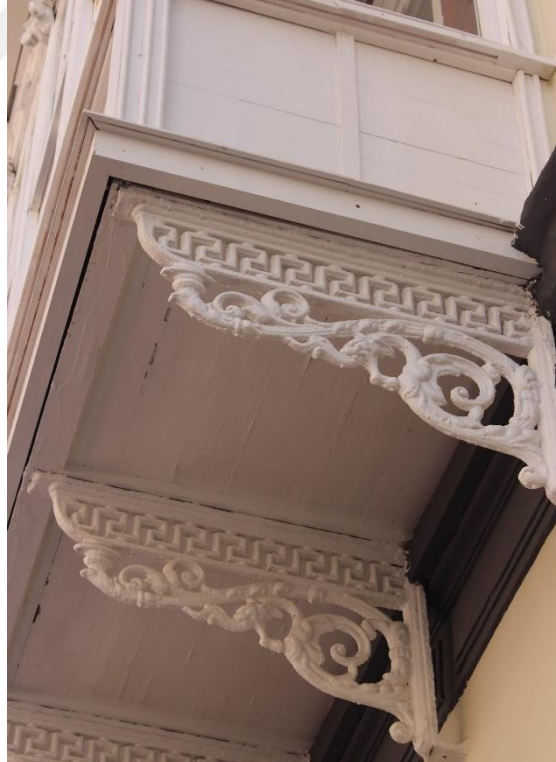
Fotoğraf 85A. Alsancak Mahallesi, Cumhuriyet Bul., No:240, Konak adresindeki konutun cumba konsol detayı.
