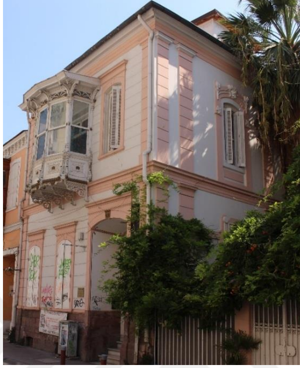
Fotoğraf 72. Alsancak Mahallesi, Cumhuriyet Bul., No:248, Konak adresindeki konutun genel görünüşü.
