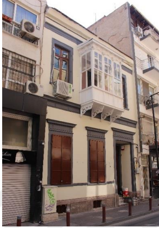
Fotoğraf 83. Alsancak Mahallesi, Cumhuriyet Bul., No:240, Konak.adresindeki konutun genel görünüşü.
