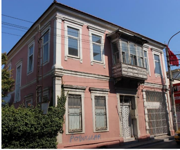
Fotoğraf 221. Vali Rahmi Bey Mahallesi ,Uğur Mumcu Cad., No:16, Buca adresindeki konutun genel görünüşü.
