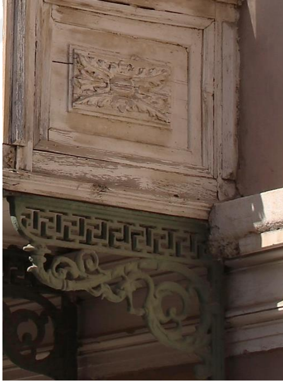
Fotoğraf 40. Çankaya Mahallesi, 141 Sok., No:9, Konak adresindeki konutun cumba konsol detayı.
