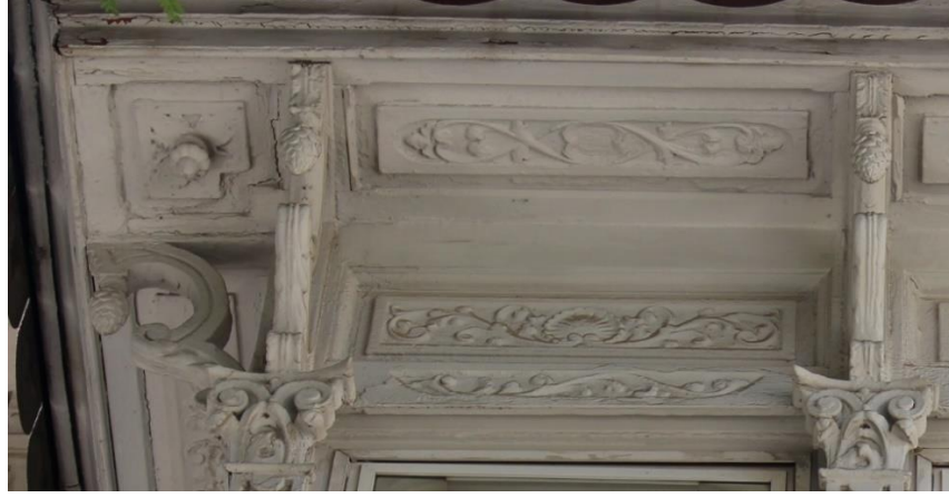
Fotoğraf 23. Göztepe Mahallesi, Mithatpaşa Cad., No:862, Konak adresindeki konutun cumba saçağı.
