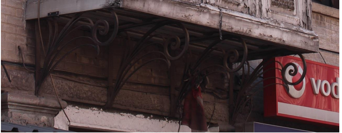
Fotoğraf 220. Dumlupınar Mahallesi, Uğur Mumcu Cad. No:11, Buca adresindeki konutun cumba konsolları.
