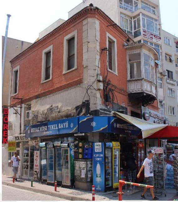
Fotoğraf 256. Donanmacı Mahallesi, 1728 Sok. ve Kemalpaşa Cad. kesişimi, No:1, Karşıyaka adresindeki konutun genel görünüşü.
