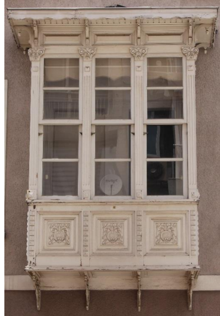
Fotoğraf 2. Güzelyalı Mahallesi, Mithatpaşa Cad., No:1021, Konak adresindeki konutun cumbası
