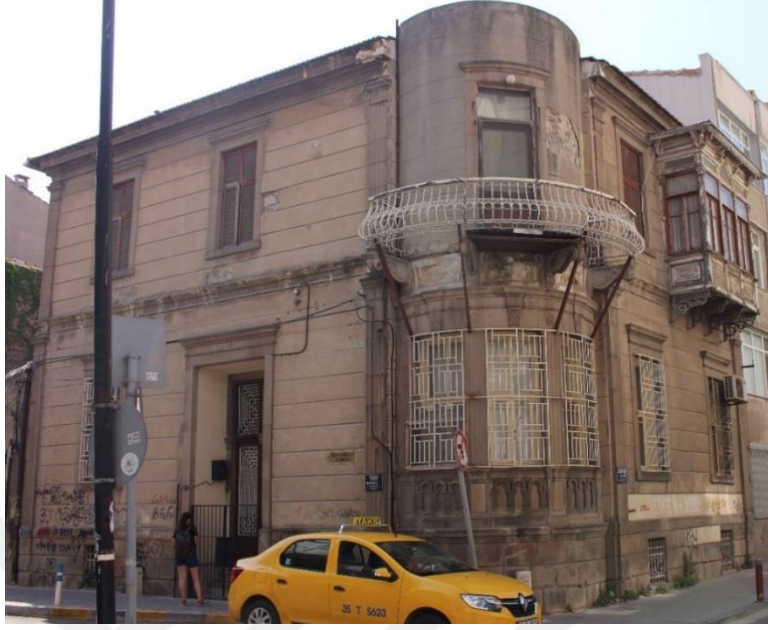
Fotoğraf 62. Alsancak Mahallesi, Cumhuriyet Bul., No:4, Konak adresindeki konutun genel görünüşü.
