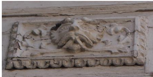
Fotoğraf 155. Alsancak Mahallesi, 1469 Sok., No:6, Konak adresindeki konutun cumba korkuluk panosu.
