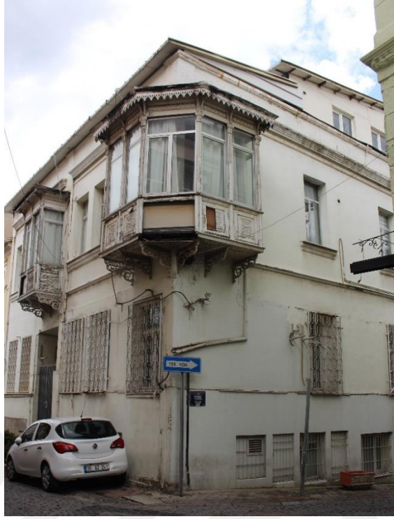
Fotoğraf 196. Akıncı Mahallesi, 1296 Sok., No:25, Konak adresindeki konutun genel görünüşü.
