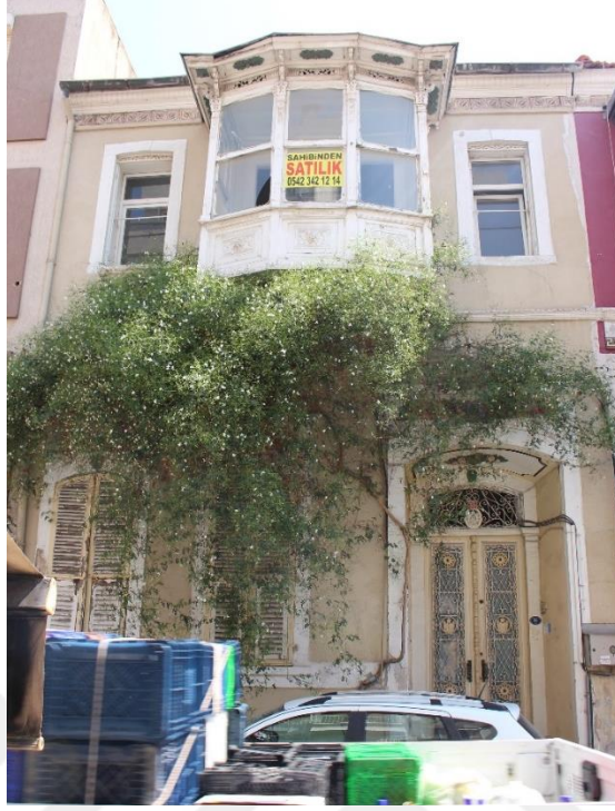
Fotoğraf 180. Alsancak Mahallesi, 1460 Sok., No:35, Konak adresindeki konutun genel görünüşü.
