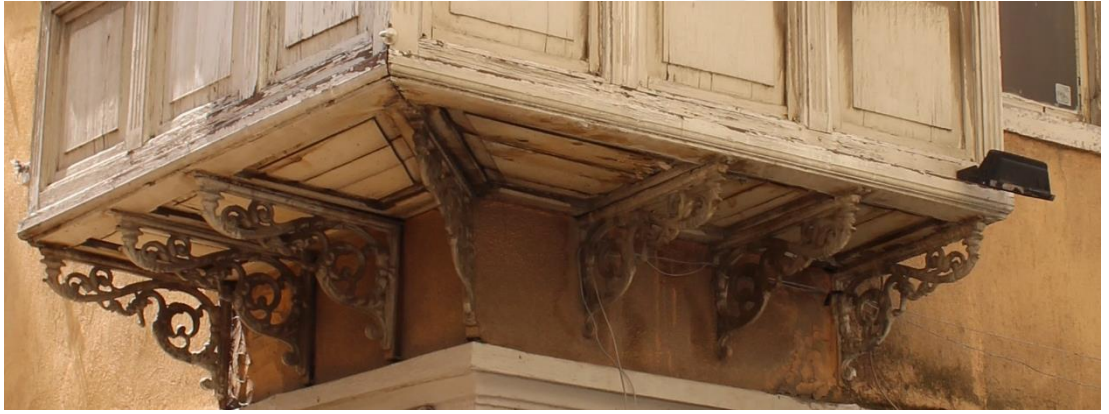
Fotoğraf 195. Alsancak Mahallesi, 1464 Sok. ve 1469 Sok. kesişimi, No:85, Konak adresindeki konutun cumba konsolları.
