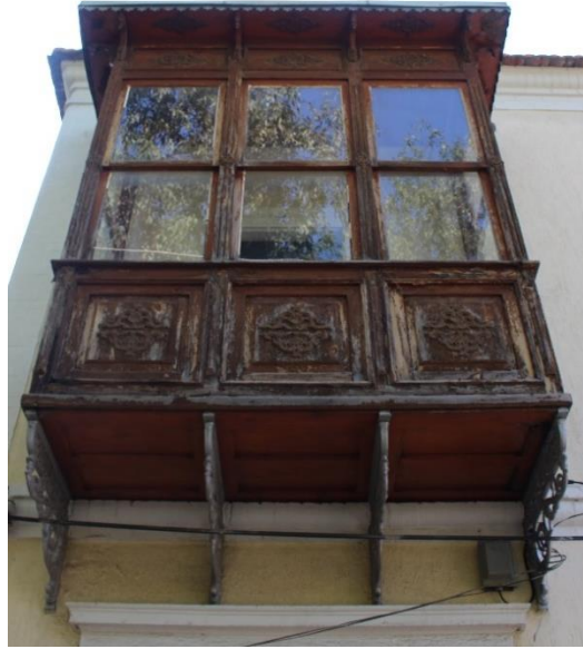
Fotoğraf 214. Dumlupınar Mahallesi, 77 ve 79 Sok. kesişimi No:9, Buca adresindeki konutun cumbası.
