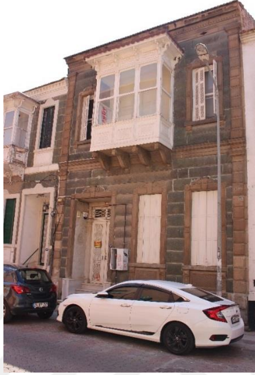
Fotoğraf 168. Alsancak Mahallesi, 1462 Sok., No:48, Konak adresindeki konutun genel görünüşü.
