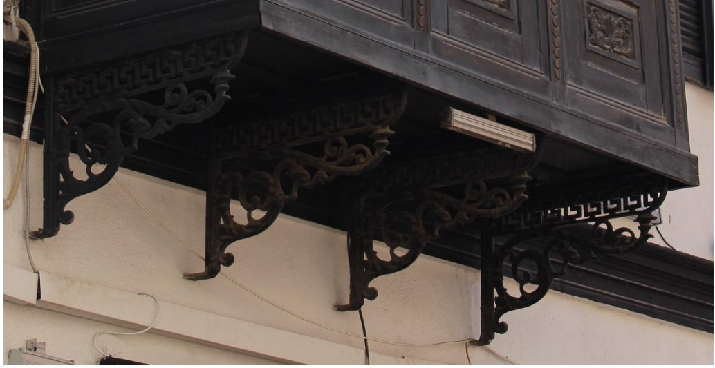
Fotoğraf 88A. Alsancak Mahallesi, Cumhuriyet Bul., No:224, Konak adresindeki konutun cumba konsol detayı.
