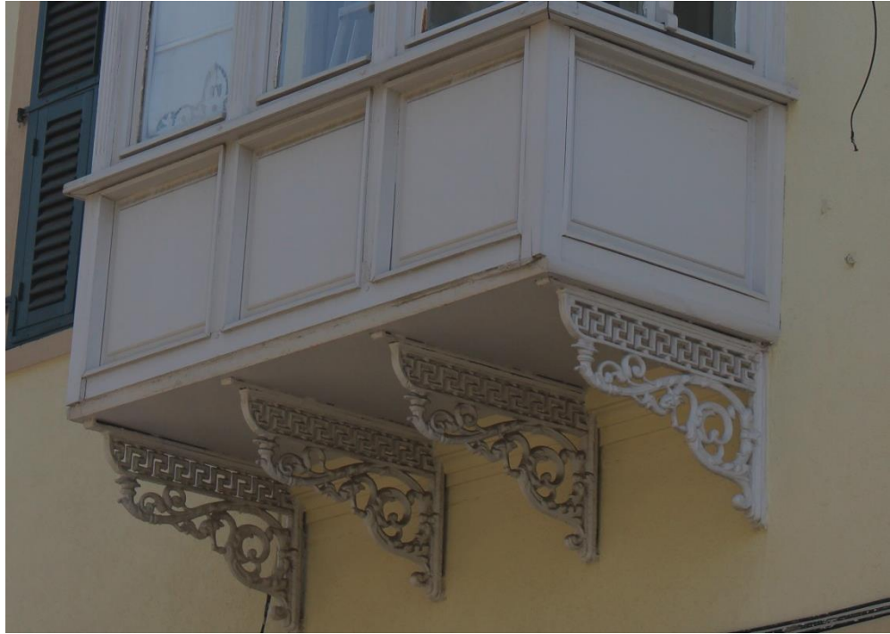
Fotoğraf 235. Dumlupınar Mahallesi, Uğur Mumcu Cad., No:47, Buca adresindeki konutun cumba konsolları.
