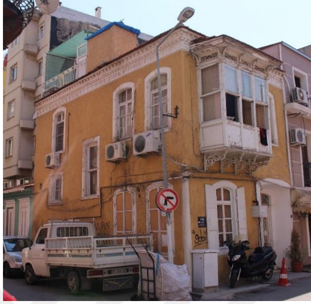
Fotoğraf 188. Alsancak Mahallesi,1460 Sok. ve 1464 Sok. kesişimi., No:39, Konak adresindeki konutun genel görünüşü.
