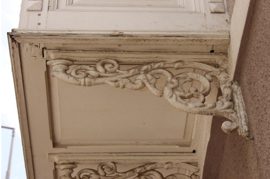
Fotoğraf 4. Güzelyalı Mahallesi, Mithatpaşa Cad., No:1021, Konak adresindeki konutun cumba konsolları.
