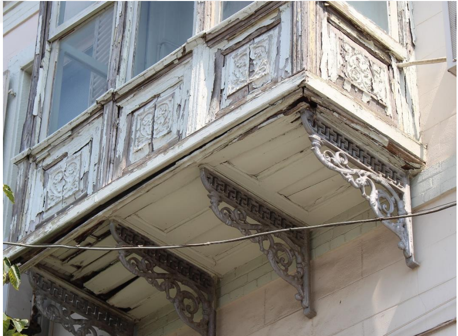
Fotoğraf 251. Bayraklı Mahallesi, 1642 Sok., No:12, Bayraklı adresindeki konutun cumba korkuluğu ve konsolları.
