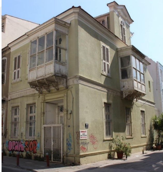
Fotoğraf 66. Alsancak Mahallesi, Cumhuriyet Bul., No:266, Konak adresindeki konutun genel görünüşü.
