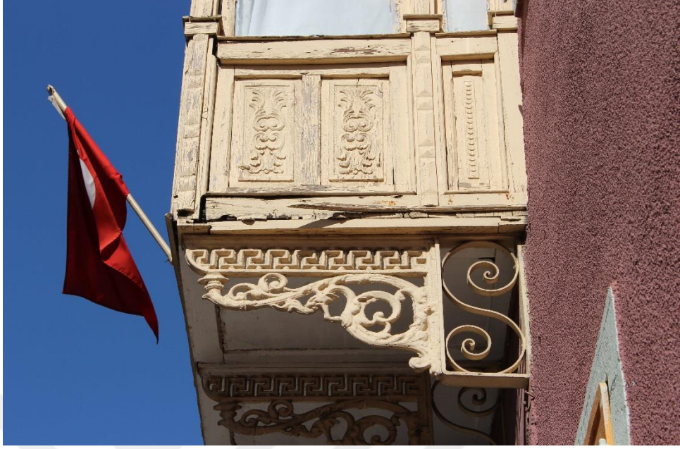
Fotoğraf 36. Çankaya Mahallesi, 141 Sok., No:53, Konak adresindeki konutun cumba korkuluğu ve cumba konsolları.
