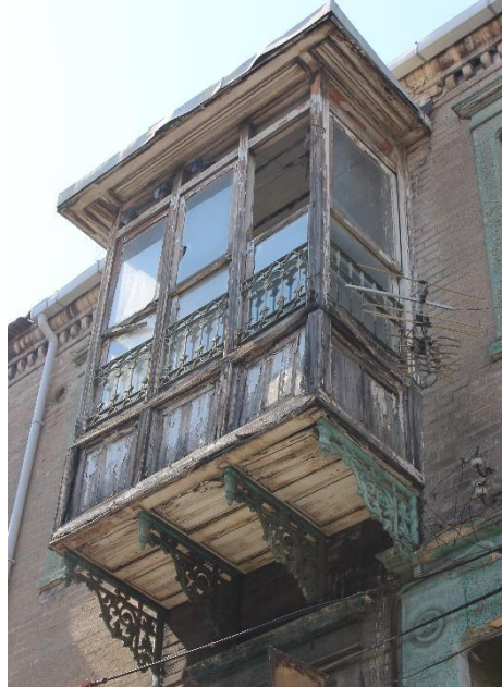
Fotoğraf 211. Kurtuluş Mahallesi, 940 Sok, No: 4, Konak adresindeki konutun cumbası.
