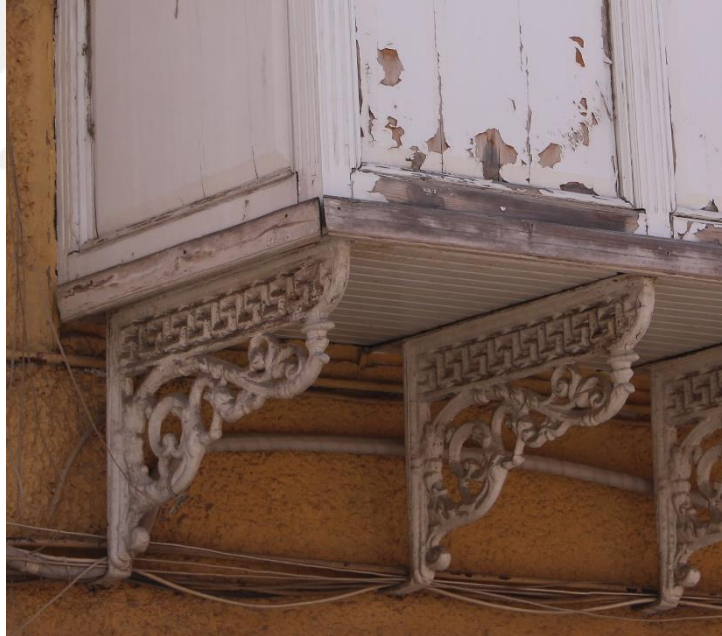
Fotoğraf 191. Alsancak Mahallesi,1460 Sok. ve 1464 Sok. kesişimi., No:39, Konak adresindeki konutun cumba konsolları.
