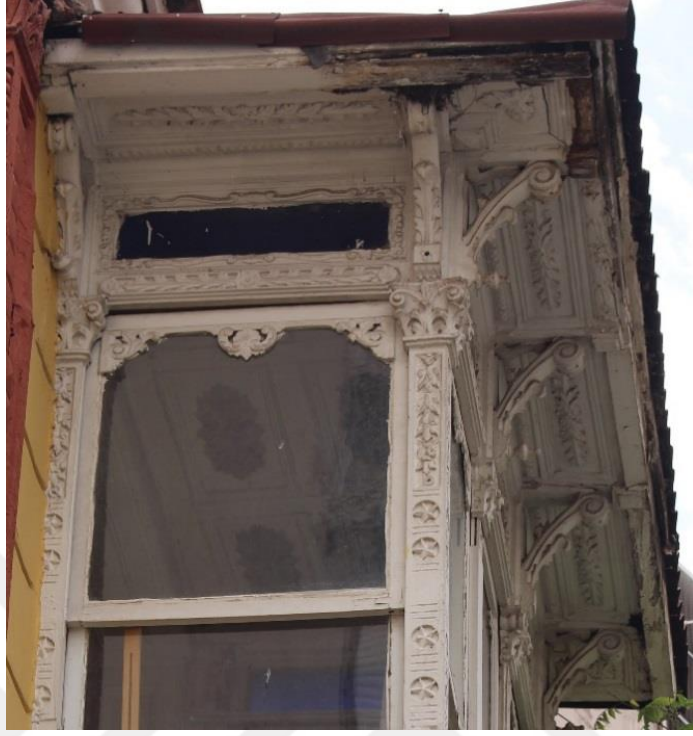
Fotoğraf 7. Güzelyalı Mahallesi, 59 Sok., No:17, Konak adresindeki konutun cumba saçığı.
