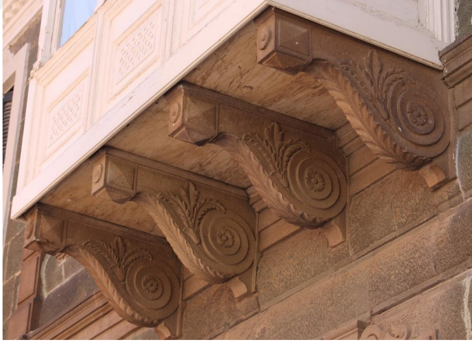
Fotoğraf 171. Alsancak Mahallesi, 1462 Sok., No:48, Konak adresindeki konutun cumba konsolları.
