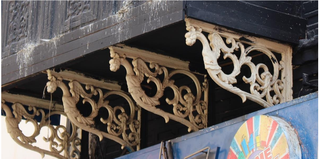
Fotoğraf 265. Donanmacı Mahallesi, Hüseyin Çağlayan Sok., no:6, Karşıyaka adresindeki konutun cumba konsolları.
