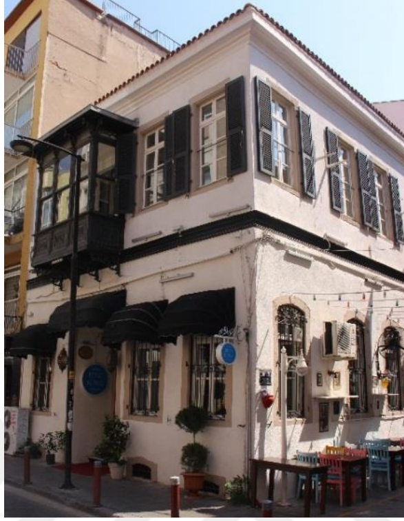
Fotoğraf 86. Alsancak Mahallesi, Cumhuriyet Bul., No:224, Konak adresindeki konutun genel görünüşü.
