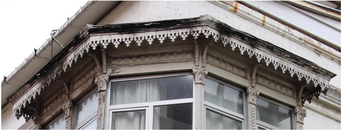
Fotoğraf 199. Akıncı Mahallesi, 1296 Sok., No:25, Konak adresindeki konutun köşede yer alan cumbasının saçağı.
