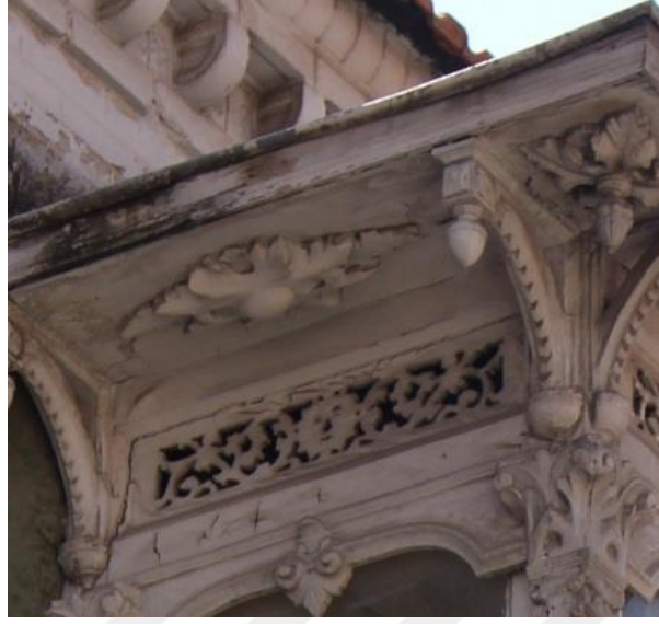
Fotoğraf 153. Alsancak Mahallesi, 1469 Sok., No:6, Konak adresindeki konutun cumba saçak alt yüzeyi.
