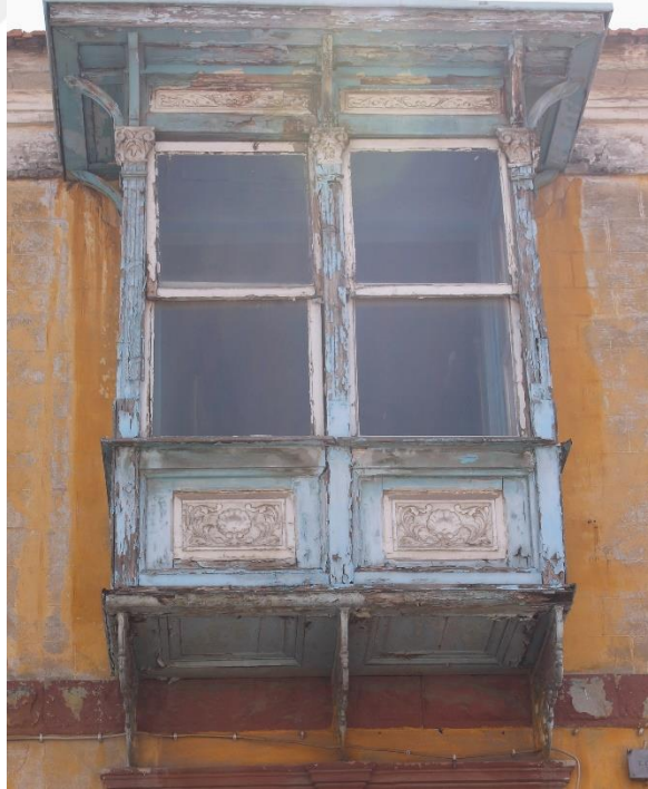
Fotoğraf 207. Pazaryeri Mahallesi, 946 Sok., No: 1. Konak adresindeki konutun cumbası.
