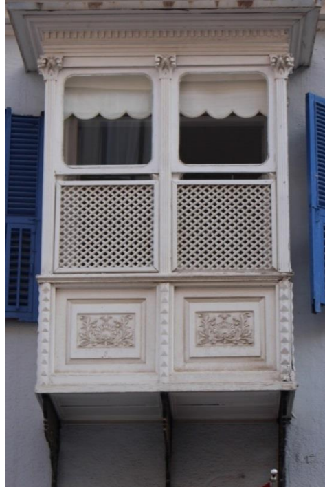
Fotoğraf 57. Mithatpaşa Mahallesi, Mithatpaşa Cad., No:441, Konak
