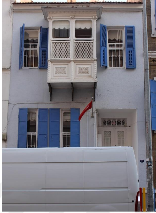
Fotoğraf 56. Mithatpaşa Mahallesi, Mithatpaşa Cad., No:441, Konak adresindeki konutun genel görünüşü.
