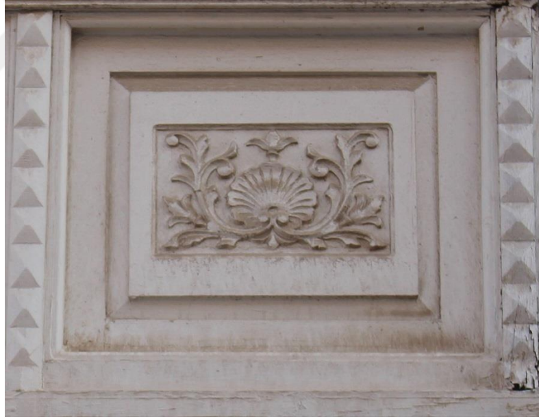
Fotoğraf 57B. Mithatpaşa Mahallesi, Mithatpaşa Cad., No:441, Konak adresindeki konutun cumba korkuluk panosundan detay.
