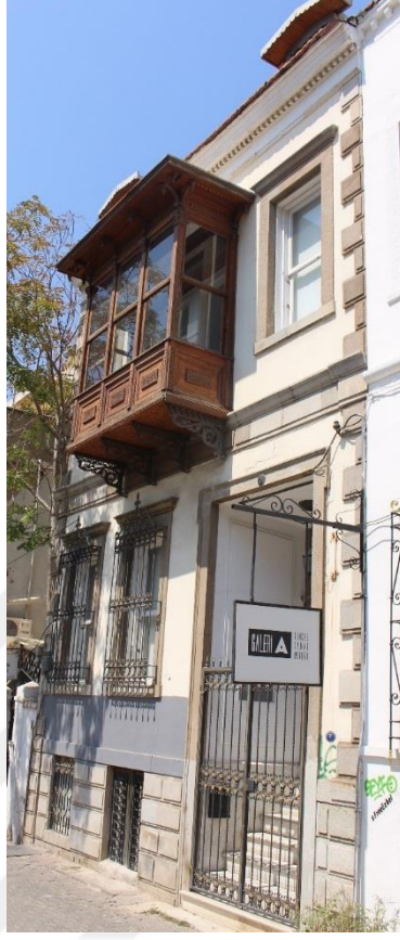
Fotoğraf 144. Alsancak Mahallesi, Enver Başar Dünder Sok., No:7, Konak adresindeki konutun genel görünüşü.
