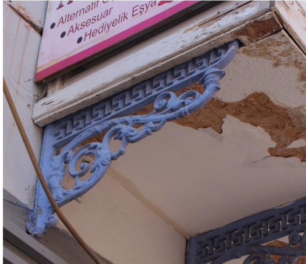
Fotoğraf 111. Alsancak Mahallesi, 1453 Sok., No:26, Konak adresindeki konutun cumba konsolu.
