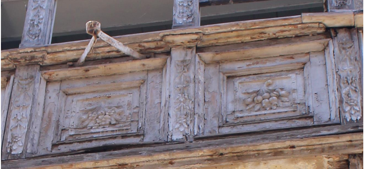
Fotoğraf 205. Kurtuluş Mahallesi, 943 Sok., No: 22-22 A, Konak adresindeki konutun cumba korkuluk panoları.
