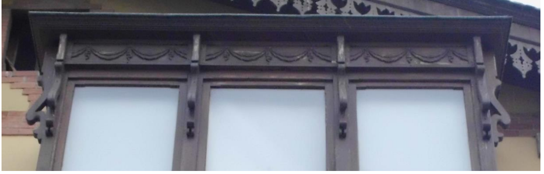
Fotoğraf 272. Donanmacı Mahallesi, Cemal Gürsel Cad., No:324, Karşıyaka adresindeki konutun cumba pencere üstü (İ.K. Ersoy Arşivinden).
