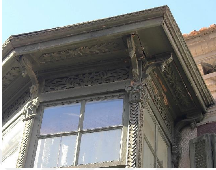
Fotoğraf 54. . Mithatpaşa Mahallesi, 211 Sok., No:10-12, Konak adresindeki konutun saçak alt yüzeyi ve pencere üstü.
