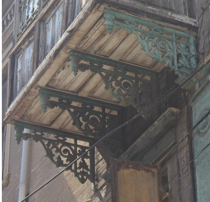
Fotoğraf 212A. Kurtuluş Mahallesi, 940 Sok, No: 4, Konak adresindeki konutun cumba konsolları.
