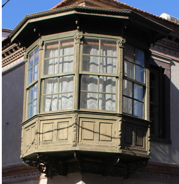
Fotoğraf 53. . Mithatpaşa Mahallesi, 211 Sok., No:10-12, Konak adresindeki konutun cumbası.
