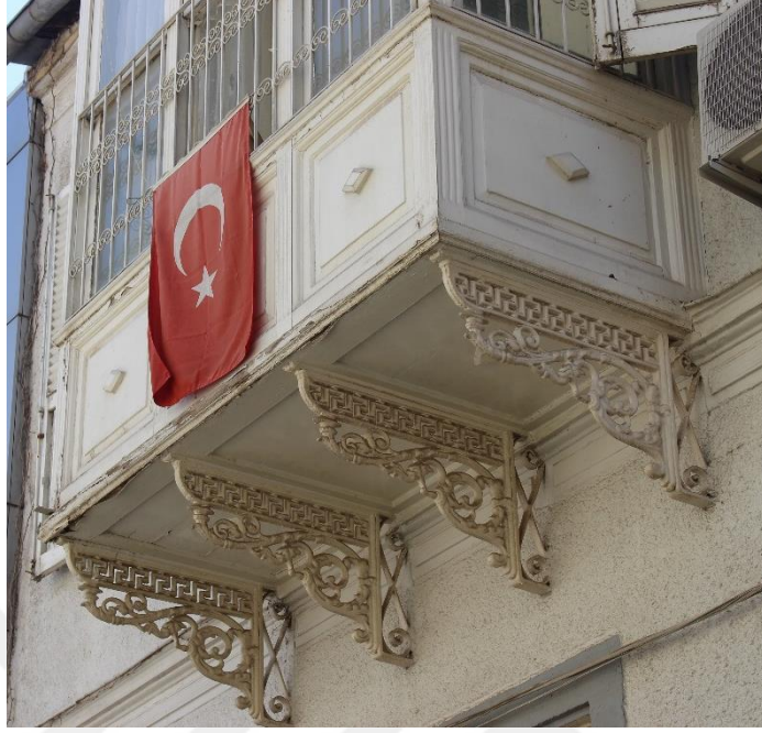
Fotoğraf 150. . Alsancak Mahallesi, 1480 Sok., No:4, Konak adresindeki konutun cumba konsolları.
