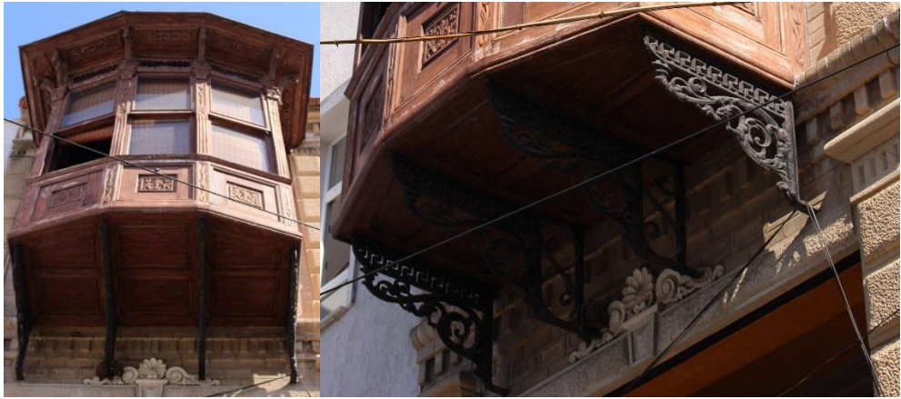
Fotoğraf 31. Çankaya Mahallesi, 141 Sok. No:37-37A, Konak adresindeki konutun cumbası ve cumba konsolları
