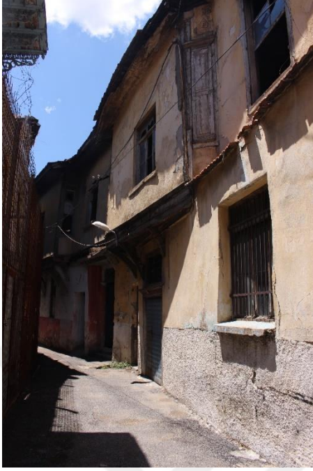
Fotoğraf 273. Pazaryeri Mahallesi, No:30, Konak adresindeki konutun genel görünüşü.
