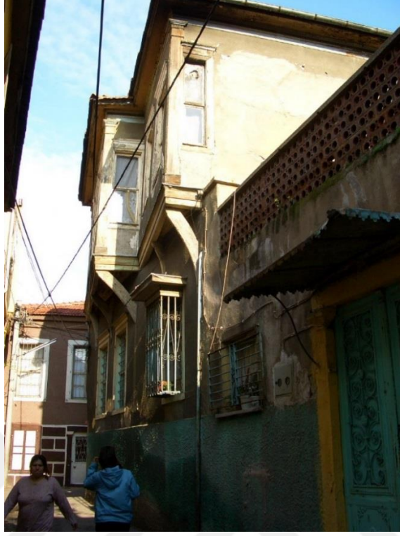
Fotoğraf 281. Altınordu Mahallesi, 966 Sokak, No:23, Konak adresindeki konutun genel görünüşü (A. Uçar Arşivinden).
