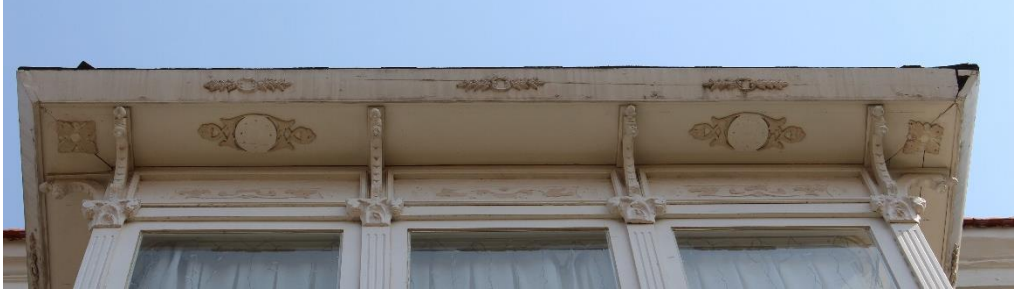
Fotoğraf 242. Dumlupınar Mahallesi, Barış Manço Sok., No:9. Buca adresindeki. konutun cumba saçak alt yüzeyi.
