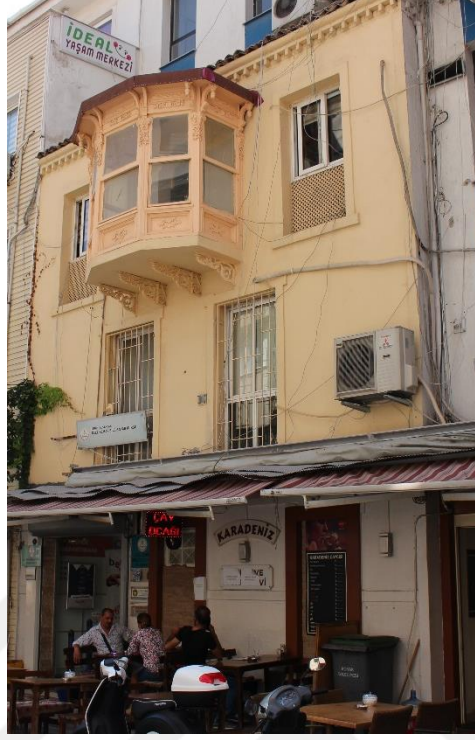
Fotoğraf 164. Alsancak Mahallesi, 1462 Sok.( Yüzbaşı Şerafettin Bey Sok.), No:2, Konak adresindeki konutun genel görünüşü.
