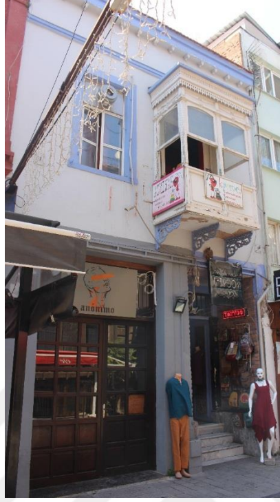
Fotoğraf 108. Alsancak Mahallesi, 1453 Sok., No:26, Konak adresindeki konutun genel görünüşü.
