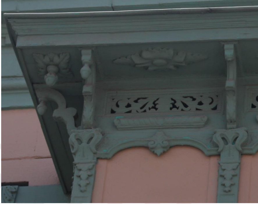
Fotoğraf 98A. Alsancak Mahallesi, 1453 Sok., No:18, Konak adresindeki konutun cumba saçak alt yüzeyi ve pencere üstü.
