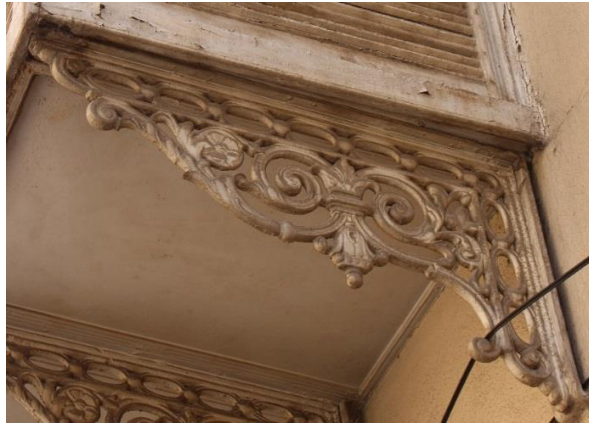
Fotoğraf 78. Alsancak Mahallesi, Cumhuriyet Bul., No:244, Konak adresindeki konutun cumba konsol detayı.
