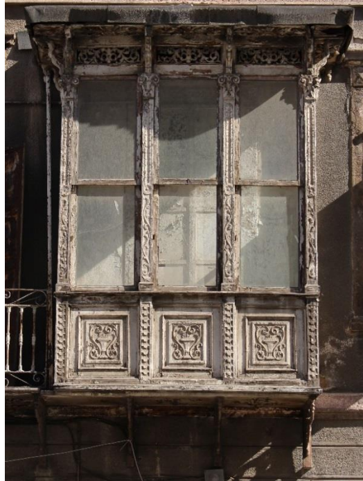
Fotoğraf 48. Mithatpaşa Mahallesi, Mithatpaşa Cad., No:2- 2 A, Konak adresindeki konutun ön cephede yer alan cumbası.
