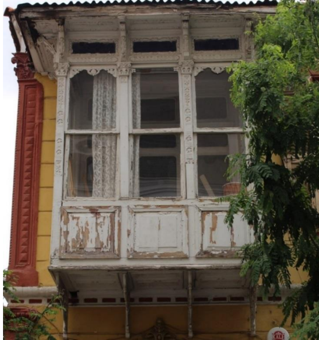
Fotoğraf 6. Güzelyalı Mahallesi, 59 Sok., No:17, Konak adresindeki konutun cumbası.
