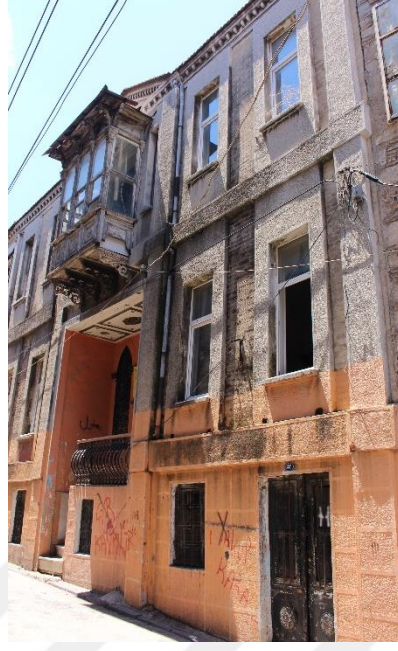
Fotoğraf 202. Kurtuluş Mahallesi, 943 Sok., No: 22-22 A, Konak adresindeki konutun genel görünüşü.
