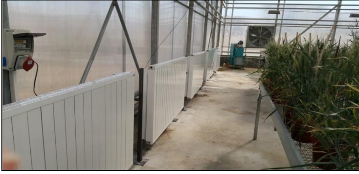
Şekil 3.12. Uygulama Serası Isıtma Radyatörleri
